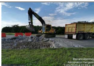
Foto No. 4 7/05/2020 Retiro de material proveniente de la demolición de placas de concreto.
