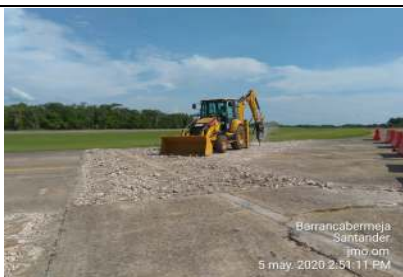
Foto No. 1 5/05/2020 Demolicion de Placas de concreto en la calle de rodaje charlie
