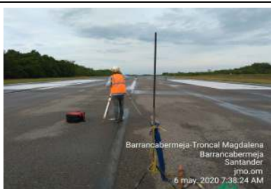
Foto No. 3 6/05/2020 Realización de cuadrícula para la toma de secciones y volúmenes del material de fresado
