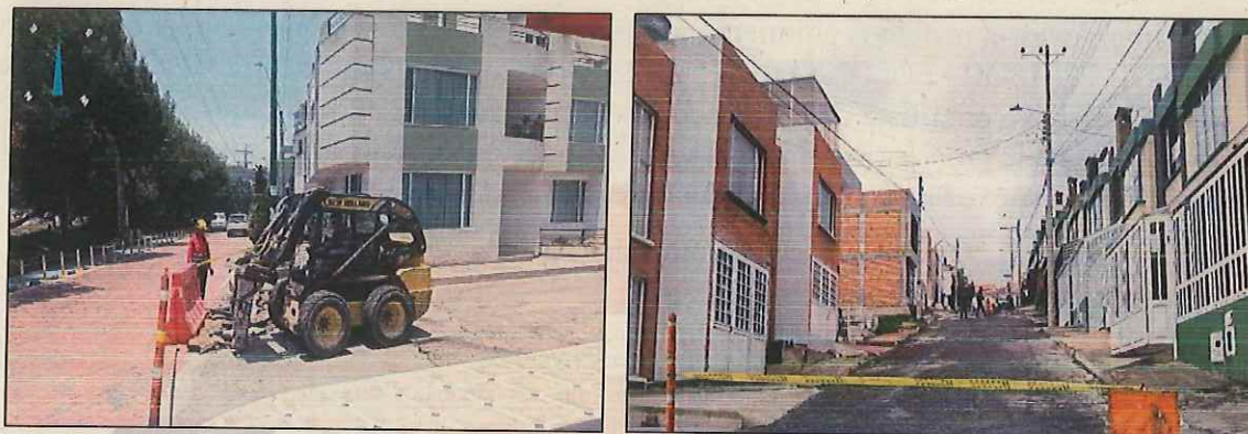
Ilustración 15. Señalización de las áreas de trabajo
