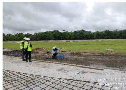
Foto No. 9 06/06/2020 Toma de densidades en campo de la capa de sub-base de la calle de rodaje charlie. _____ _____ _____
