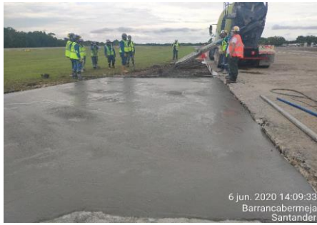
Foto No. 7 06/06/2020 Fundicion de las placas de concreto en la calle de rodaje charlie. _____ _____ _____
