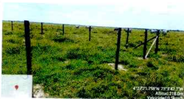
Figura 217. Verificación Aislamiento Instalado
