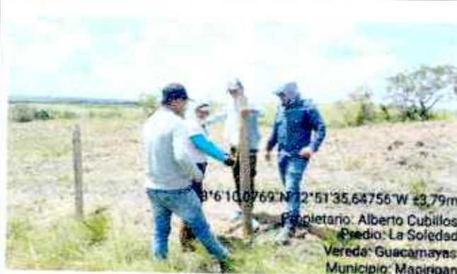
Figura 92. Verificación Aislamiento Instalado
