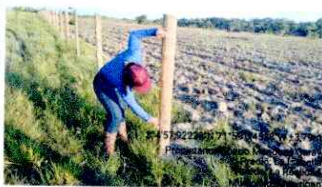
Figura 17. Verificación Aislamiento Instalado.
