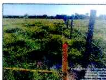
figura 64 Verificación de la instalación del aislamiento
