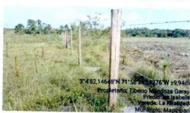
Figura 38. Verificación Aislamiento Instalado
