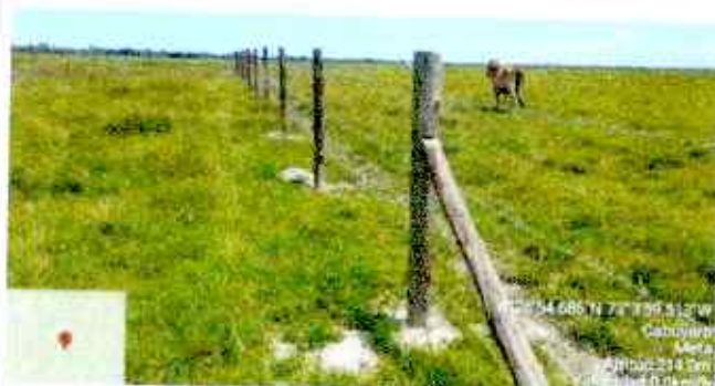
Figura 241. Verificación Aislamiento Instalado
