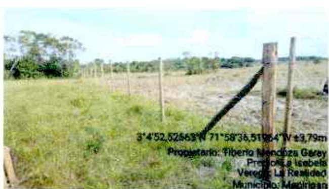
Figura 47. Verificación Aislamiento Instalado
