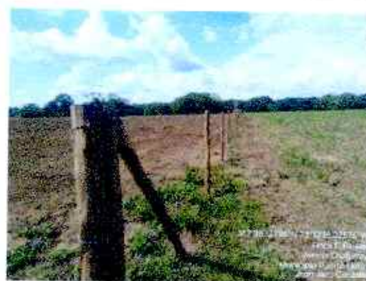
Figura 346. Verificación Aislamiento Instalado
