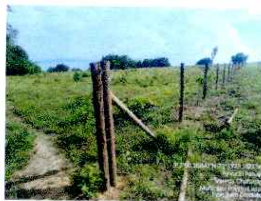
Figura 324 Verificación Aislamiento Instalado
