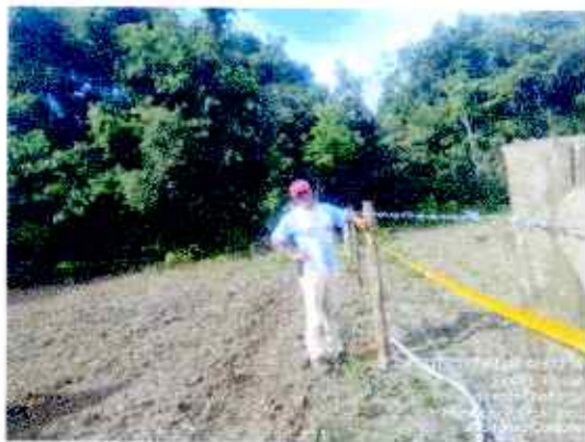
Figura 327. Verificación Aislamiento Instalado
