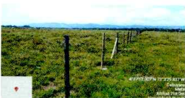
Figura 216. Verificación Aislamiento Instalado
