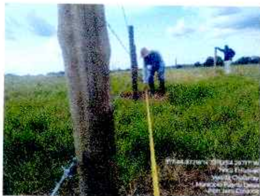
Figura 307. Verificación Aislamiento Instalado.
