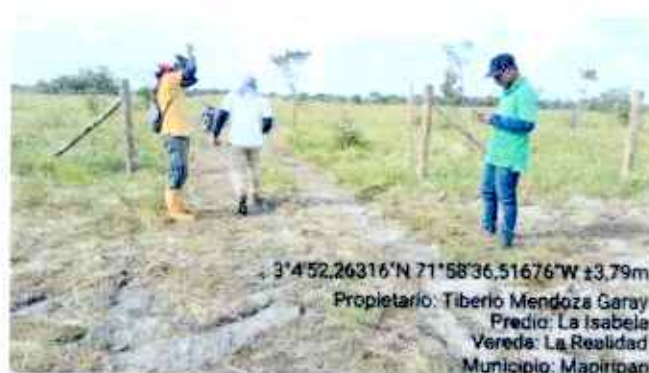
Figura 44. Verificación Aislamiento Instalado
