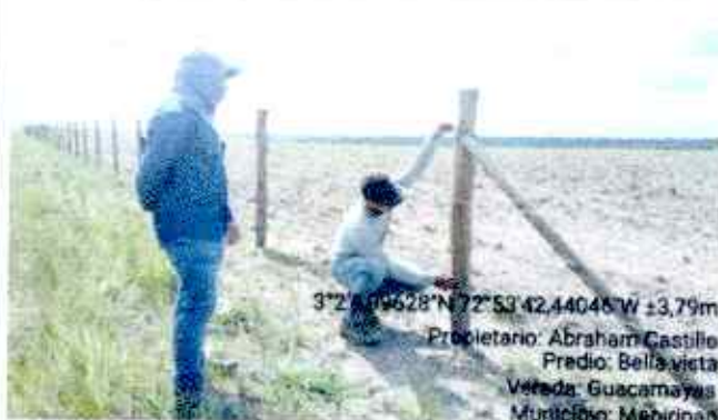
Figura 60. Verificación Aislamiento Instalado
