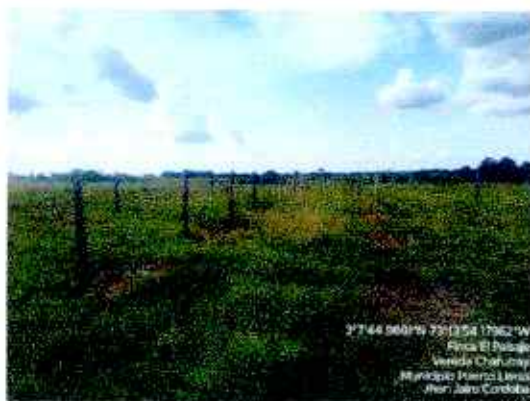
Figura 306. Verificación Aislamiento Instalado
