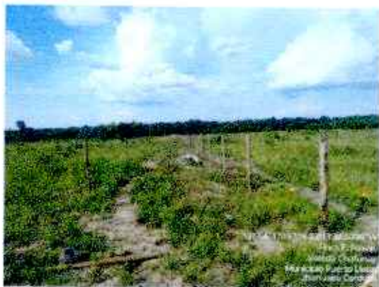
Figura 325. Verificación Aislamiento Instalado
