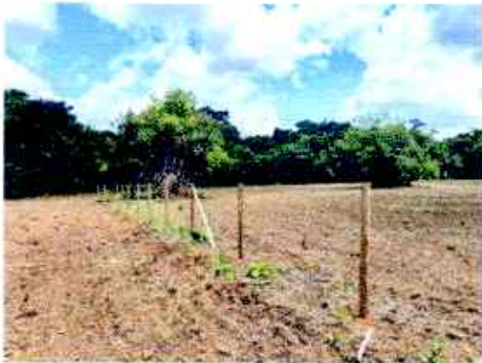
Figura 265. Verificación Aislamiento Instalado
