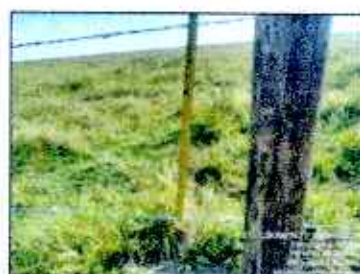
figura 62 Verificación de la instalación del aislamiento
