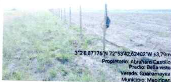
Figura 63. Verificación Aislamiento Instalado
