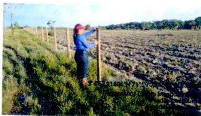
Figura 15. Verificación Aislamiento Instalado
