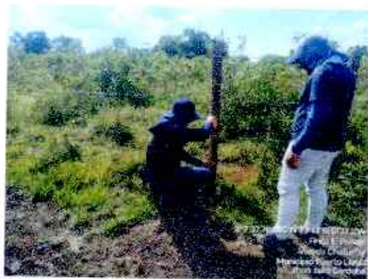
Figura 343. Verificación Aislamiento Instalado
