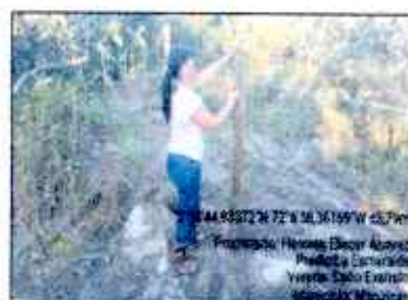
figura 60 Verificación de la instalación del aislamiento
