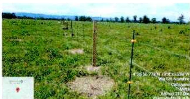
Figura 257. Verificación Aislamiento Instalado
