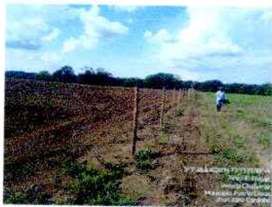
Figura 319 Verificación Aislamiento Instalado
