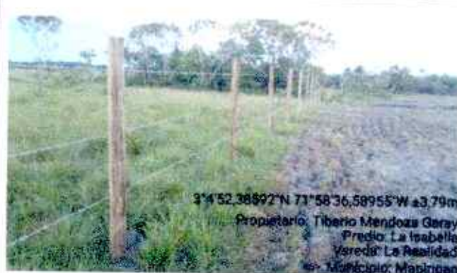
Figura 4 Verificación Aislamiento Instalado
