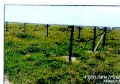
figura 21 Verificación de la instalación del aislamiento
