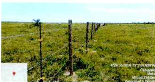
Figura 228 Verificación Aislamiento Instalado
