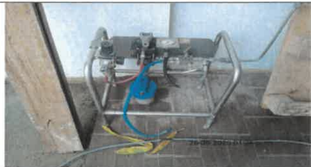
Foto No. 54. Se revisó y verificó equipo bomba ensayo de presión tubería red contra incendio, en el frente de obra IMPRENTA DISTRITAL
