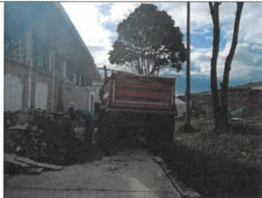
Foto No. 106. Se revisó y verificó el retiro de residuos de construcción y demolición, sede IMPRENTA DISTRITAL.
