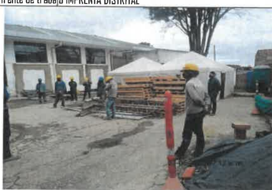
Foto No. 48. Se revisó y verificó el acopio temporal de madera, en el frente de trabajo IMPRENTA DISTRITAL
