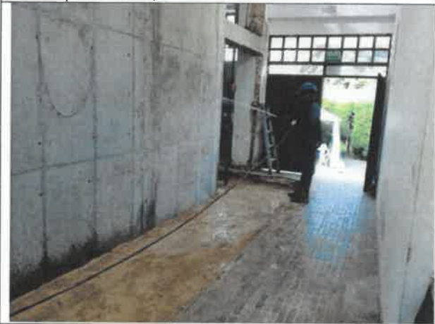
Foto No. 159. Se revisa y verifica el cumplimiento de la hidratación del recebo para su compactación en el área de producción, sede IMPRENTA DISTRITAL
