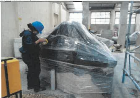
Foto No. 139. Se revisa y verifica que se cumpla con el mantenimiento de la protección de los equipos de la zona de producción de la sede IMPRENTA DISTRITAL.
