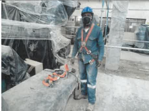
Foto No. 111. Se revisa y verifica los elementos de protección personal (EPP) Y bioseguridad covid-19 para la realización de actividades al personal de obra sede IMPRENTA DISTRITAL.
