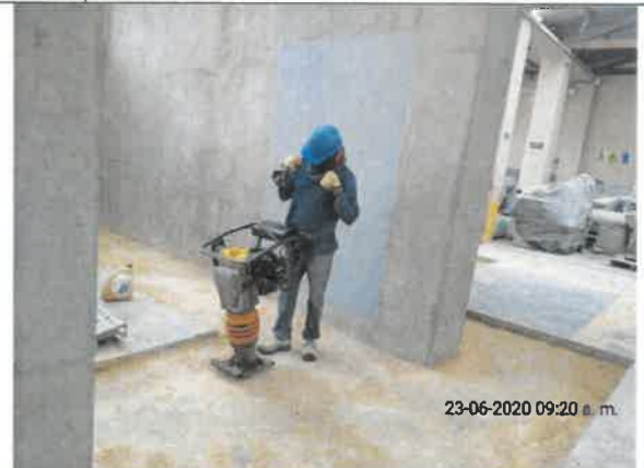
Foto No. 9. EL CONTRATISTA CONSORCIO PRUNI SEDES 04 utilizo CANGURO para realizar relleno compactado con recebo B400 en excavaciones de la cimentación ubicadas en el área de producción y de esta manera conformar la rasante de la placa de contrapiso afectada por la intervención del reforzamiento estructural de la cimentación( zapatas y vigas de cimentación).
