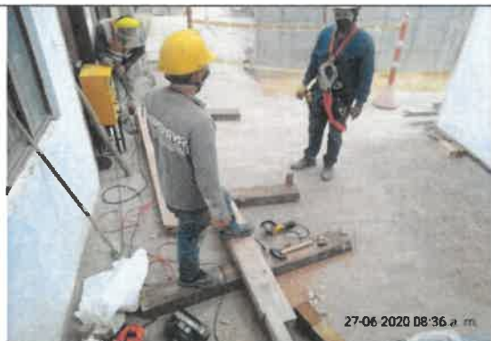
Foto No. 16. EL CONTRATISTA DE OBRA CONSORCIO PRUNI SEDES 04 utilizo PULIDORA para realizar los diferentes cortes de los pernos y platinas que soportan las juntas de las vigas en madera de las cerchas en madera.
