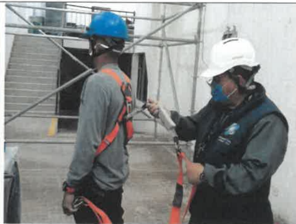
Foto No. 158. Se revisa y verifica las condiciones de seguridad de los equipos de trabajo en alturas, sede IMPRENTA DISTRITAL
