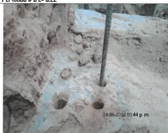
Foto No 33. La INTERVENTORIA ARQUITECTURA URBANA LTDA revisa y verifica que el contratista CONSORCIO PRUNI SEDES 04 realice la perforación para realizar anclajes numero 6 (3/4") de Long de 0.22m
