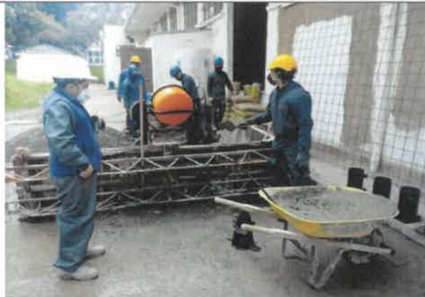
Foto No. 113 Se revisa y verifica que se estén realizando las pruebas de asentamiento concreto o cono slump, sede IMPRENTA DISTRITAL.
