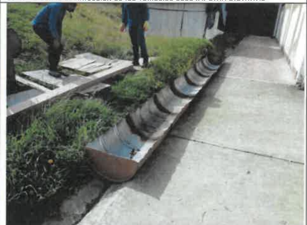
Foto No. 148. Se revisa y verifica los utensilios que se utilizaran para la inmunizada de la madera, sede IMPRENTA DISTRITAL.
