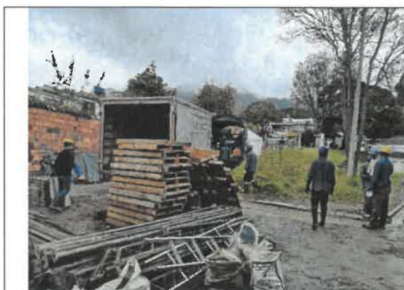
Foto No. 131. Se revisa y verifica el retiro de material (Formaleta), sede IMPRENTA DISTRITAL.
