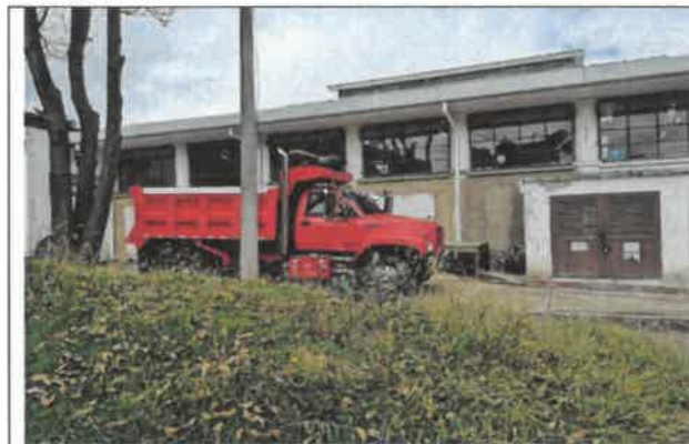
Foto No. 49. Se revisó y verificó el ingreso de voluta para disposición de residuos de construcción y demolición, en el frente de obra IMPRENTA DISTRITAL
