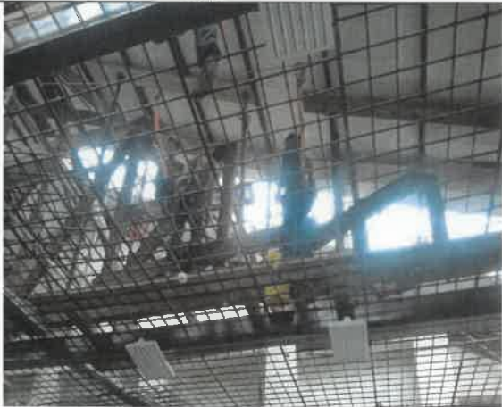
Foto No. 173. Se revisa y verifica los trabajos de alturas que se están realizando en la cercha 13 sede IMPRENTA DISTRITAL.
