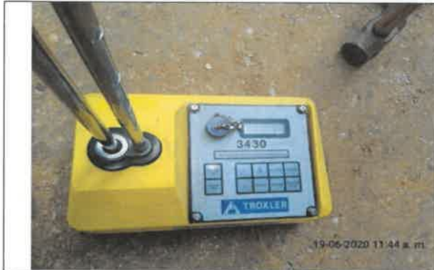
Foto No 31. La interventoría ARQUITECTURA URBANA LTDA revisa y verifica el procedimiento del ensayo de densidades del relleno B400 ejecutado para estructura placa de contrapiso zona de producción.
