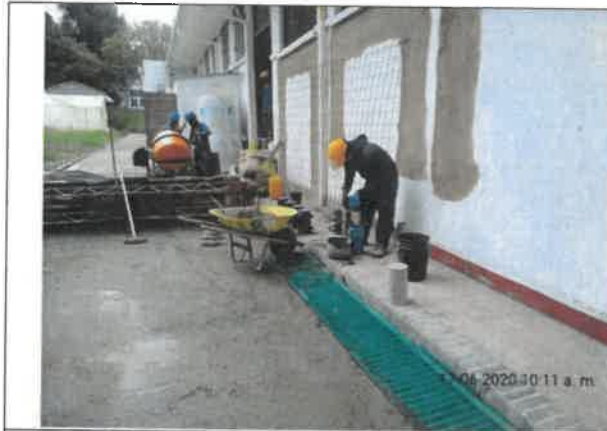
Foto No 23. La interventoría ARQUITECTURA URBANA LTDA se realizó el ensayo según la norma NTC 673 llenado el cono en 3 capas a cada una se le aplican 25 punzones, y posteriormente después de 24 horas de fraguado se desencofraron y se sumergieron en una caneca con agua para garantizar su curado y fraguado óptimo lo cual se debe dejar sumergido hasta la fecha de la toma del ensayo.
