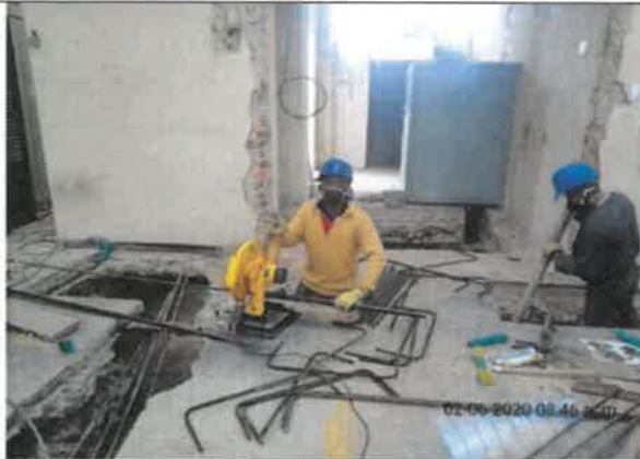
Foto No.3. TRONZADORA Se utilizó para realizar los cortes de acero de refuerzo para los diferentes elementos estructurales como zapatas, muros, columnas, columnetas y viga cinta de confinamiento ubicadas en el área de producción.
