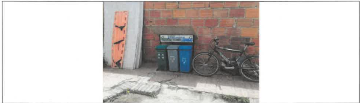
Foto No. 62. Se revisó y verificó que los residuos sólidos generados son depositados en las bolsas acorde a su color (Tipo de residuo), para ser entregados a la empresa prestadora del servicio de aseo, frente de obra IMPRENTA DISTRITAL
