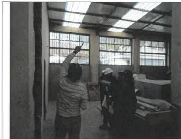
Foto No. 143 Se revisa y verifica el cumplimiento de las medidas de seguridad industrial para mitigar el riesgo locativo en las instalaciones, sede IMPRENTA DISTRITAL
