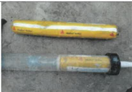
Foto No. 119... Se revisa y verifica el material utilizado para la reparación. SIKAFLEX -1º PLUS
