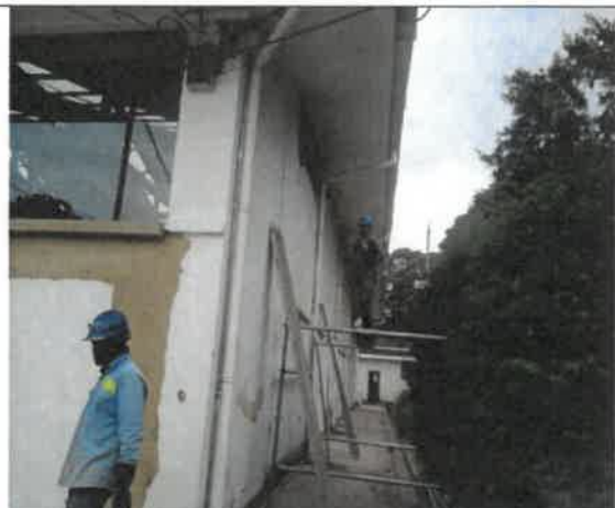
Foto No. 8. EL CONTRATISTA CONSORCIO PRUNI SEDES 04 utilizo ANDAMIO CERTIFICADO para realizar pañete en vigas aéreas y refrozamiento estructura en madera.
