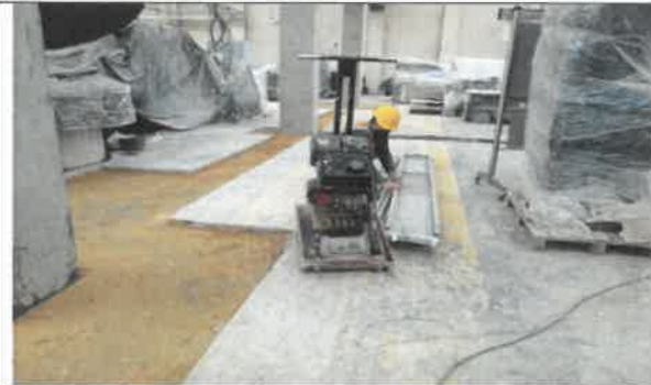
Foto No. 51. Se revisó y verificó equipo rana, en el frente de obra IMPRENTA DISTRITAL
