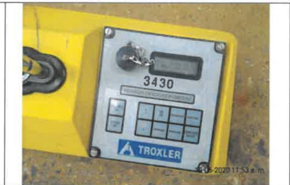
Foto No 32. La interventoría ARQUITECTURA URBANA LTDA revisa y verifica el procedimiento del ensayo de densidades del relleno B400 ejecutado para estructura placa de contrapiso zona de producción.
