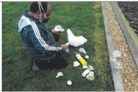
Foto No. 120... Se revisa y verifica el material utilizado para la reparación. SIKAFLEX -1º PLUS, para los rociadores de los espejos de agua En la sede CENTRO DE MEMORIA PAZ Y RECONCILIACION
