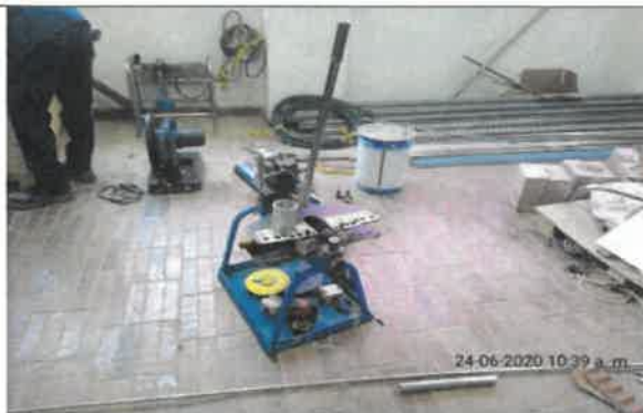
Foto No. 11. EL CONTRATISTA CONSORCIO PRUNI SEDES 04 utilizo DOBLADORA DE TUBERIA para realizar las diferentes ramales y distribucion de la red del componente SUMINISTRO SISTEMA EPU 05 IMPRENTA DISTRITAL EDIFICIO I.
