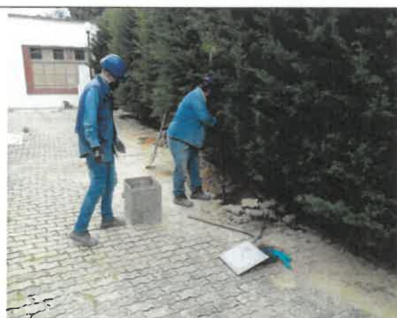
Foto No. 162. Se revisa y verifica instalación de la caja de inspección de la maya eléctrica, sede IMPRENTA DISTRITAL.
