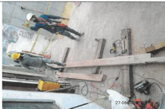
Foto No. 15. EL CONTRATISTA DE OBRA CONSORCIO PRUNI SEDES 04 utilizo CIERRA CIRCULAR para realizar los diferentes cortes en las viigas de madera utilizadas en el cambio de elementos en madera de las cerchas que componen la estructura en madera de la cubierta del area de produccion.
