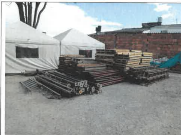
Foto No. 157. Se revisa y verifica el almacenamiento de los equipos de obra (camillas, parales cerchas) de la sede IMPRENTA DISTRITAL
