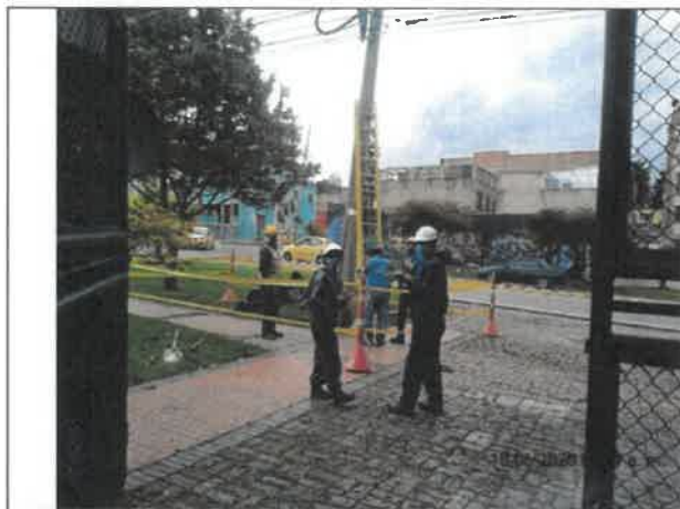
Foto No. 125. Se revisa y verifica la actividad de acometida eléctrica, parte del contratista CONSORCIO PRUNI SEDES, sede IMPRENTA DISTRITAL.
