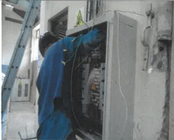
Foto No. 171. Se revisa y verifica la instalación del cableado en la caja de los Breaker, sede IMPRENTA DISTRITAL.
