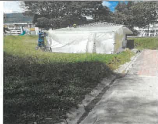
Foto No. 104. Se revisó y verificó la ejecución del mejoramiento de la zona de aislamiento, sede IMPRENTA DISTRITAL.
