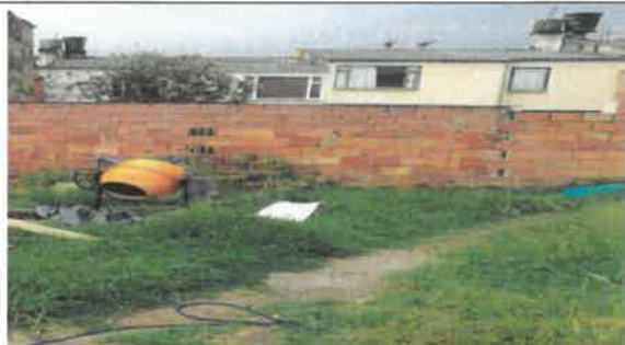
Foto No. 56. Se revisó y verificó equipo trompo mezclador, en el frente de obra IMPRENTA DISTRITAL
