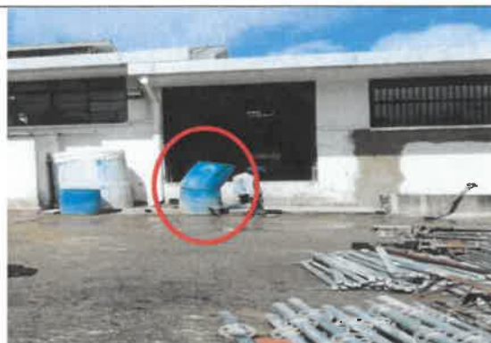
Foto No. 60. Se revisó y verificó el uso de canecas de almacenamiento de agua, frente de obra IMPRENTA DISTRITAL
