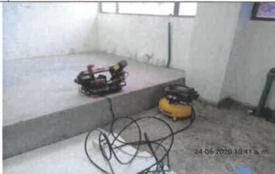
Foto No. 13 EL CONTRATISTA CONSORCIO PRUNI SEDES 04 utilizo CORTADORA Y COMPRESOR para trabajos de instalacion de tuberia en acero inoxidable del componente SUMINISTRO SISTEMA EPU 05 IMPRENTA DISTRITAL EDIFICIO I.
