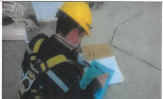
Foto No. 165. Se revisa y verifica el equipo utilizado para doblar la tubería sede IMPRENTA DISTRITAL.
