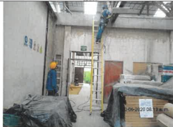
Foto No. 4. EL CONTRATISTA CONSORCIO PRUNI SEDES 04 utilizó ESCALERA para realizar la instalación de tubería EMT de " " para circuitos de alumbrado del área administrativa.
