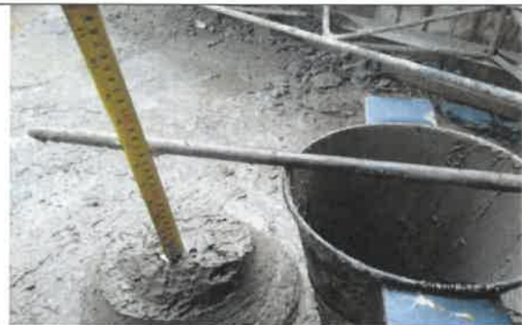
Foto No 22. La INTERVENTORIA ARQUITECTURA URBANA LTDA se realizado el ensayo se procede a realizar la lectura donde dio 7.2 pulgadas aprobando su vaciado debido que en el diseño de mezcla su dosificación exige 6.5 pulgadas con un margen de más o menos una pulgada 1(+/-1").
