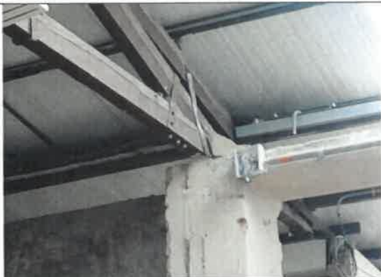
Foto No. 137. Se revisó y verificó los elementos expuesto no se afecten para su reforzamiento, sede IMPRENTA DISTRITAL.
