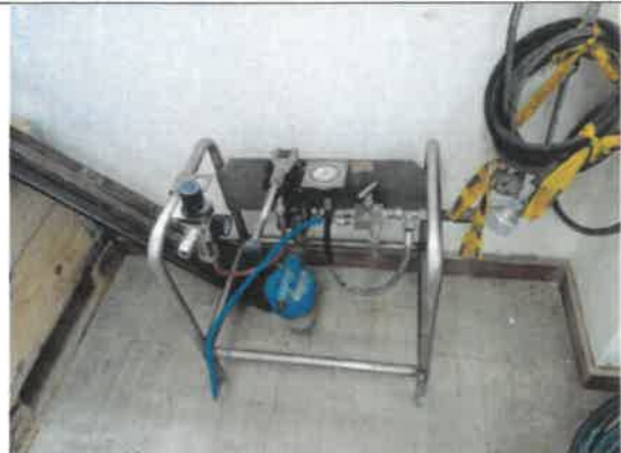
Foto No. 152 Se revisa y verifica las condiciones de seguridad industrial de los equipos utilizado para el doblado de la tubería, sede IMPRENTA DISTRITAL.
