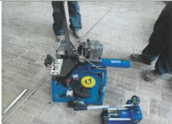
Foto No. 151. Se revisa y verifica las condiciones de seguridad industrial de los equipos utilizado para el doblado de la tubería, sede IMPRENTA DISTRITAL.
