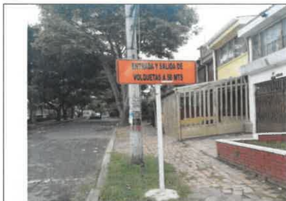
Foto No. 74. Se revisó y verificó la instalación de la señalización de la SEDE IMPRENTA DISTRITAL de acuerdo al plan de manejo de tráfico ubicada en la carrera 19 B No. 24-86
