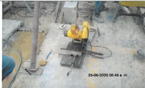
Foto No. 52. Se revisó y verificó el equipo tronadora a. en el frente de obra IMPRENTA DISTRITAL
