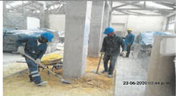
Foto No. 55. Se revisó y verificó equipo pala y pica, en el frente de obra IMPRENTA DISTRITAL
