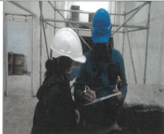
Foto No. 172. Se revisa y verifica la firma de los permisos de trabajo en alturas sede IMPRENTA DISTRITAL.
