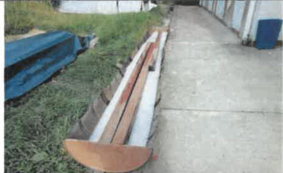
Foto No. 154 Se revisa y verifica, el cumpla con las medidas de seguridad industrial, para la inmunización de la madera de la sede IMPRENTA DISTRITAL.
