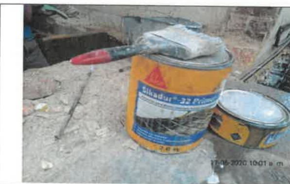
Foto No 25. La interventoría ARQUITECTURA URBANA LTDA revisa y verifica el producto SIKA DUR 32 este en buen estado para su aplicación.
