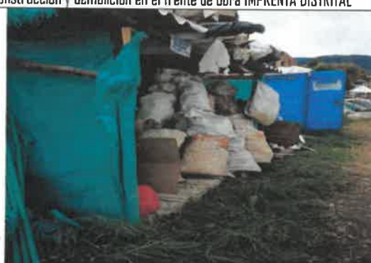
Foto No.46. Se revisó y verificó el embalaje temporal de residuos peligrosos (Bolsas de cemento), para ser llevados a disposición final, en el frente de trabajo IMPRENTA DISTRITAL
