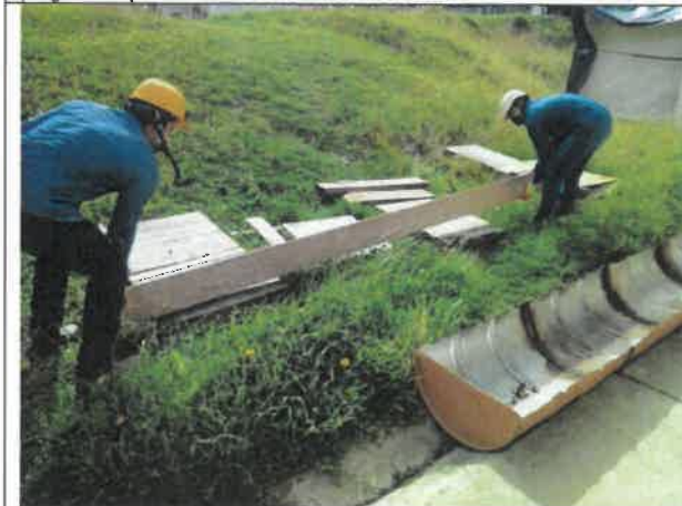
Foto No. 147. Se revisa y verifica los elementos de madera que se utilizara para el cambio de piezas de la estructura de la cubierta sede IMPRENTA DISTRITAL.
