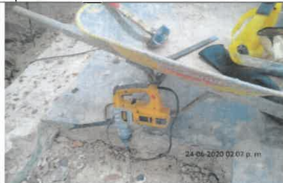
Foto No. 14. EL CONTRATISTA DE OBRA CONSORCIO PRUNI SEDES 04 utilizo TALADRO PERCUTOR para realizar perforaciones para anclajes de columnetas.
