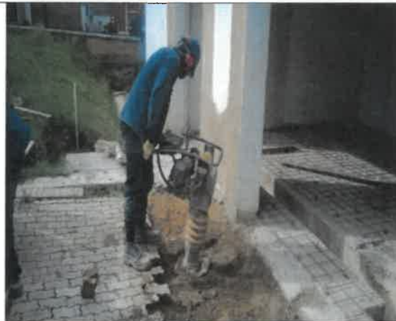
Foto No. 174. Se revisa y verifica la utilización de los elementos de protección personal, para compactar el material de afinado B-400 zona subestación sede IMPRENTA DISTRITAL.
