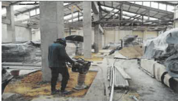
Foto No. 53. Se revisó y verificó equipo canguro, en el frente de obra IMPRENTA DISTRITAL
