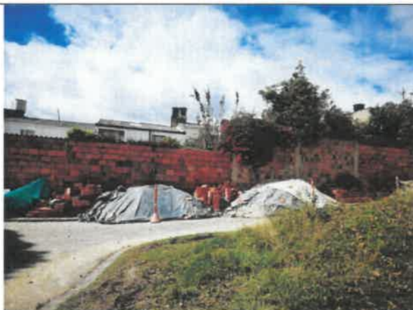
Foto No. 59. Se revisó y verificó la implementación de la medida de cubrimiento acopio de material pétreo (B-400 Y ARENA), frente de obra IMPRENTA DISTRITAL
