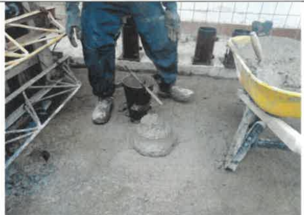
Foto No. 114 Se revisa y verifica que se estén realizando las pruebas de asentamiento concreto o cono slump, sede IMPRENTA DISTRITAL.
