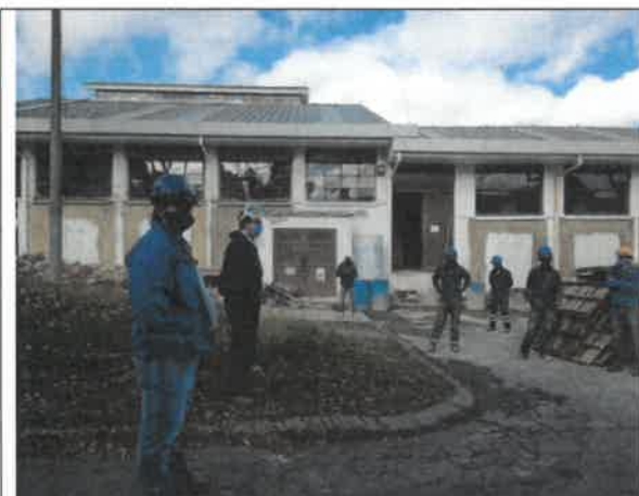
Foto No. 86. Se revisó y verificó la capacitación de inducción al personal nuevo, frente de obra IMPRESA DISTRITAL
