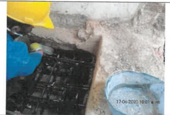
Foto No 26. La INTERVENTORIA ARQUITECTURA URBANA LTDA revisa y verifica que el contratista de obra realice la aplicación del producto SIKA DUR 32 en concreto viejo para unir concreto nuevo
