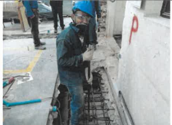
Foto No. 112. Se revisa y verifica los elementos de protección personal (EPP) Y bioseguridad covid-19 para la realización de actividades al personal de obra sede IMPRENTA DISTRITAL.
