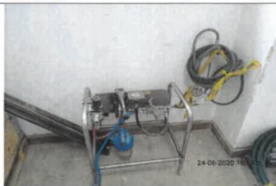
Foto No. 12. BOMBA MECANICA se utilizó para realizar la prueba de presión a la red de distribución en tubería en acero inoxidable 20m,16m y 12 mm del componente SUMINISTRO SISTEMA EPU 05 IMPRENTA DISTRITAL EDIFICIO I
