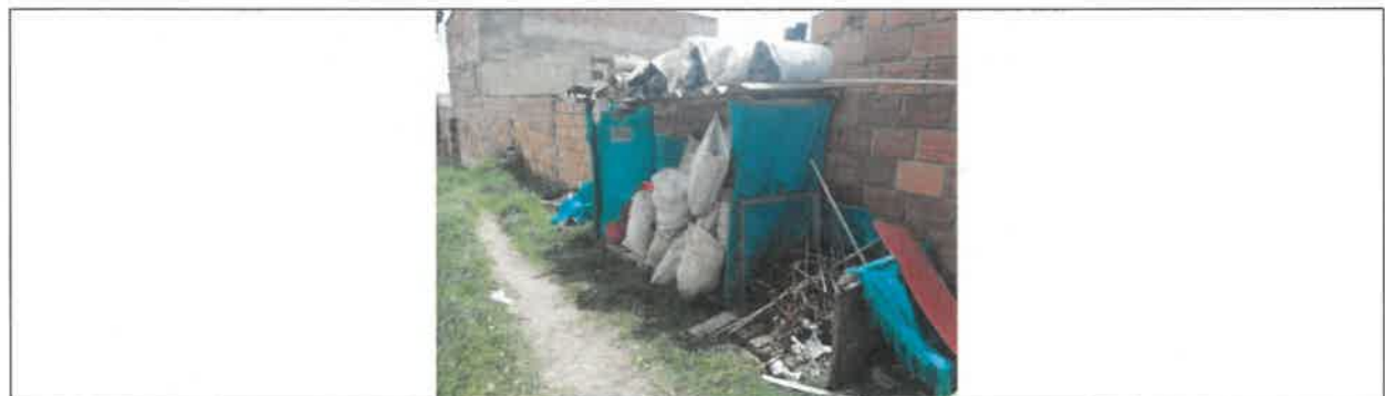
Foto No. 63. Se revisó y verificó el punto de acopio de residuos peligrosos embalados en lonas, frente de obra IMPRENTA DISTRITAL
