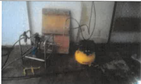
Foto No. 163. Se revisa y verifica las pruebas de presión de la red contra incendios sede IMPRENTA DISTRITAL.
