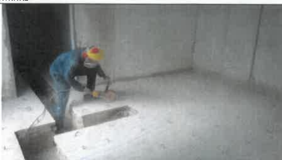
Foto No. 168. Se revisa y verifica la utilización de los elementos de protección personal, para rallado de la placa zona subestación sede IMPRENTA DISTRITAL.
