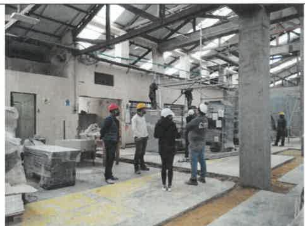
Foto No. 87. Se revisó y verificó la capacitación de inducción al personal nuevo, frente de obra IMPRESA DISTRITAL
