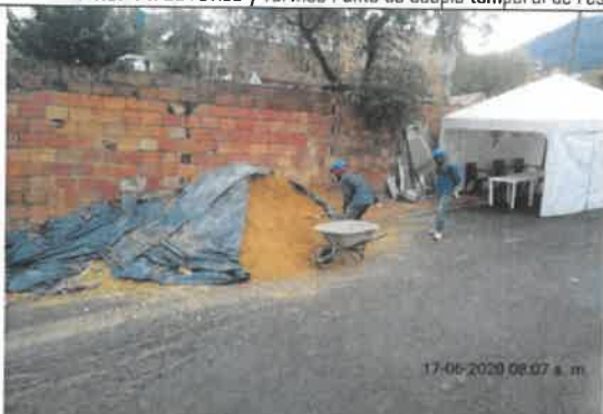
Foto No. 45. Se revisó y verificó el cerramiento del acopio temporal de Material pétreo en el frente de trabajo IMPRENTA DISTRITAL
