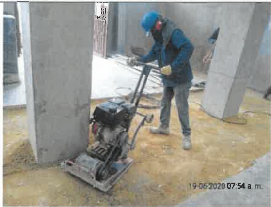
Foto No. 10. EL CONTRATISTA CONSORCIO PRUNI SEDES 04 utilizo RANA para realizar relleno compactado con recebo B400 en excavaciones de la cimentación ubicadas en el área de producción y de esta manera conformar la rasante de la placa de contrapiso afectada por la intervención del reforzamiento estructural de la cimentación( zapatas y vigas de cimentación).
