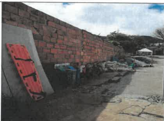
Foto No. 47. Se revisó y verificó el cerramiento del acopio temporal de Material plástico (PVC) en el frente de trabajo IMPRENTA DISTRITAL
