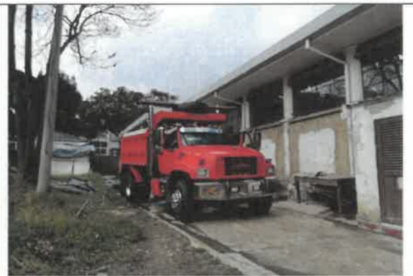
Foto No. 50. Se revisó y verificó el ingreso de voluta para disposición de residuos de construcción y demolición, en el frente de obra IMPRENTA DISTRITAL
