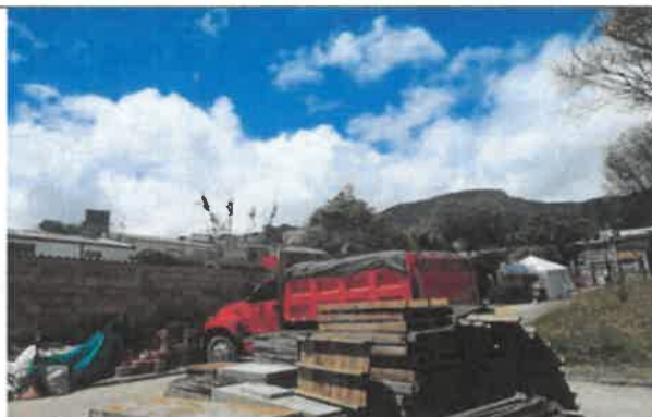
Foto No. 65. Se revisó y verificó salida de volquetas, con su respectivo cubrimiento de residuos de construcción y demolición, así como las llantas de las mismas se encuentran sin residuos de la actividad de trasiego, frente de obra IMPRENTA DISTRITAL
