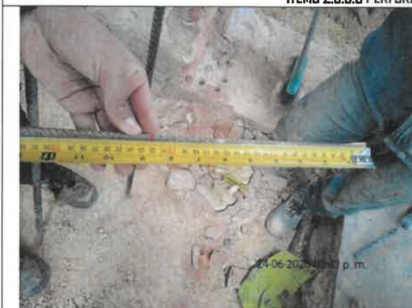
Foto No 32. La INTERVENTORIA ARQUITECTURA URBANA LTDA revisa y verifica que el contratista CONSORCIO PRUNI SEDES 04 realice la perforación para realizar anclajes numero 6 (3/4") de Long de 0.22m
