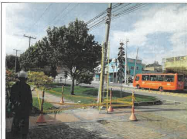
Foto No. 149. Se revisa y verifica que se realice la señalización en el área de trabajo zona peatonal., sede IMPRENTA DISTRITAL.
