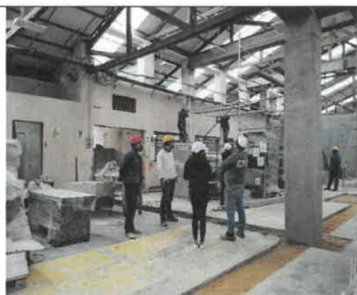
Foto No. 132. Se revisa y verifica que el personal del contratista de obra use los elementos de protección personal (Casco de seguridad, botas de seguridad y tapabocas), sede IMPRENTA DISTRITAL.
