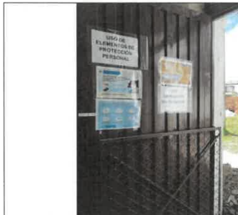
Foto No. 70. Se revisó y verificó la implementación la señalización de COVID-19 para el personal en el frente de obra IMPRENTA DISTRITAL
