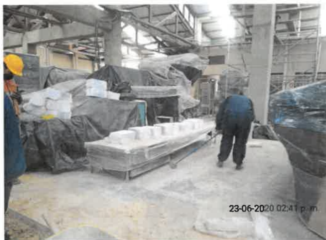
FOTO No 29: La interventoría ARQUITECTURA URBANA LTDA revisa y verifica que el contratista de obra CONSORCIO PRUNI SEDES 04 realice la actividad de aseo general en el área de producción.
