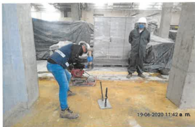
FOTO No 23: La interventoría ARQUITECTURA URBANA LTDA revisa y verifica que el contratista CONSORCIO PRUNI SEDES 04 realice el ensayo de densidad del material afirmado B400 para garantizar el proctor exigido del 95% de acuerdo a las especificaciones técnicas del proyecto.
