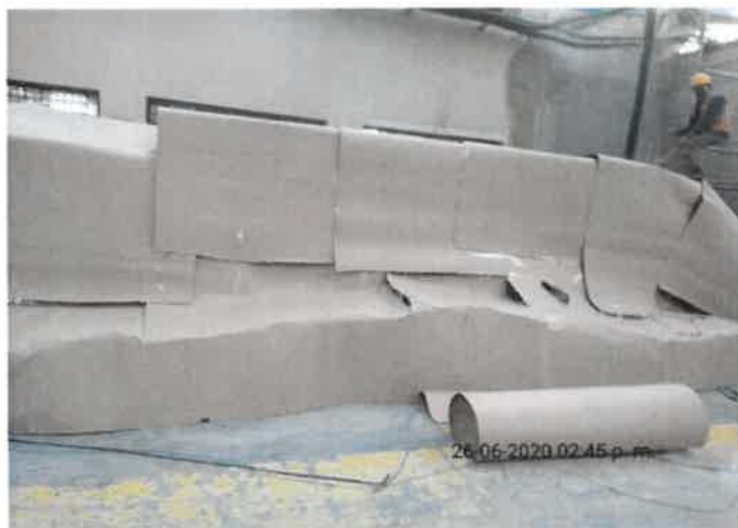
FOTO No 51: La interventoría ARQUITECTURA URBANA LTDA revisa y verifica que el contratista CONSORCIO PRUNI SEDES 04 realice la reparación del embalaje de las máquinas de impresión de la sede imprenta distrital ubicadas en el área de producción.
