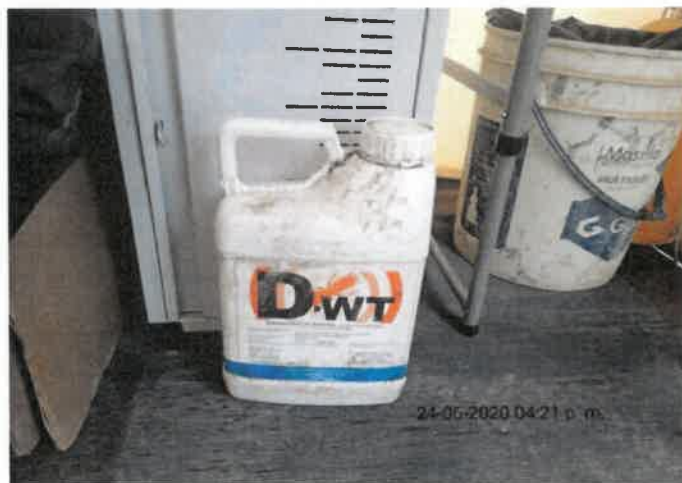
FOTO No 43: La interventoría ARQUITECTURA URBANA LTDA revisa y verifica que el contratista CONSORCIO PRUNI SEDES 04 utilice el inmunizante de madera DWT aprobado por la interventoría para realizar el proceso de inmunización de las vigas en madera de abarco las cuales van a remplazar ya que están afectadas por gorgojo y son referenciadas para cambio exigidos mediante los planos de diseño RE 23 y RE24 que componen la estructura en madera de la cubierta del área de producción.
