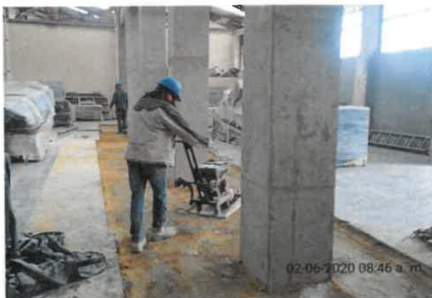
FOTO No 3: La interventoría ARQUITECTURA URBANA LTDA revisa y verifica que el contratista CONSORCIO PRUNI SEDES 04 realice relleno en recebo B400 en áreas intervenidas para el reforzamiento estructural de la cimentación (zapatas y vigas de cimentación) del área de producción revisa y verifica la compactación mecánica mediante el equipo RANA.
