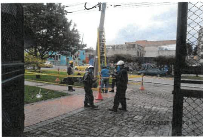
FOTO No 19: La interventoría ARQUITECTURA URBANA LTDA revisa y verifica que el contratista CONSORCIO PRUNI SEDES 04 realice la actividad de suministro e instalación de tubería MIC de 6" x 6 Mts incluye unión, curva, y cinta acero inoxidable vandy 3/4 " para remplazo de afloramiento existente, incluye retiro de tubería de 3 ".
