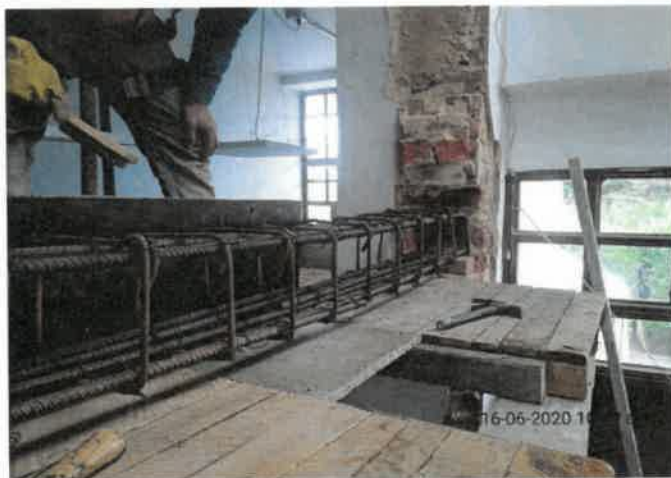
FOTO No 7: La interventoría ARQUITECTURA URBANA LTDA revisa y verifica que el contratista CONSORCIO PRUNI SEDES 04 realice amarre de acero de refuerzo de 6000 PSI en viga aérea VG-3 la cual está conformada por seis varillas N°6(3/4") y flejes N°3 (3/8") cada 15 cm.
