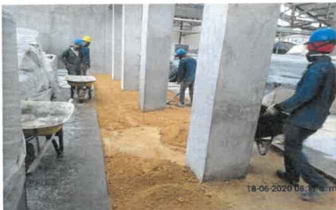
FOTO No 17: La interventoría ARQUITECTURA URBANA LTDA revisa y verifica que el contratista de obra CONSORCIO PRUNI SEDES 04 continúe con la compactación de recepto B400 en áreas intervenidas por el reforzamiento estructural de la cimentación en el área de producción.
