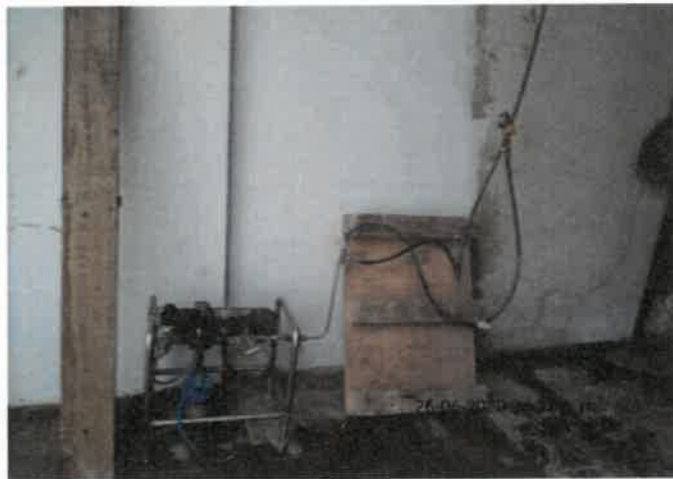
FOTO No 54: La interventoría ARQUITECTURA URBANA LTDA revisa y verifica que el contratista CONSORCIO PRUNI SEDES D4 realice la prueba de presión a la red de distribución del sistema contraincendios de la planta del primer nivel área administrativa
