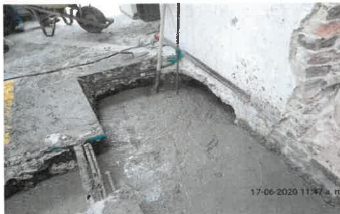
FOTO No 18: La interventoría ARQUITECTURA URBANA LTDA revisa y verifica que el contratista de obra CONSORCIO PRUNI SEDES 04 realice el vaciado de concreto de 4000 psi en la zapata Z-4, zapata Z-6 y viga de cimentación Eje Q entre Ejes de 3 y 5.
