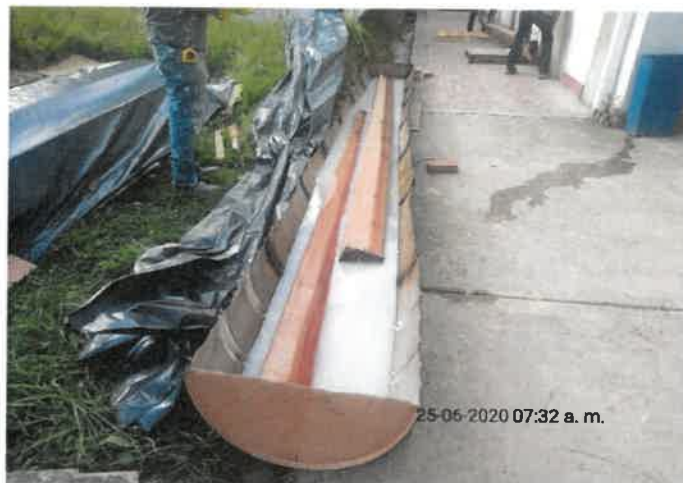
FOTO No 45: La interventoría ARQUITECTURA URBANA LTDA revisa y verifica que el contratista CONSORCIO PRUNI SEDES 04 realice la inmunización por el método de inmersión, el inmunizante DWT se puede aplicar por tres (3) métodos brocha, aspersión o inmersión.
