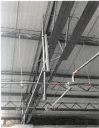
FOTO No 67: La interventoría ARQUITECTURA URBANA LTDA revisa y verifica la instalacion de tubería 12mm par red contra incendios zona administrativa I nivel
