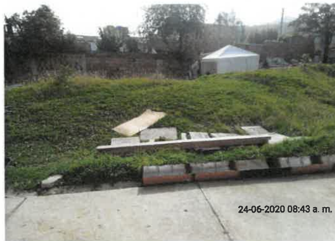
FOTO No 34: La interventoría ARQUITECTURA URBANA LTDA revisa y verifica que el contratista CONSORCIO PRUNI SEDES 04 ingrese a la sede IMPRENTA DISTRITAL el material vigas en madera de ABARCO con fines de realizar el reforzamiento de la estructura de la cubierta en madera del área de producción.
