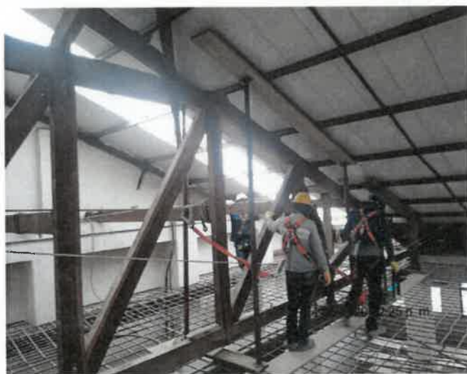
FOTO No 35: La interventoría ARQUITECTURA URBANA LTDA revisa y verifica que el contratista CONSORCIO PRUNI SEDES 04 realice el apuntalamiento de la cubierta existente para garantizar la estabilidad en el proceso constructivo del cambio de piezas en madera de acuerdo a planos de diseño RE23 y RE 24.
