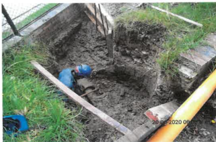
FOTO No 25: La interventoría ARQUITECTURA URBANA LTDA revisa y verifica que el contratista CONSORCIO PRUNI SEDES 04 realice la excavación manual incluye retiro para construir el pozo de inspección.
