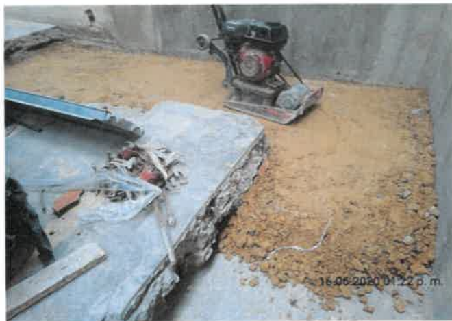
FOTO No 9: La interventoría ARQUITECTURA URBANA LTDA revisa y verifica que el contratista CONSORCIO PRUNI SEDES 04 realice relleno en recebo B400 en áreas intervenidas para el reforzamiento estructural de la cimentación (zapatas y vigas de cimentación) del área de producción revisa y verifica la compactación mecánica mediante el equipo RANA.
