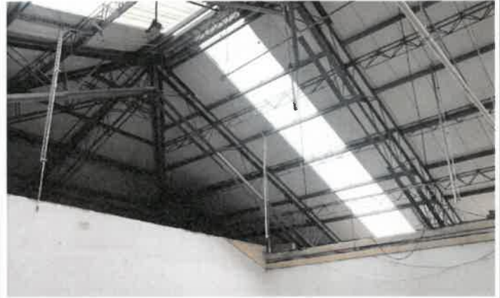
FOTO No 68: La interventoría ARQUITECTURA URBANA LTDA revisa y verifica la instalacion de tubería 12mm par red contra incendios zona administrativa I nivel.
