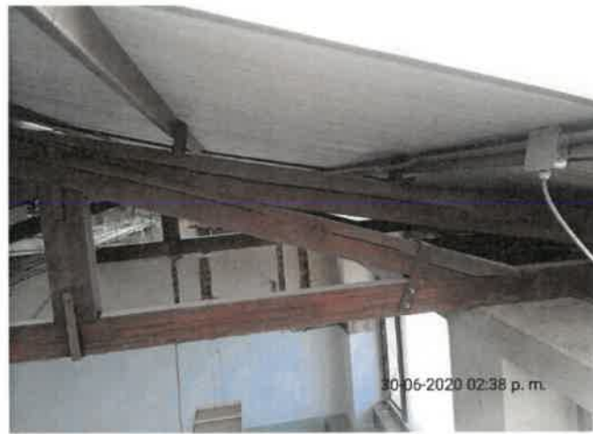
FOTO No 62: La interventoría ARQUITECTURA URBANA LTDA revisa y verifica en conjunto con el contratista CONSORCIO PRUNI SEDES 04 los elementos en madera de la cercha numero 12 (CERCHA 12) para determinar el cambio según su deterioro ya y lo expuesto en planos de consultoría
