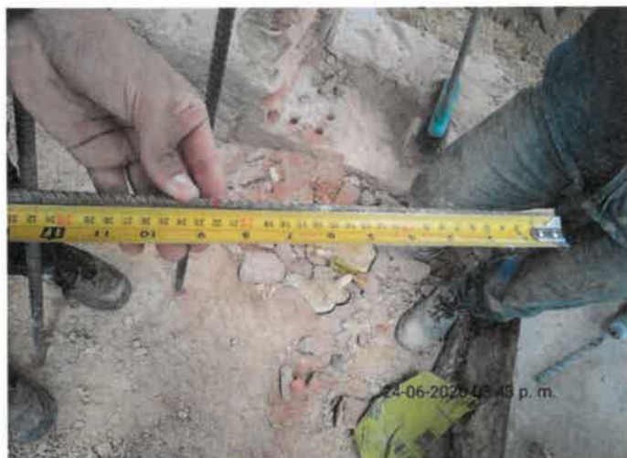
FOTO No 41: La interventoría ARQUITECTURA URBANA LTDA reviso y verifico la profundidad de la perforaciones numero 6 (3/4") de longitud de 0.22m ejecutados para realizar columnetas de confinamiento en el vano de la puerta de la subestación eléctrica.
