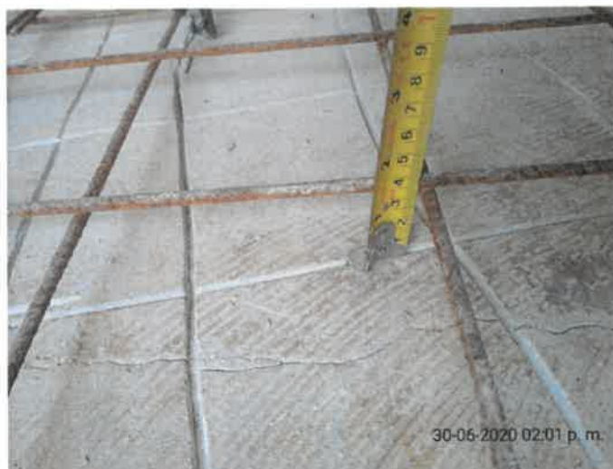
FOTO No 60: La interventoría ARQUITECTURA URBANA LTDA revisa y verifica cada vez que el contratista CONSORCIO PRUNI SEDES 04 realice la instalación de la malla electrosoldada cumpla con su respectivo recubrimiento de concreto en el costado inferior.
