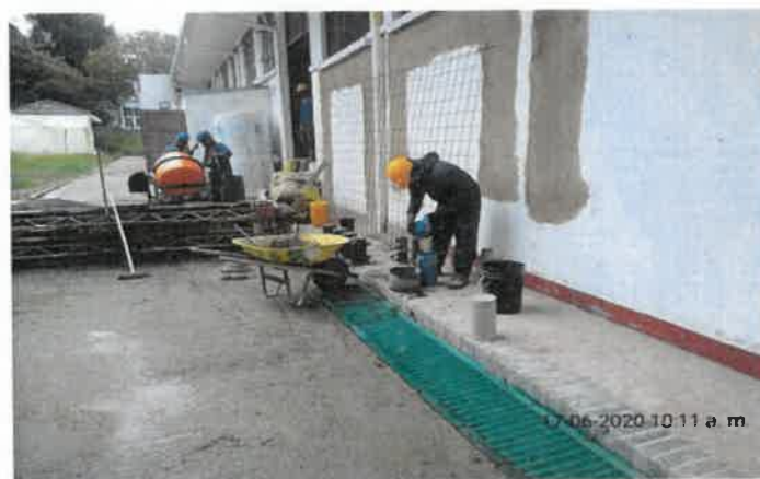
FOTO No 15: La interventoría ARQUITECTURA URBANA LTDA revisa y verifica que el contratista CONSORCIO PRUNI SEDES 04 realice ensayo de compresión (NTC 673) al concreto de 4000 PSI elaborado en obra con el fin de realizar el vaciado en la zapata Z-4 Eje 3p, zapata Z-6 Eje 3Q y viga de cimentación Eje Q entre Ejes 3 y 5, los cuales serán ensayados a los 7, 14 y 28 días de edad con el fin de garantizar la resistencia exigida en planos de diseño. Esta interventoría también tomó muestras para realizar contramuestra a los 28 días de edad y de esta manera verificar con el resultado entregado por el contratista de obra.
