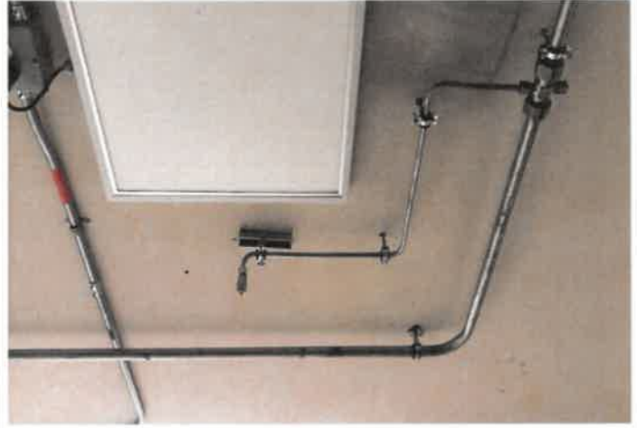
FOTO No 66: La interventoría ARQUITECTURA URBANA LTDA revisa y verifica la instalacion de tubería 12mm par red contra incendios zona administrativa I nivel.
