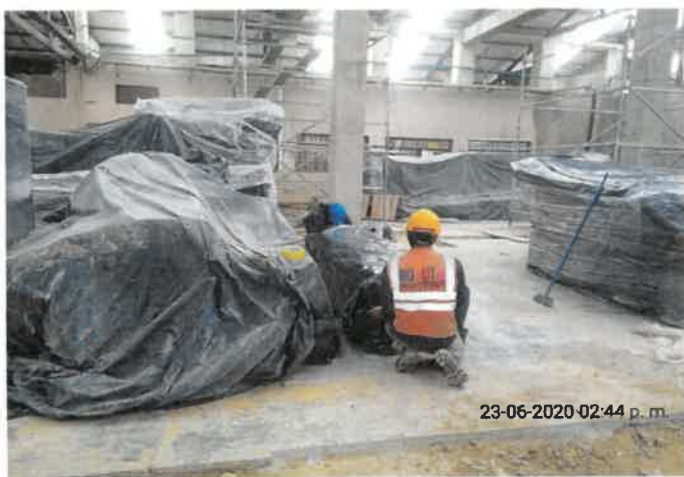
FOTO No 31: La interventoría ARQUITECTURA URBANA LTDA revisa y verifica que el contratista CONSORCIO PRUNI SEDES 04 realice la reparación del embalaje de las maquinas del área de producción.
