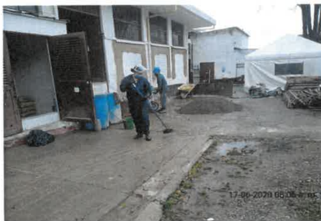
FOTO No 12: La interventoría ARQUITECTURA URBANA LTDA revisa y verifica que el contratista de obra CONSORCIO PRUNI SEDES 04 realice aseo permanente a las diferentes áreas de ejecución de actividades de obra.
