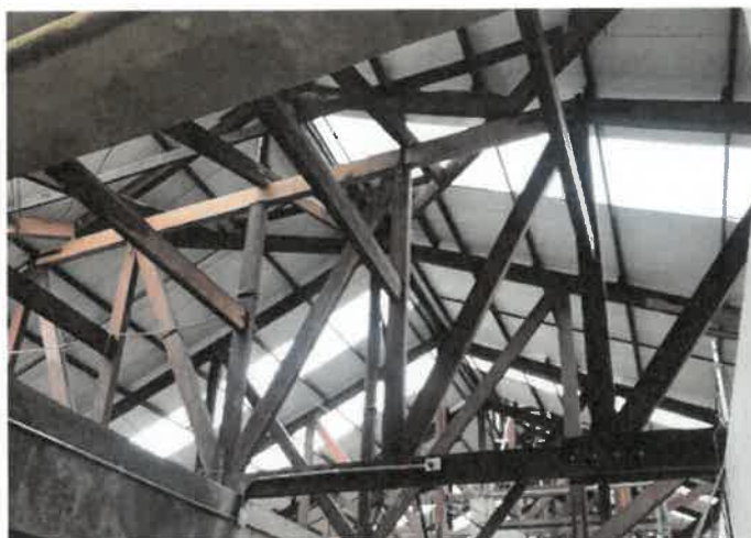
FOTO No 38: La interventoría ARQUITECTURA URBANA LTDA revisa y verifica que el contratista de obra CONSORCIO PRUNI SEDES 04 realice actividades correspondientes al ítem de reemplazo elementos de madera deteriorados. Se consideran piezas de madera de 10x18 cms, especial para estructuras de madera, esta actividad se realizó en la CERCHA 13 ubicada en el Eje H entre Ejes 2 y 14 en área de producción.
