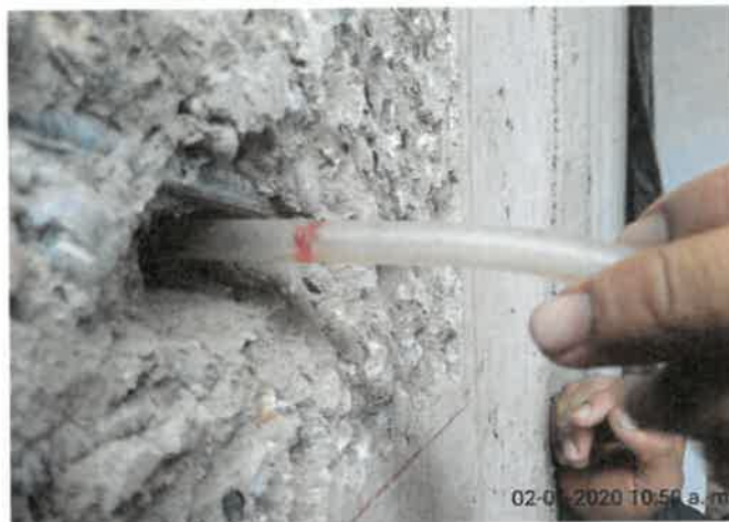
FOTO No 6: La interventoría ARQUITECTURA URBANA LTDA revisa y verifica que el contratista CONSORCIO PRUNI SEDES 04 realice perforaciones para anclajes de vigas aéreas VG-3, revisa y verifica la profundidad de las perforaciones la cual debe cumplir lo exigido en planos de diseño RE-23.
