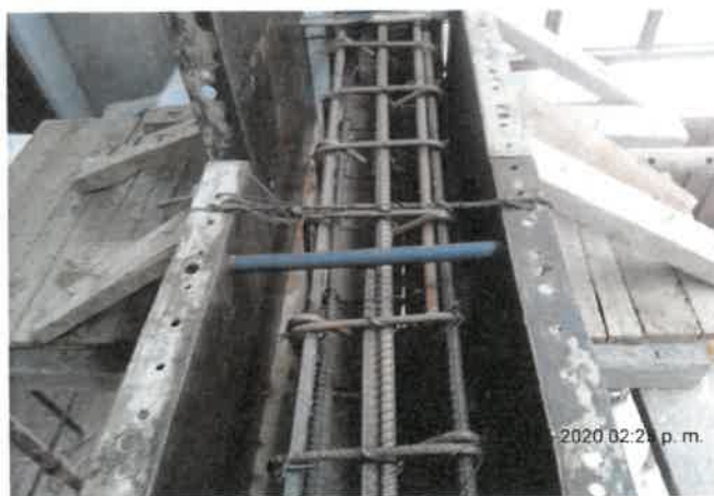
FOTO No 11: La interventoría ARQUITECTURA URBANA LTDA revisa y verifica que el contratista CONSORCIO PRUNI SEDES 04 realice el encofrado de la viga aérea VG-3 con formaleta metálica teniendo en cuenta el recubrimiento en concreto y dimensiones exigidas en plano RE-21, lo cual es de 0.30 m de altura * 0.25 de ancho con recubrimiento lateral de 4cm, recubrimiento inferior de 6cm y recubrimiento superior de 5 cm.
