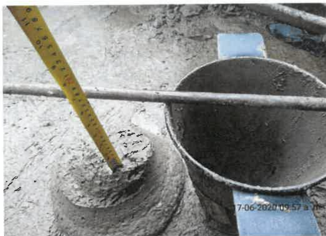
FOTO No 14: La interventoría ARQUITECTURA URBANA LTDA revisa y verifica que el contratista CONSORCIO PRUNI SEDES 04 realice el ensayo de asentamiento al concreto de 4000 PSI elaborado en obra y con la finalidad de ser vaciado en la Zapata z-4 Eje 3P, zapata Z-6 Eje 3Q y viga de cimentación Eje Q entre Ejes 3 y 5. Este ensayo se realiza con el fin de controlar la dosificación de la relación entre agua - cemento, lo cual en el diseño de mezcla entregado y avalado por la interventoría exige un asentamiento entre 5 a 6 pulgadas más o menos l.
