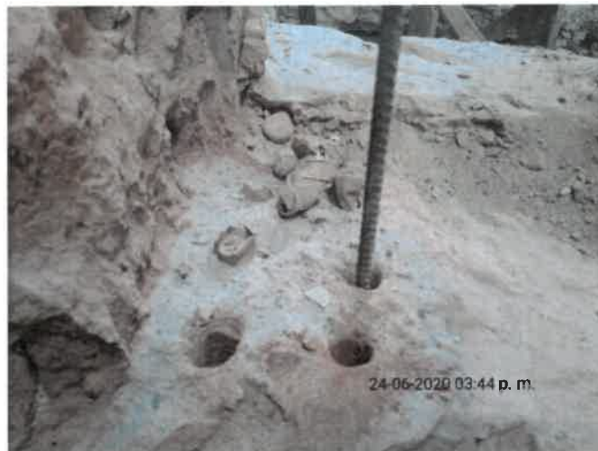
FOTO No 42: La interventoría ARQUITECTURA URBANA LTDA reviso y verifico la profundidad de la perforaciones numero 6 (3/4") de longitud de 0.22m ejecutados para realizar columnetas de confinamiento en el vano de la puerta de la subestación eléctrica.
