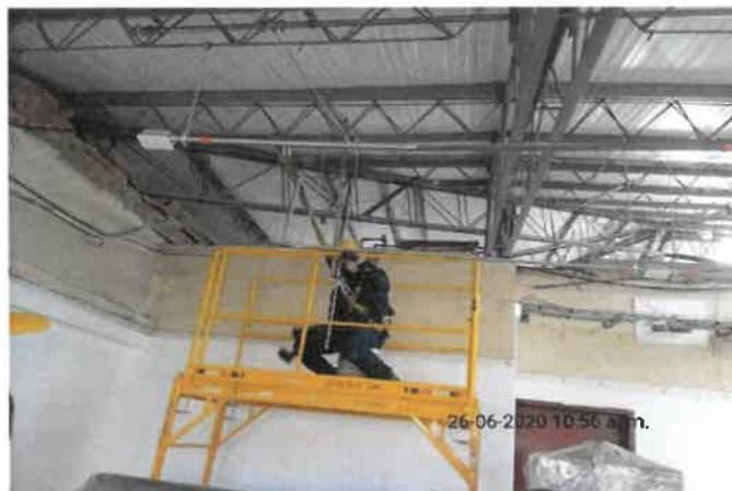
FOTO No 49: La interventoría ARQUITECTURA URBANA LTDA revisa y verifica que el contratista CONSORCIO PRUNI SEDES 04 realice la instalación de tubería 12 mm para rociadores o boquillas de la red contraincendios de acuerdo a la altura del cielo raso.
