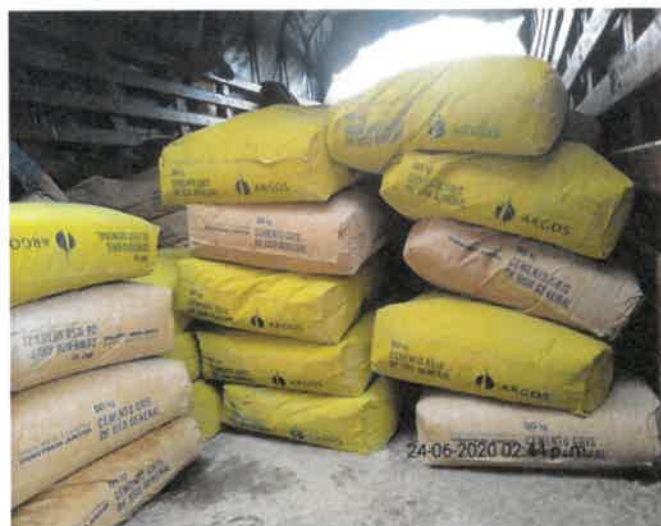
FOTO No 40: La interventoría ARQUITECTURA URBANA LTDA revisa y verifica que el contratista CONSORCIO PRUNI SEDES 04 ingrese cemento con fines de elaborar concreto de 4000 PSI para la placa de contrapiso intervenida por el reforzamiento estructural de la cimentación del área de producción.
