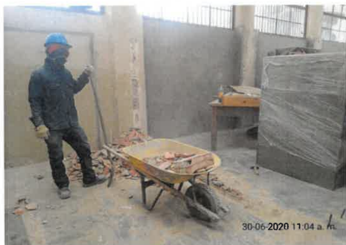
FOTO No 63: La interventoría ARQUITECTURA URBANA LTDA revisa y verifica que el contratista CONSORCIO PRUNI SEDES 04 realice la demolición del muro de mampostería del área de recolección de desechos peligrosos ubicado en el área de producción.
