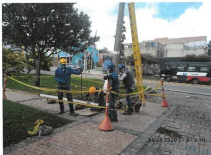
FOTO No 21: La interventoría ARQUITECTURA URBANA LTDA revisa y verifica que el contratista CONSORCIO PRUNI SEDES 04 realice la actividad de suministro e instalación de tubería MIC de 6" x 6 Mts incluye unión, curva, y cinta acero inoxidable vandy 3/4 " para remplazo de afloramiento existente, incluye retiro de tubería de 3 ".
