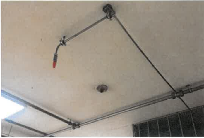
FOTO No 65: La interventoría ARQUITECTURA URBANA LTDA revisa y verifica la instalacion de tubería 12mm par red contra incendios zona administrativa I nivel
