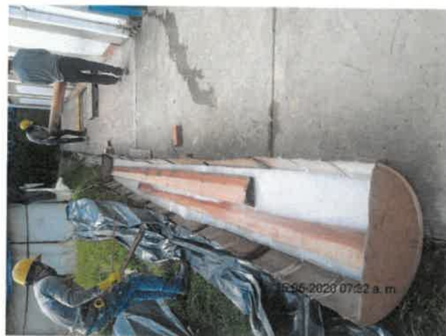
FOTO No 46: La interventoría ARQUITECTURA URBANA LTDA revisa y verifica que el contratista CONSORCIO PRUNI SEDES 04 realice la inmunización por el método de inmersión, el inmunizante DWT se puede aplicar por tres (3) métodos brocha, aspersión o inmersión.
