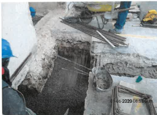
FOTO No 1: La interventoría ARQUITECTURA URBANA LTDA revisa y verifica que el contratista CONSORCIO PRUNI SEDES 04 realice el concreto de limpieza en la zapatas Z-4 ubicadas en el Eje 3 entre Ejes Q-R.
