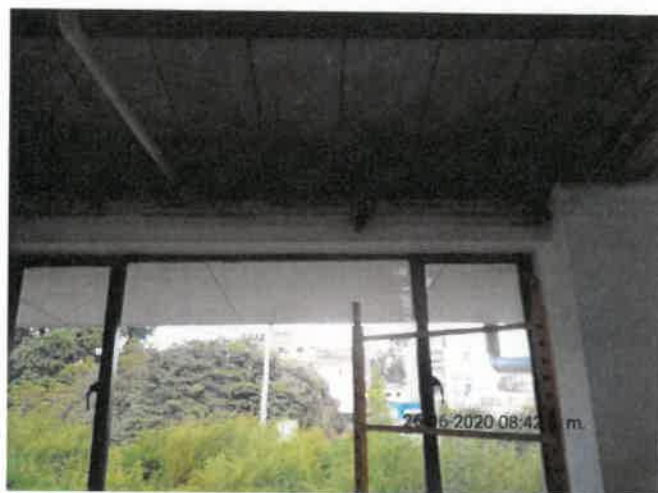
FOTO No 48: La interventoría ARQUITECTURA URBANA LTDA revisa y verifica que el contratista CONSORCIO PRUNI SEDES 04 verifique los niveles del cielo raso planta segundo nivel área administrativa quedando de acuerdo a una altura de 2.32 metros de altura en el espacio denominado oficinas abiertas.
