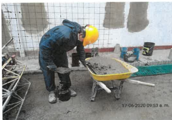
FOTO No 13: La interventoría ARQUITECTURA URBANA LTDA revisa y verifica que el contratista CONSORCIO PRUNI SEDES 04 realice el ensayo de asentamiento al concreto de 4000 PSI elaborado en obra y con la finalidad de ser vaciado en la Zapata z-4 Eje 3P, zapata Z-6 Eje 3Q y viga de cimentación Eje Q entre Ejes 3 y 5. Este ensayo se realiza con el fin de controlar la dosificación de la relación entre agua - cemento, lo cual en el diseño de mezcla entregado y avalado por la interventoría exige un asentamiento entre 5 a 6 pulgadas más o menos l.
