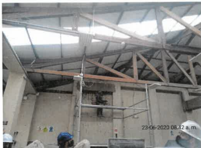
FOTO No 27: La interventoría ARQUITECTURA URBANA LTDA revisa y verifica que el contratista CONSORCIO PRUNI SEDES 04 realice la actividad pañete 1:4 (1 cantidad de cemento por 4 de arena.) sobre las vigas aéreas VG-7 y vg-8.
