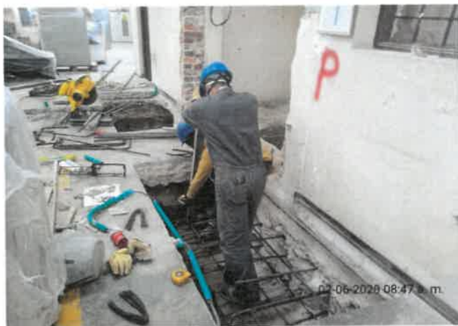
FOTO No 5: La interventoría ARQUITECTURA URBANA LTDA revisa y verifica que el contratista CONSORCIO PRUNI SEDES 04 realice amarre de acero de refuerzo de 6000 PSI en las zapatas Z-4 Eje 3 P y zapata Z-6 Eje 3 Q ubicadas en el área de producción.
