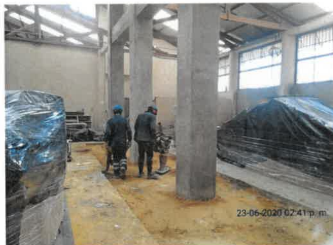
FOTO No 28: La interventoría ARQUITECTURA URBANA LTDA revisa y verifica que el contratista CONSORCIO PRUNI SEDES 04 continúe con la compactación de material recebo B400 ejecutado para la conformación de la placa de contrapiso intervenida por el reforzamiento estructural de la cimentación del área de producción.
