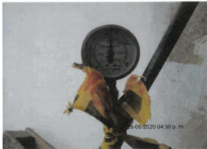
FOTO No 52: La interventoría ARQUITECTURA URBANA LTDA revisa y verifica que el contratista CONSORCIO PRUNI SEDES 04 realice la prueba de presión a la red de distribución del sistema contraincendios de la planta del primer nivel área administrativa.
