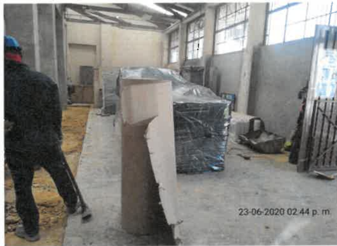
FOTO No 30: La interventoría ARQUITECTURA URBANA LTDA revisa y verifica que el contratista CONSORCIO PRUNI SEDES 04 realice la reparación del embalaje de las maquinas del área de producción.
