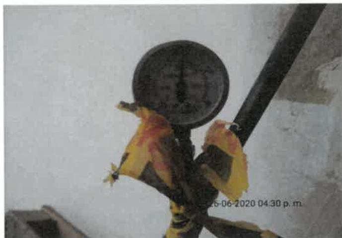
FOTO No 53: La interventoría ARQUITECTURA URBANA LTDA revisa y verifica que el contratista CONSORCIO PRUNI SEDES D4 realice la prueba de presión a la red de distribución del sistema contraincendios de la planta del primer nivel área administrativa.
