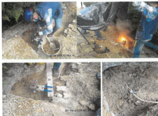
FOTO No 2: La interventoría ARQUITECTURA URBANA LTDA revisa y verifica que el contratista CONSORCIO PRUNI SEDES 04 continúe con la instalación de malla de puesta a tierra subestación con 4 varillas coperweld 5/8" X 2.44 mts, cámaras de inspección 30X30 CM, 54 mts de cable cobre 2/0 desnudo, 8 soldaduras cable varilla y 4 cable-cable correspondiente a la actividad eléctrica del ítems 3.6.0.15.
