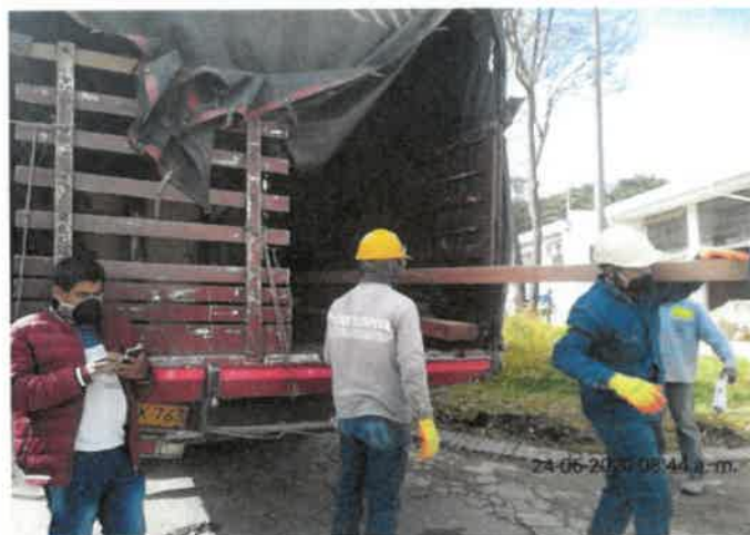
FOTO No 33: La interventoría ARQUITECTURA URBANA LTDA revisa y verifica que el contratista CONSORCIO PRUNI SEDES 04 ingrese a la sede IMPRENTA DISTRITAL el material vigas en madera de ABARCO con fines de realizar el reforzamiento de la estructura de la cubierta en madera del área de producción.
