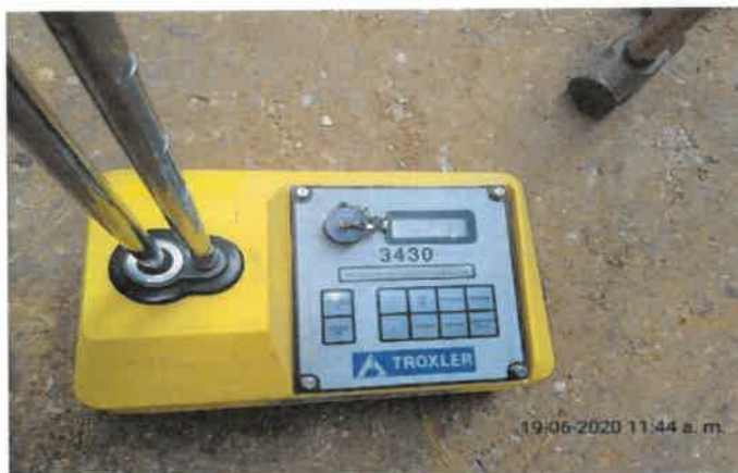
FOTO No 24: La interventoría ARQUITECTURA URBANA LTDA revisa y verifica que el contratista CONSORCIO PRUNI SEDES 04 realice el ensayo de densidad del material afirmado B400 para garantizar el proctor exigido del 95% de acuerdo a las especificaciones técnicas del proyecto.
