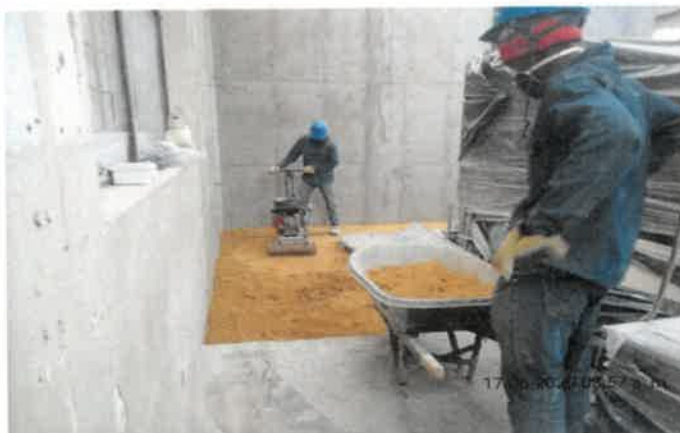
FOTO No 16: La interventoría ARQUITECTURA URBANA LTDA revisa y verifica que el contratista de obra CONSORCIO PRUNI SEDES 04 continúe con la compactación de recebo B400 en áreas intervenidas por el reforzamiento estructural de la cimentación en el área de producción.
