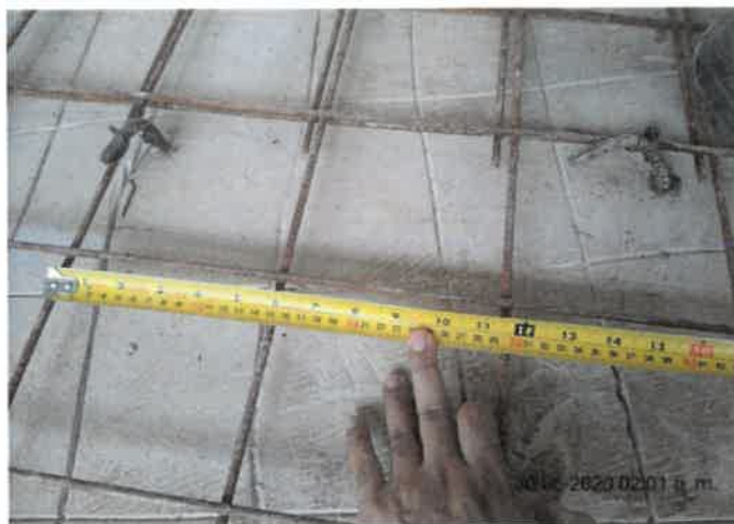
FOTO No 61: La interventoría ARQUITECTURA URBANA LTDA revisa y verifica cada vez que el contratista CONSORCIO PRUNI SEDES 04 instale malla electrosoldada 04 cumpla con la especificación técnica y planos de diseño cumplan con las dimensiones de 0.15m*0.15m.
