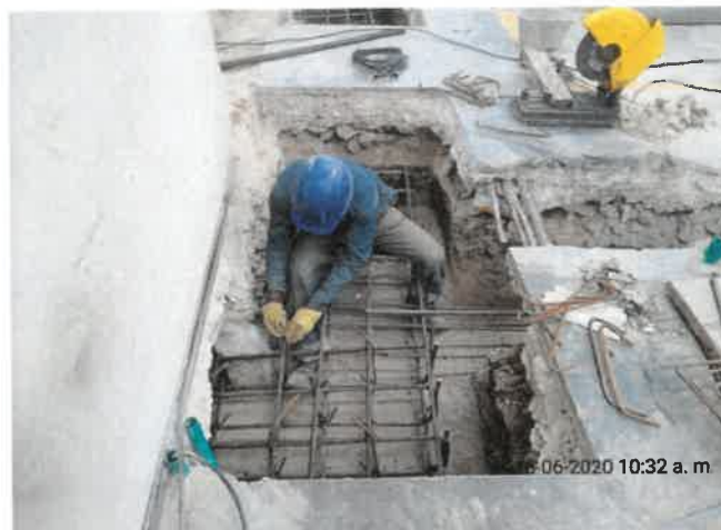
FOTO No 8: La interventoría ARQUITECTURA URBANA LTDA revisa y verifica que el contratista CONSORCIO PRUNI SEDES 04 termine con el amarre de acero de refuerzo de 60000 PSI en los siguientes elementos estructurales en las zapata Z-4 Eje 3P, zapata Z-6 Eje 3Q y viga de cimentación Eje Q entre Ejes 3 y 5..
