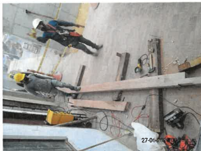
FOTO No 58: La interventoría ARQUITECTURA URBANA LTDA revisa y verifica que el contratista CONSORCIO PRUNI SEDES 04 realice el corte de madera en ABARCO con sus respectivas cajas y cantos de acuerdo a la estructura en madera existente que no va ser intervenida de acuerdo al estudio fitosanitario de la consultoría.
