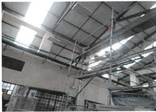
FOTO No 32: La interventoría ARQUITECTURA URBANA LTDA revisa y verifica que el contratista de obra CONSORCIO PRUNI SEDES 04 realice el maquillado de vigas aéreas VG-5, VG-6 y VG-4 localizadas en el área de producción.
