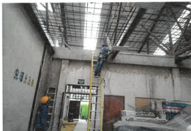
FOTO No 26: La interventoría ARQUITECTURA URBANA LTDA revisa y verifica que el contratista CONSORCIO PRUNI SEDES 04 realice la reinstalación de la tubería EMT de " en el área de bodega general.
