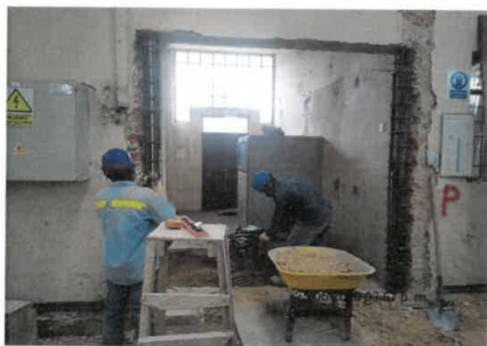
FOTO No 47: La interventoría ARQUITECTURA URBANA LTDA revisa y verifica que el contratista CONSORCIO PRUNI SEDES 04 realice el amarre de acero de refuerzo de 60000 PSI para conformar columnetas de confinamiento de la puerta del cuarto de subestación.
