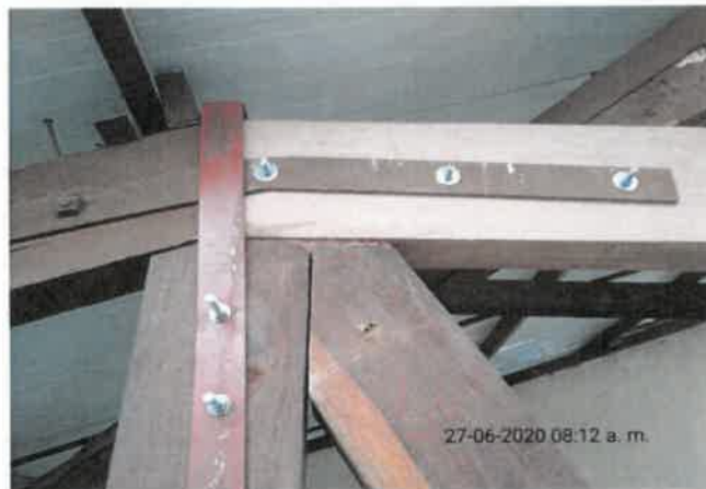
FOTO No 56: La interventoría ARQUITECTURA URBANA LTDA revisa y verifica que el contratista de obra CONSORCIO PRUNI SEDES D4 realice actividades correspondientes al ítem de reemplazo elementos de madera deteriorados.
