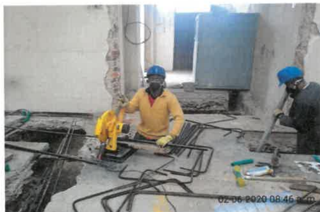
FOTO No 4: La interventoría ARQUITECTURA URBANA LTDA revisa y verifica que el contratista CONSORCIO PRUNI SEDES 04 realice corte y figurado de acero de refuerzo de 6000 PSI en las zapatas Z-4 Eje 3P y zapata Z-6 Eje 3 Q.
