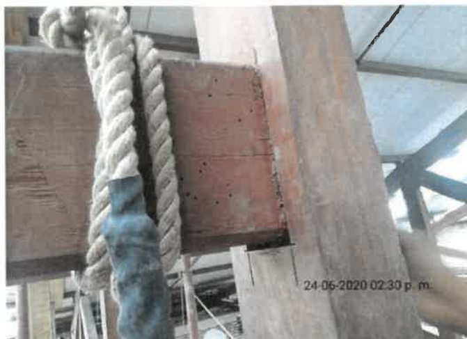
FOTO No 37: La interventoría ARQUITECTURA URBANA LTDA revisa y verifica que el contratista de obra CONSORCIO PRUNI SEDES 04 realice actividades correspondientes al ítem de reemplazo de elementos en madera deteriorados. Se consideran piezas de madera de 10x18 cms, especial para estructuras de madera, esta actividad se realizó en la CERCHA 13 ubicada en el Eje H entre Ejes 2 y 14 en área de producción.
