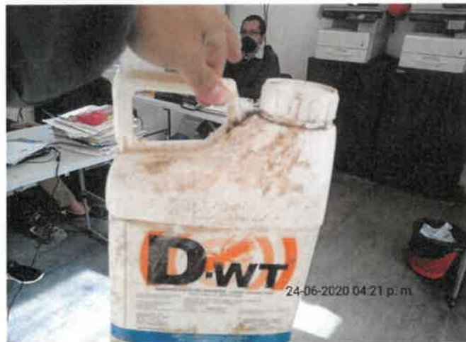
FOTO No 44: La interventoría ARQUITECTURA URBANA LTDA revisa y verifica que el contratista CONSORCIO PRUNI SEDES 04 utilice el inmunizante de madera DWT aprobado por la interventoría para realizar el proceso de inmunización de las vigas en madera de abarco las cuales van a remplazar ya que están afectadas por gorgojo y son referenciadas para cambio exigidos mediante los planos de diseño RE 23 y RE24 que componen la estructura en madera de la cubierta del área de producción.
