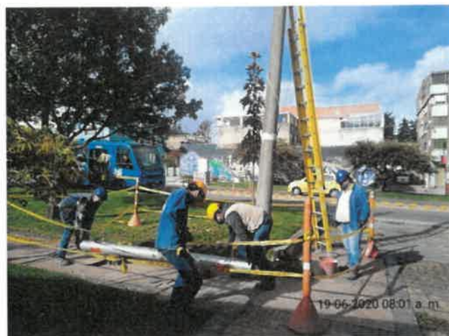
FOTO No 22: La interventoría ARQUITECTURA URBANA LTDA revisa y verifica que el contratista CONSORCIO PRUNI SEDES 04 realice la actividad de suministro e instalación de tubería MIC de 6" x 6 Mts incluye unión, curva, y cinta acero inoxidable vandy 3/4 " para remplazo de afloramiento existente, incluye retiro de tubería de 3 ".
