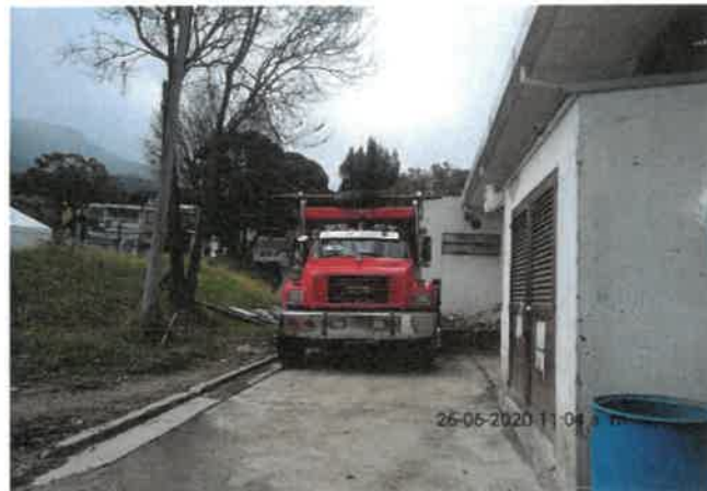
FOTO No 50: La interventoría ARQUITECTURA URBANA LTDA revisa y verifica que el contratista CONSORCIO PRUNI SEDES 04 realice el retiro de material productos de excavaciones y demoliciones del reforzamiento estructural de la cimentación del área de producción.
