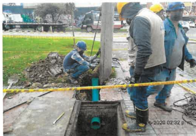
FOTO No 20: La interventoría ARQUITECTURA URBANA LTDA revisa y verifica que el contratista CONSORCIO PRUNI SEDES 04 realice la actividad de suministro e instalación de tubería MIC de 6" x 6 Mts incluye unión, curva, y cinta acero inoxidable vandy 3/4 " para remplazo de afloramiento existente, incluye retiro de tubería de 3 ".
