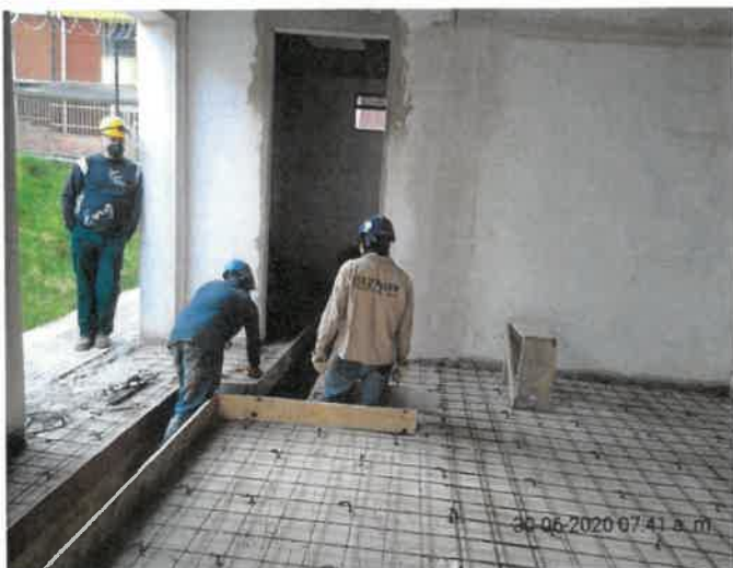
FOTO No 59: La interventoría ARQUITECTURA URBANA LTDA revisa y verifica que el contratista CONSORCIO PRUNI SEDES 04 realice la instalación de la malla electrosoldada Q4 (6mm) de 15*15 como refuerzo de la placa de contrapiso del área de la planta eléctrica.
