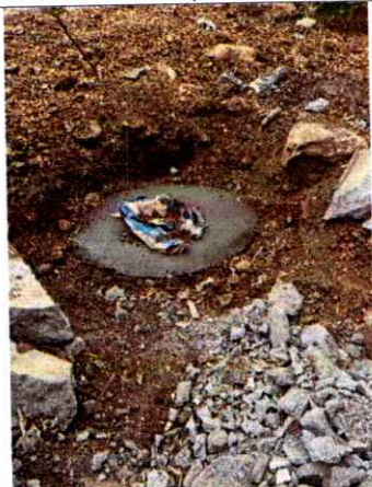
Ilustración 11. Construcción de pozo de inspección
