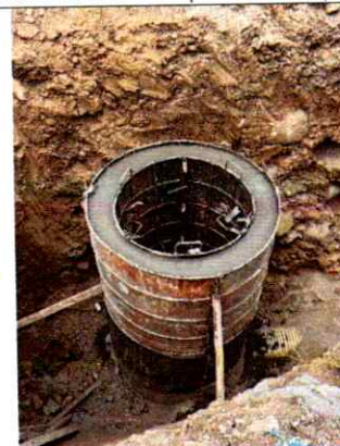
Ilustración 12. Construcción de pozo de inspección
