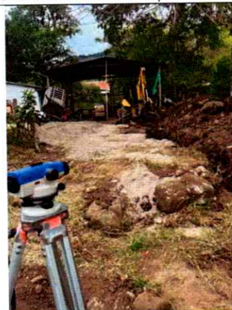
Ilustración 4. Replanteo topografico
