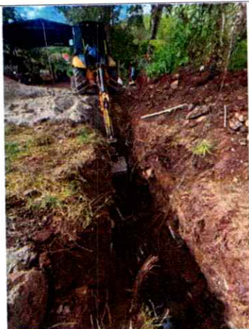
Ilustración 7. Excavación mecánica
