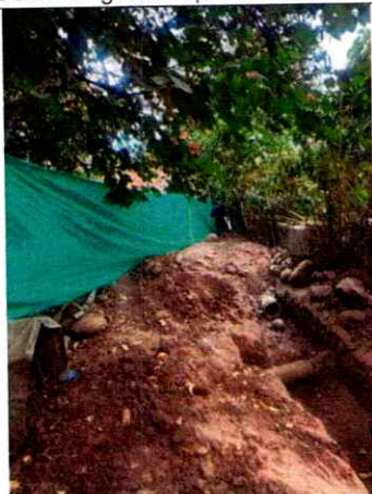
Ilustración 3. Cerramiento en lona verde
