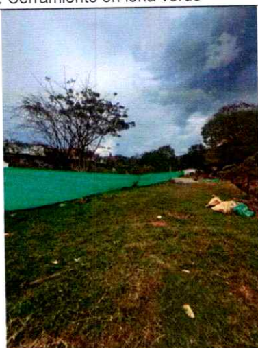
Ilustración 5. Cerramiento en lona verde
