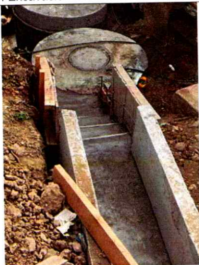
Ilustración 9. Construcción dissipador de energia
