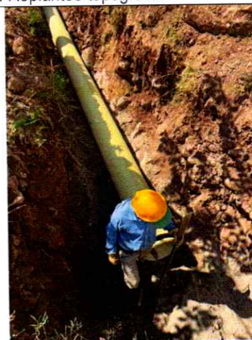
Ilustración 6. Instalación tubería de 16"
