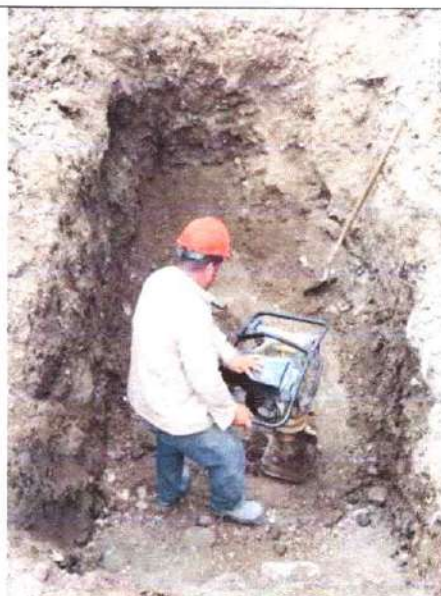
Relleno de excavación con material recebo
