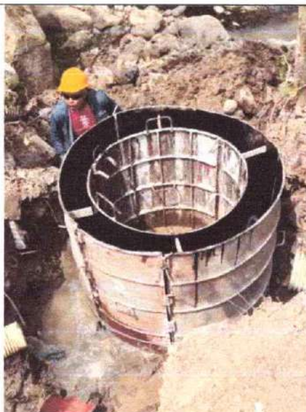
Fundición de pozo de inspección
