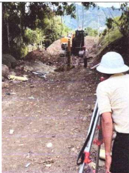
Replanteo de red.
