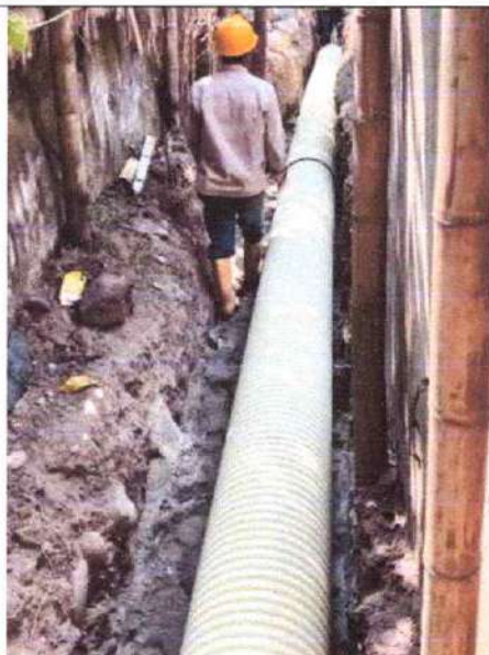
Instalación de tubería 16"
