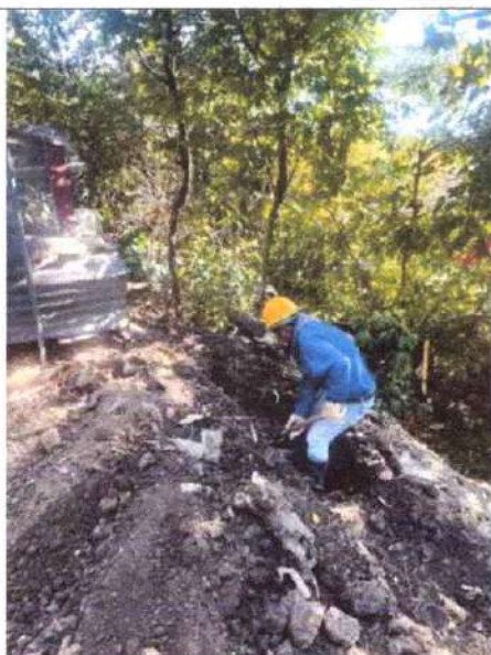
Excavación en roca
