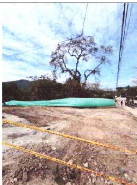
Retiro de material sobrante de excavación.
