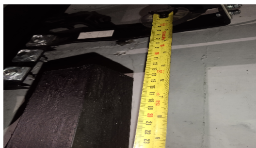
Foto 1. Distancia de actuación en límites superior e inferior superan los 12 cm
