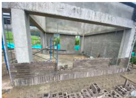
CONSTRUCCIÓN DE DOVELAS MUROS ED. COMPLEM.
