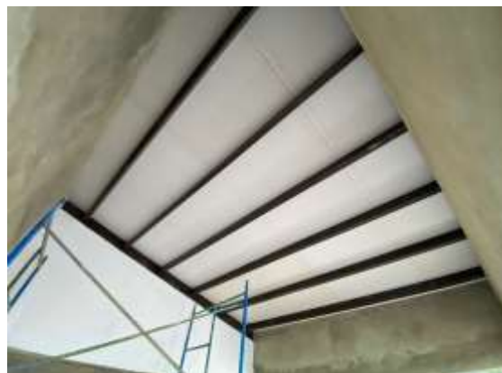
INSTALACIÓN CIELO RASO ED. COMPLEMENTARIO
