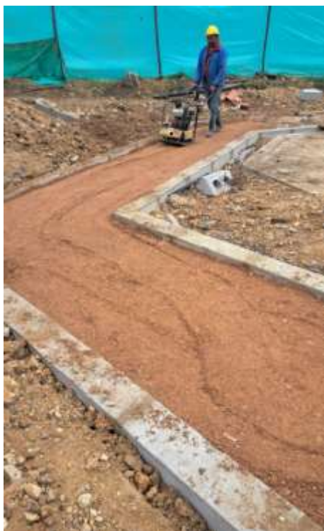
COMPACTACIÓN SUBBASE PISTA DE TROTE
