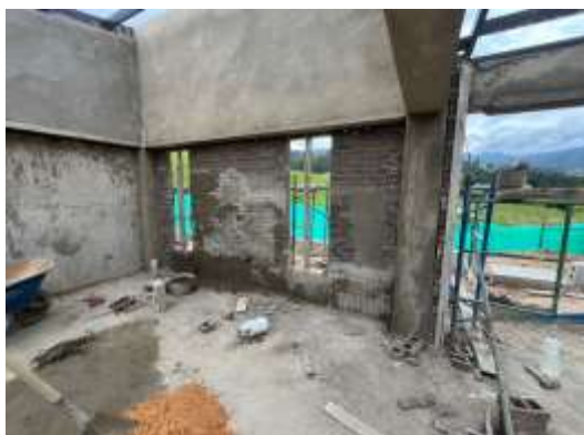
CONSTRUCCIÓN MURO ED. COMPLEMENTARIO
