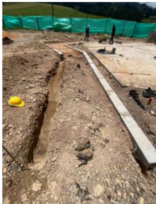
INSTALACIÓN BORDILLO PISTA DE TROTE
