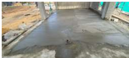
APLICACIÓN MORTERO PISO ED. COMPLEMENTARIO
