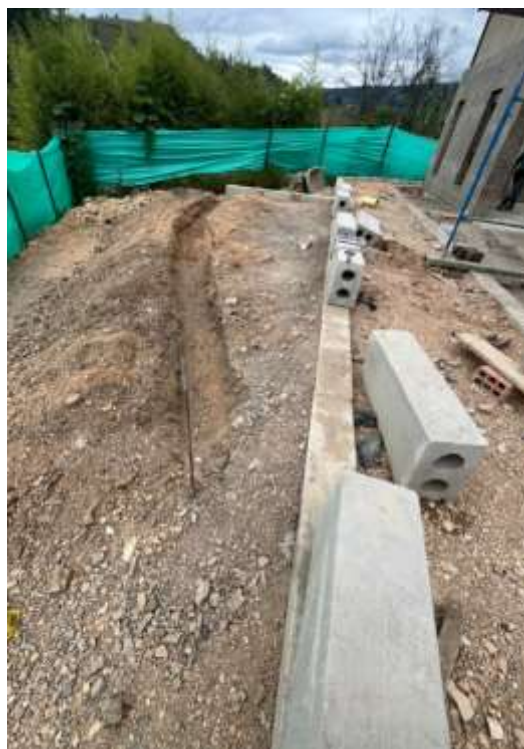
INSTALACIÓN BORDILLO URBANISMO
