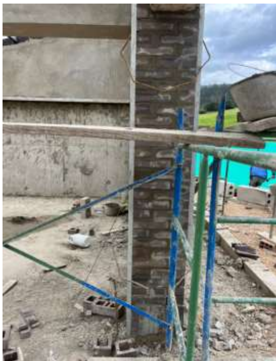
ENCHAPADO COLUMNAS ED. COMPLEMENTARIO
