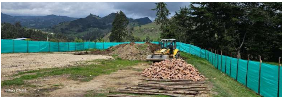
IMAGEN No 4 – ESTADO DE PREDIO PARA INICIO DE OBRA
