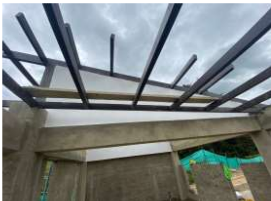
APLICACIÓN ESTUCO Y PINTURA ED. COMPLEM.
