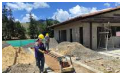
BORDILLO Y SUBBASE PISTA DE TROTE
