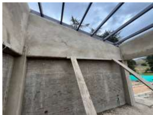
APLICACIÓN PAÑETE MUROS INTERNO ED. COMPLEM.
