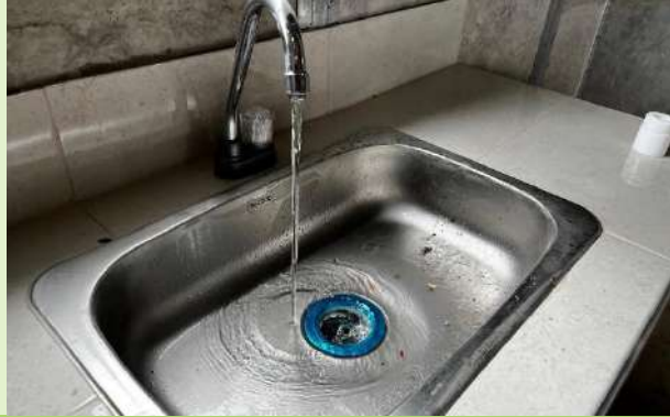
Ilustración 97. Prueba Hidráulica en lavaplatos
