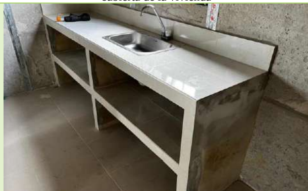
Ilustración 83. Verificación de acabados mesón y piso cocina
