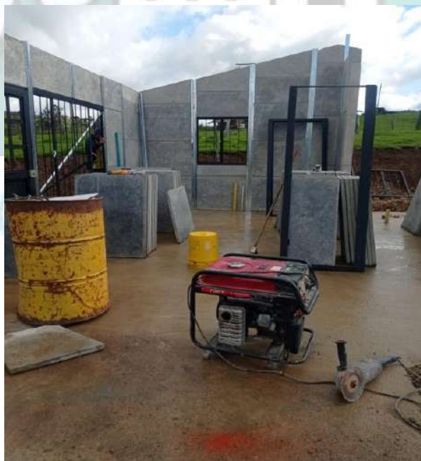
Ilustración 1. Uso de planta eléctrica para armado de viviendas
