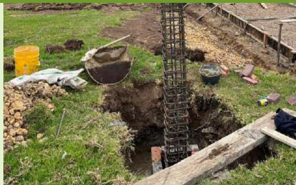
Ilustración 42. Actividades de figurado de acero para pedestal tanque de almacenamiento
