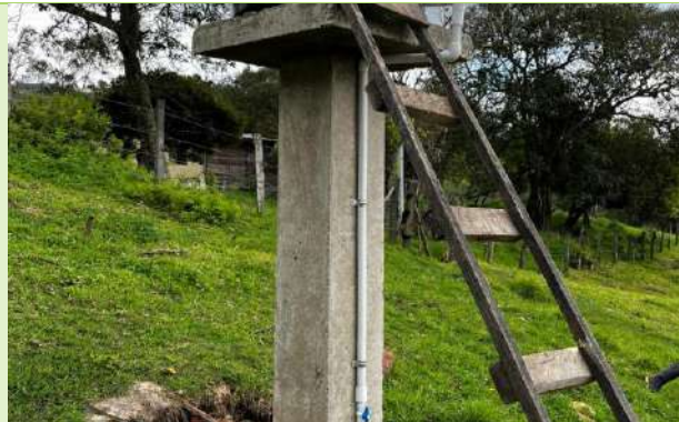
Ilustración 48. Acabado del pedestal para tanque de almacenamiento
