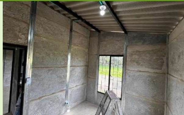
Ilustración 104. Prueba Eléctrica en Alcoba No. 2
