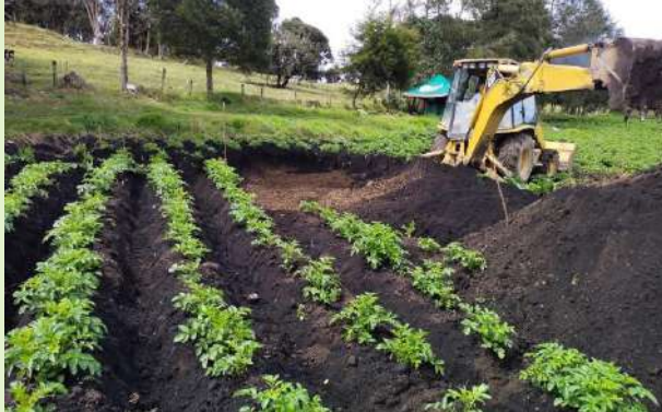
Ilustración 19. Actividades de Excavación predio Sr. Esteban Santana
