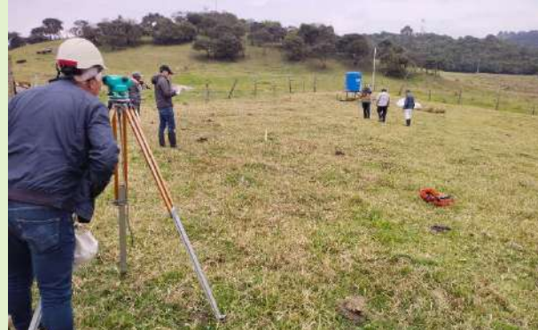
Ilustración 14. Localización y replanteo para nivelación Sra. Ana Silvia León
