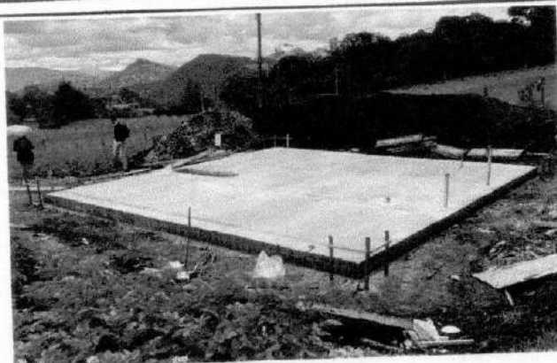
Imagen 2. Placa de cimentación en concreto.
