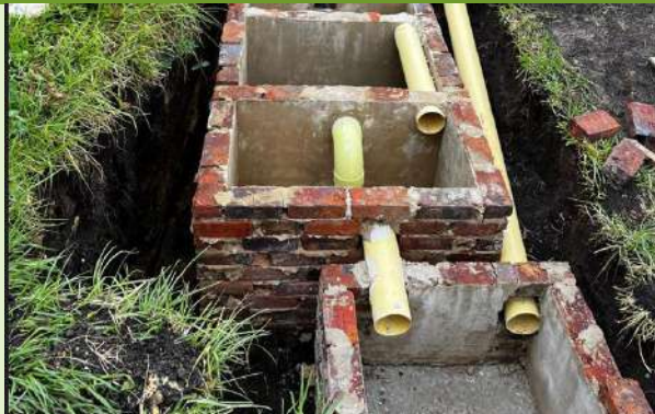
Ilustración 52. Verificación de los accesorios del pozo séptico de las viviendas
