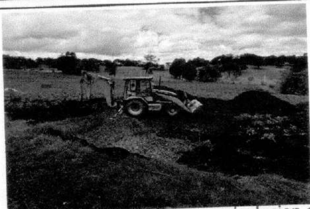
Imagen 1. Excavación para nivelación de terreno y conformación de taludes.
