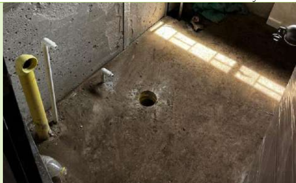
Ilustración 76. Verificación de redes hidráulicas y sanitarias internas de la vivienda
