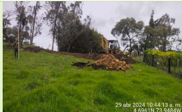
Ilustración 24. Actividades de Excavación predio Sr. Carlos Cortes
