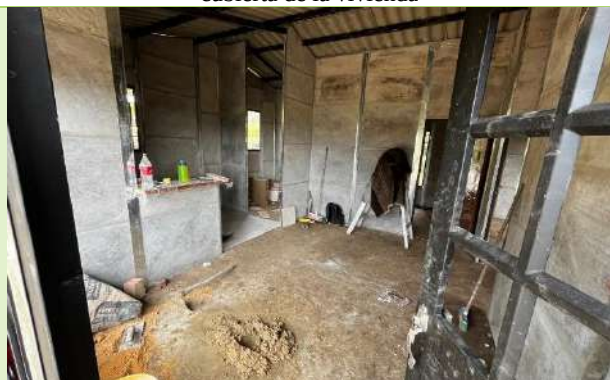
Ilustración 81. Verificación de áreas y acabados de muros y cubierta de la vivienda
