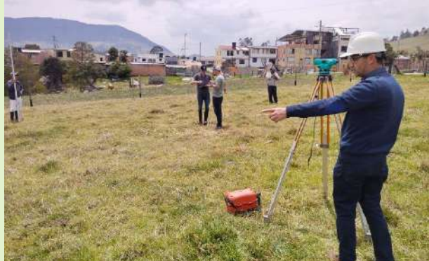
Ilustración 13. Localización y replanteo para nivelación predio Sra. Blanca Yenneth Clavijo
