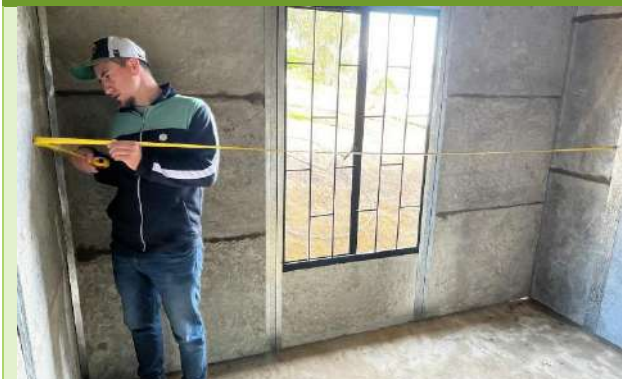
Ilustración 78. Verificación de áreas y acabados de muros y cubierta de la vivienda
