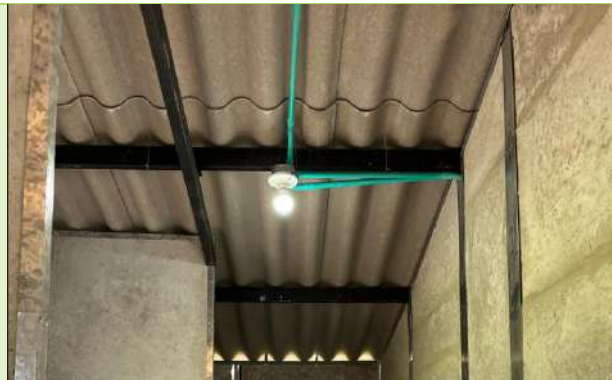
Ilustración 105. Prueba Eléctrica en pasillo lavadero
