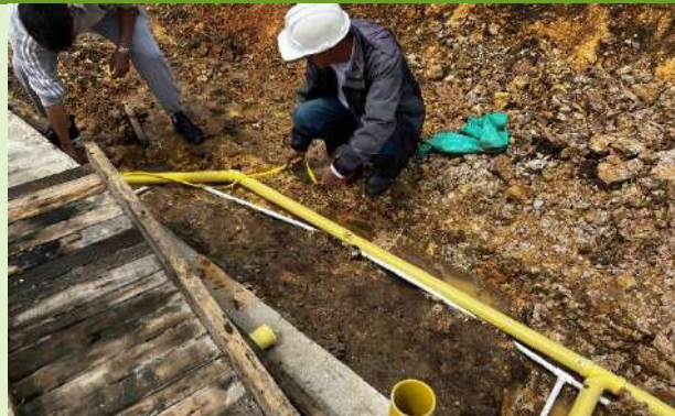
Ilustración 51. Verificación de redes sanitarias de aguas negras y grises del sistema séptico de las viviendas
