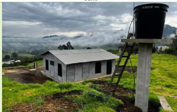
Ilustración 89. Verificación de tanque de almacenamiento
