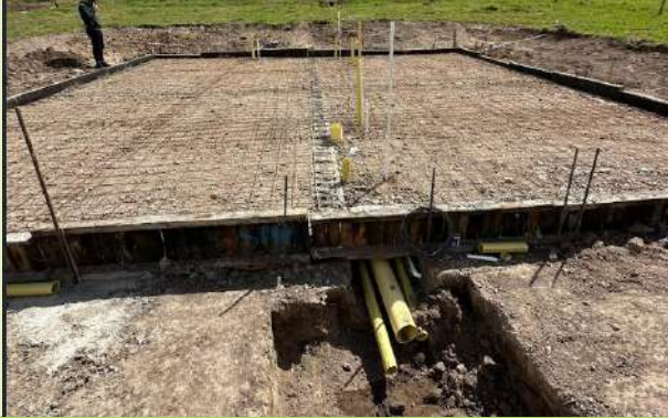
Ilustración 59. Verificación de las conexiones sanitarias
