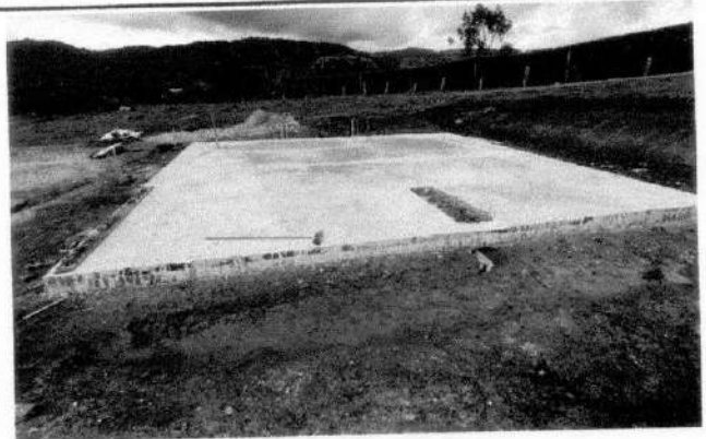
Imagen 2. Placa de cimentación en concreto.
