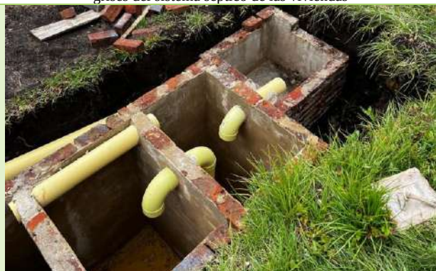
Ilustración 53. Verificación de los accesorios del pozo séptico de las viviendas
