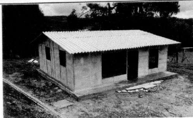
Imagen 6. Vivienda terminada para entrega a beneficiario.
