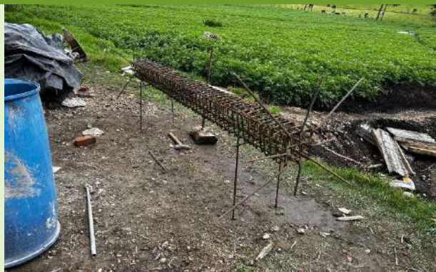
Ilustración 41. Actividades de figurado de acero para pedestal tanque de almacenamiento
