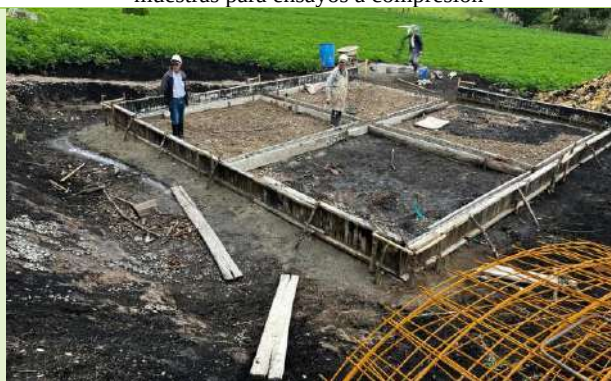
Ilustración 31. Actividades de construcción de placa base
