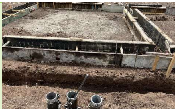
Ilustración 29. Encofrado de vigas de cimentación y toma de muestras para ensayos a compresión
