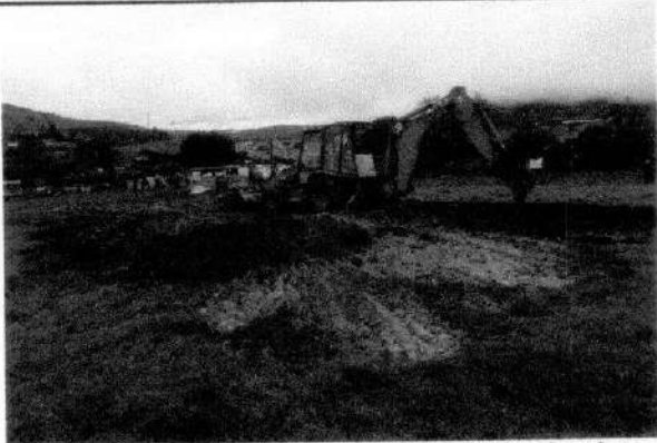
Imagen 1. Excavacion para nivelacion de terreno y conformacion de taludes.
