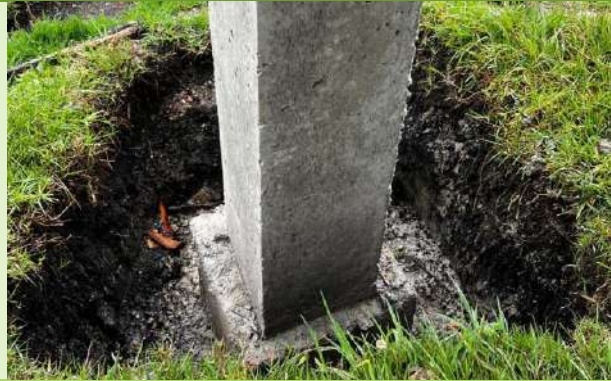
Ilustración 46. Actividades de fundida de pedestal - tanque de almacenamiento
