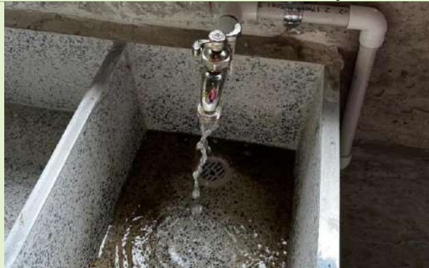
Ilustración 99. Prueba Hidráulica en Lavadero
