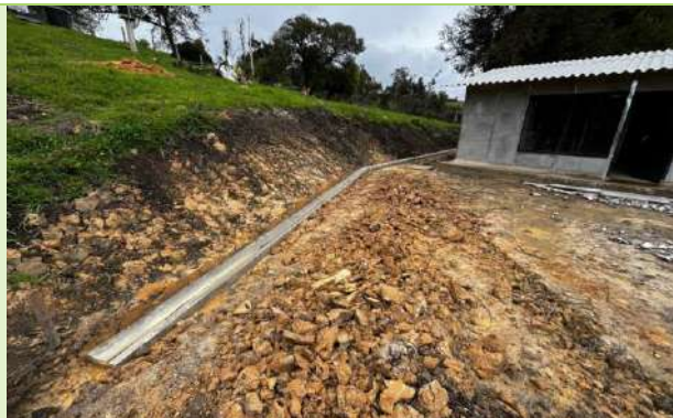
Ilustración 96. Verificación cañuela en la vivienda del Sr. Carlos Arbey Cortes
