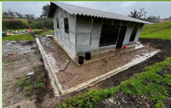
Ilustración 91. Verificación cañuela en la vivienda del Sr. Juan de Jesús Cortes
