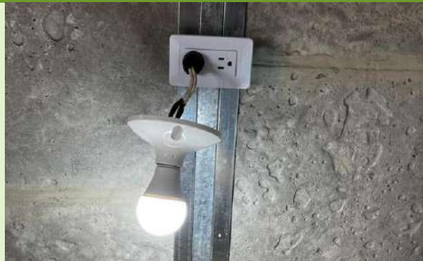
Ilustración 103. Prueba Eléctrica en toma corriente
