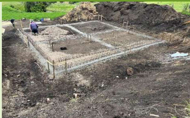
Ilustración 27. Actividades de solado y figurado de acero
