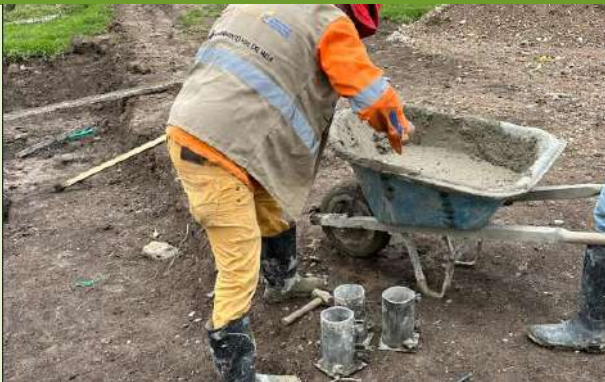
Ilustración 61. Toma de muestras de concreto para ensayo a compresión
