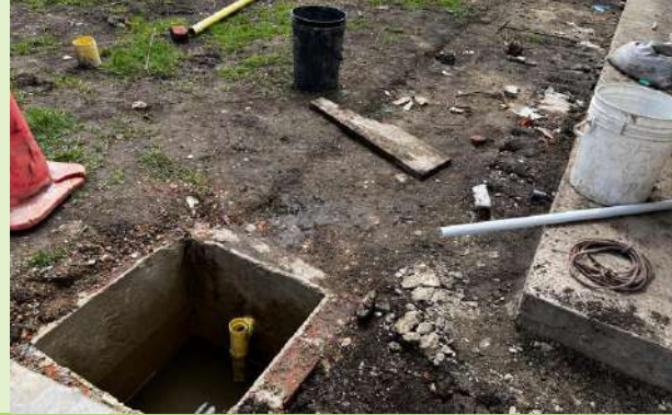
Ilustración 60. Verificación de las trampas de grasas
