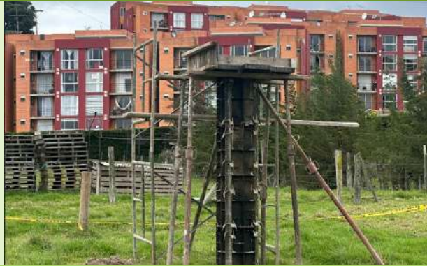
Ilustración 45. Actividades de encofrado de pedestal - tanque de almacenamiento
