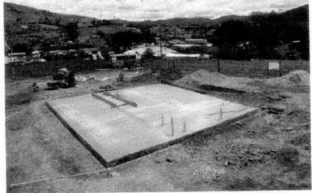
Imagen 2. Placa de cimentacion en concreto.
