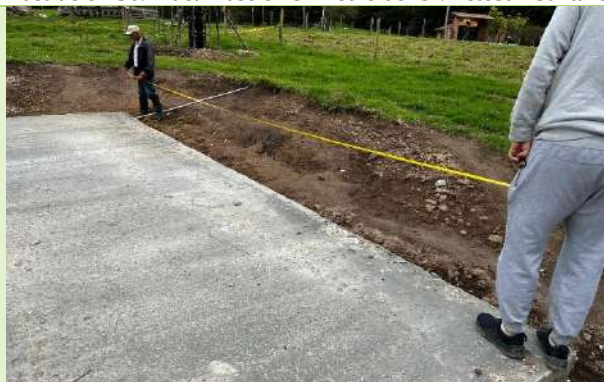
Ilustración 38. Verificación de medidas de placa base en concreto
