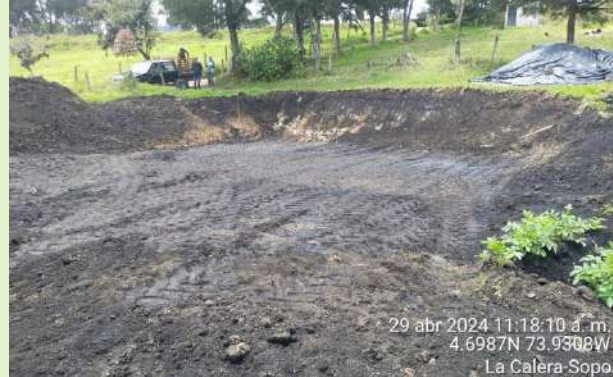
Ilustración 20. Actividades de Excavación predio Sr. Esteban Santana
