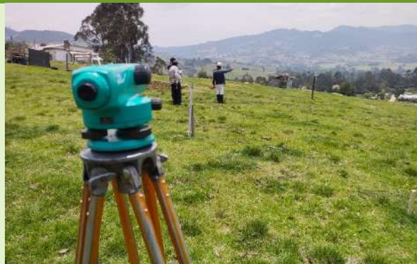
Ilustración 12. Replanteo para nivelación de terreno María Ligia León
