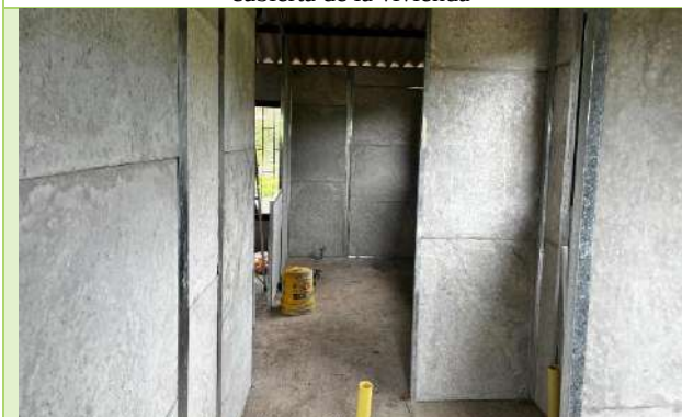
Ilustración 80. Verificación de áreas y acabados de muros y cubierta de la vivienda
