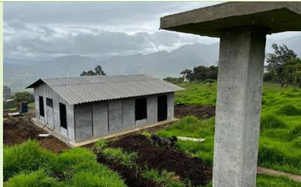
Ilustración 47. Acabado del pedestal para tanque de almacenamiento
