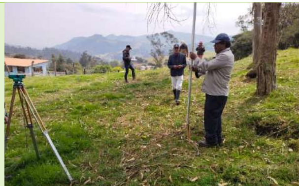
Ilustración 16. Actividades de replanteo para nivelación
