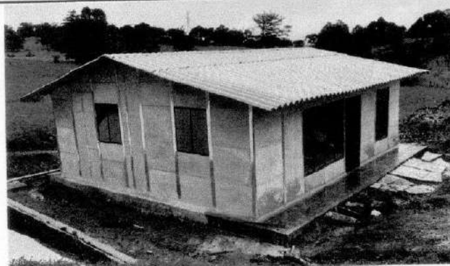
Imagen 6. Vivienda terminada para entrega a beneficiario.
