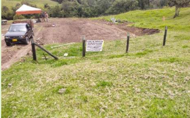
Ilustración 21. Actividades de Excavación predio Sr. Juan de Jesús Cortes
