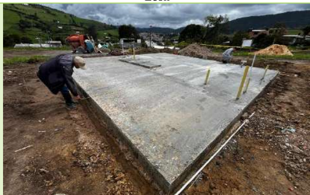
Ilustración 35. Verificación de medidas de la Placa Base
