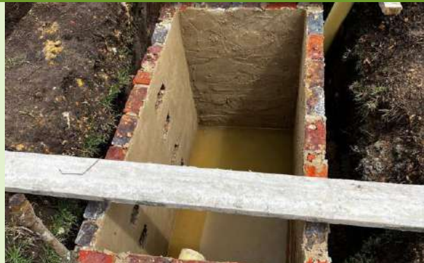
Ilustración 50. Construcción de muros perimetrales y pañete impermeabilizado del pozo séptico
