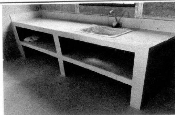
Imagen 4. Mazon en concreto con lavaplatos y griferia.
