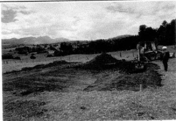
Imagen 1. Excavacion para nivelacion de terreno y conformacion de taludes.
