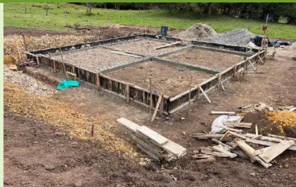
Ilustración 28. Actividades de encofrado de vigas de cimentación y recebo común compactado
