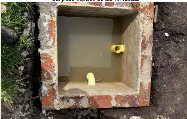
Ilustración 56. Verificación de las trapas de grasas
