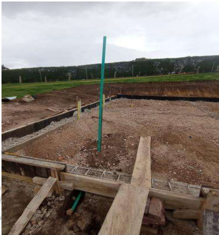
Ilustración 2. Instalación de tubería para acceso de cometa eléctrica
