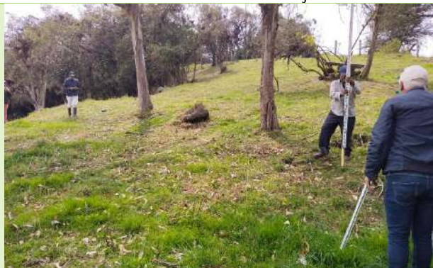
Ilustración 15. Localización y replanteo para nivelación predio Sr. Carlos Arbey Cortes
