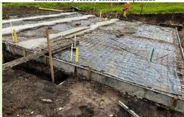
Ilustración 30. Actividades de instalación de refuerzo con malla electrosoldada y construcción de placa base
