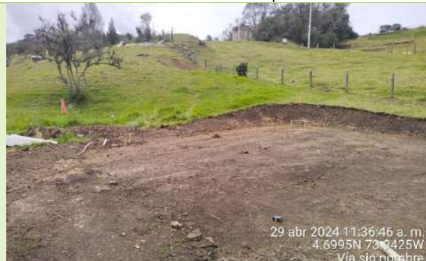
Ilustración 26. Actividades de Excavación predio Sra. Ana Silvia León
