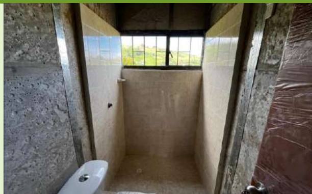
Ilustración 86. Verificación acabados zona húmeda baño
