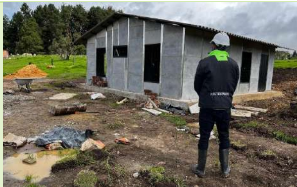
Ilustración 73. Verificación de cada una de las viviendas instaladas
