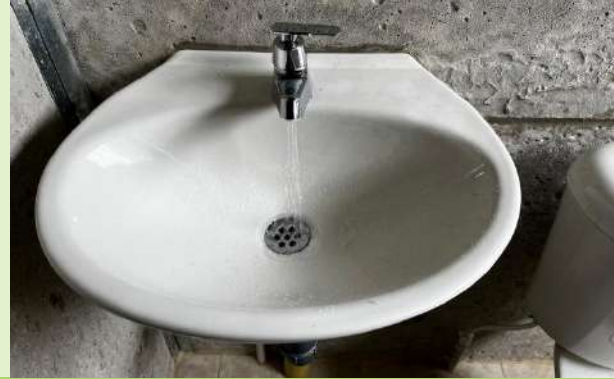
Ilustración 98. Prueba Hidráulica en Lavamanos
