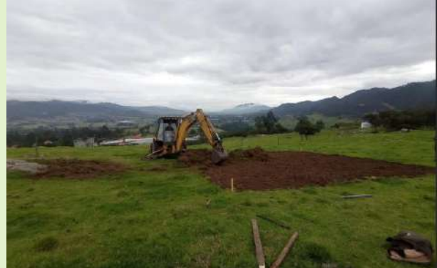
Ilustración 22. Actividades de Excavación predio Sra. María Ligia León
