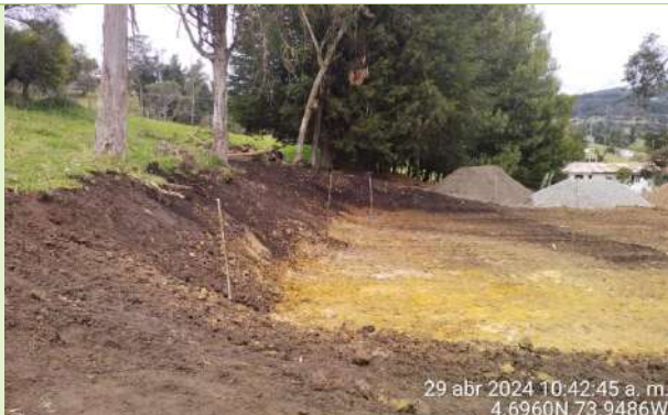
Ilustración 23. Actividades de Excavación predio Sr. Carlos Cortes
