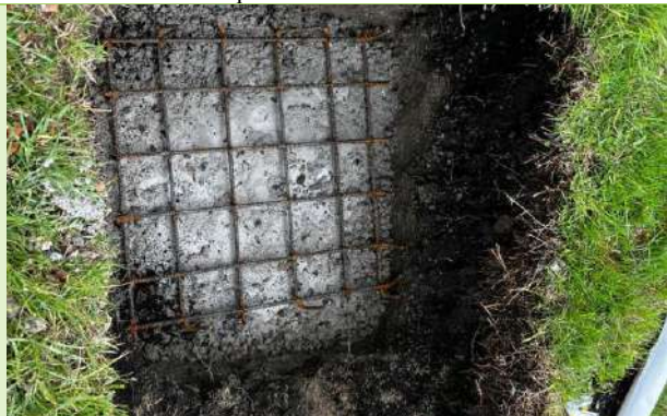
Ilustración 43. Actividades de figurado de acero para parrilla zapata del pedestal - tanque de almacenamiento
