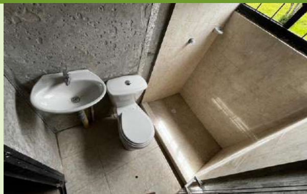
Ilustración 87. Verificación instalación aparatos sanitarios en baño
