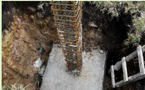
Ilustración 44. Actividades de fundida en concreto reforzado de zapata del pedestal - tanque de almacenamiento
