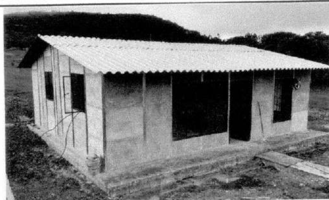
Imagen 6. Vivienda terminada para entrega a beneficiario.
