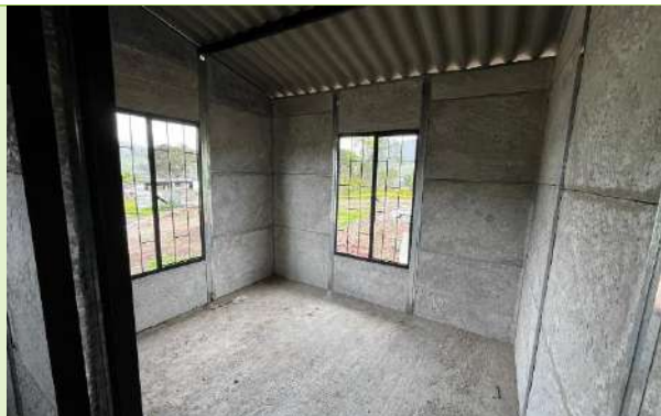
Ilustración 77. Verificación de áreas y acabados de muros y cubierta de la vivienda
