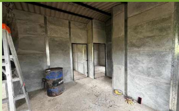
Ilustración 79. Verificación de áreas y acabados de muros y cubierta de la vivienda
