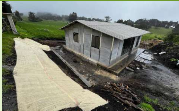
Ilustración 92. Verificación cañuela y biomanto en la vivienda del Sr. Esteban Santana
