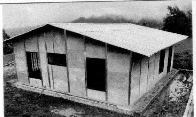
Imagen 6. Vivienda terminada para entrega a beneficiario.
