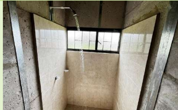
Ilustración 100. Prueba Hidráulica en ducha
