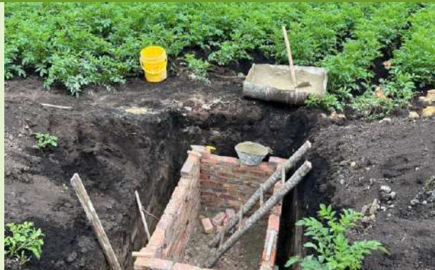
Ilustración 49. Construcción de muros perimetrales del pozo séptico
