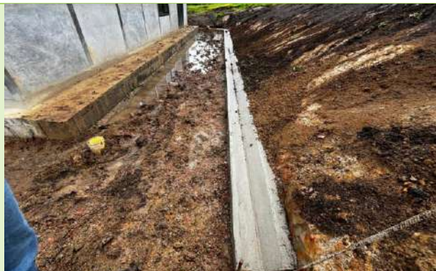
Ilustración 94. Verificación del desarrollo de la cañuela
