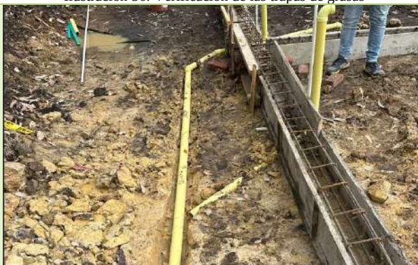
Ilustración 58. Verificación de las conexiones a 45° de las redes sanitarias
