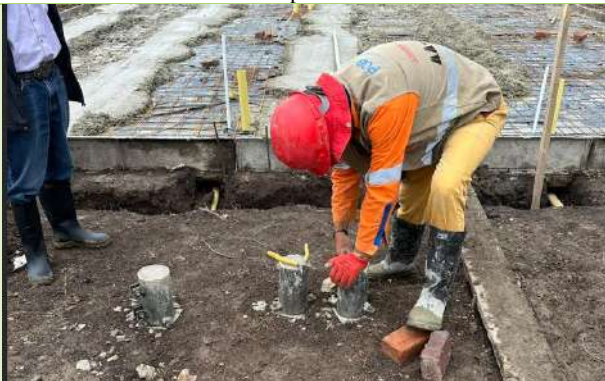
Ilustración 63. Encofrado de muestras
