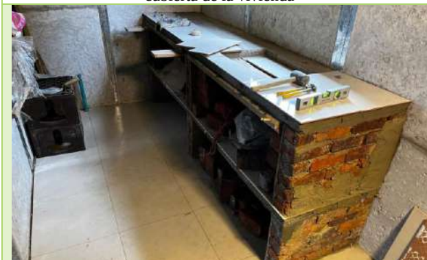
Ilustración 82. Verificación de Construcción mesón cocina
