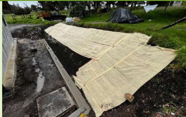
Ilustración 93. Verificación cañuela y biomanto en la vivienda del Sr. Esteban Santana
