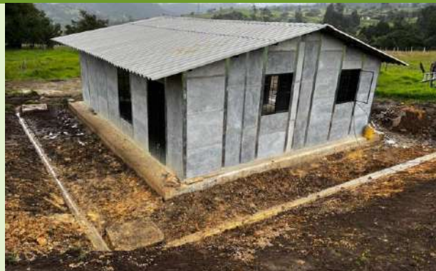
Ilustración 90. Verificación cañuela en la vivienda de la Sra. Ana Silvia León
