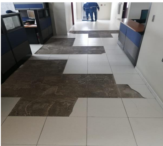
DEMOLICION PISO DE LAS OFICINAS DEL GRUTE
