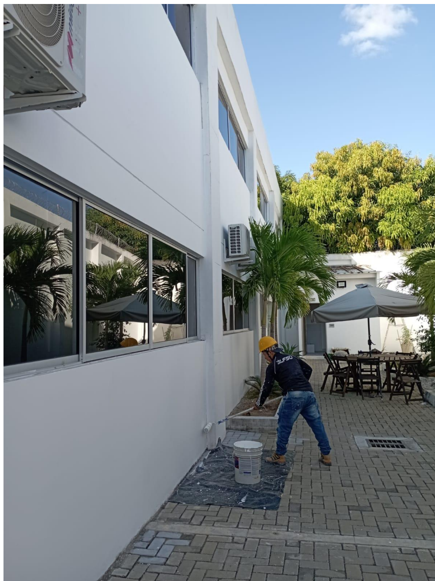
Pintura de muros patio interior trasero
