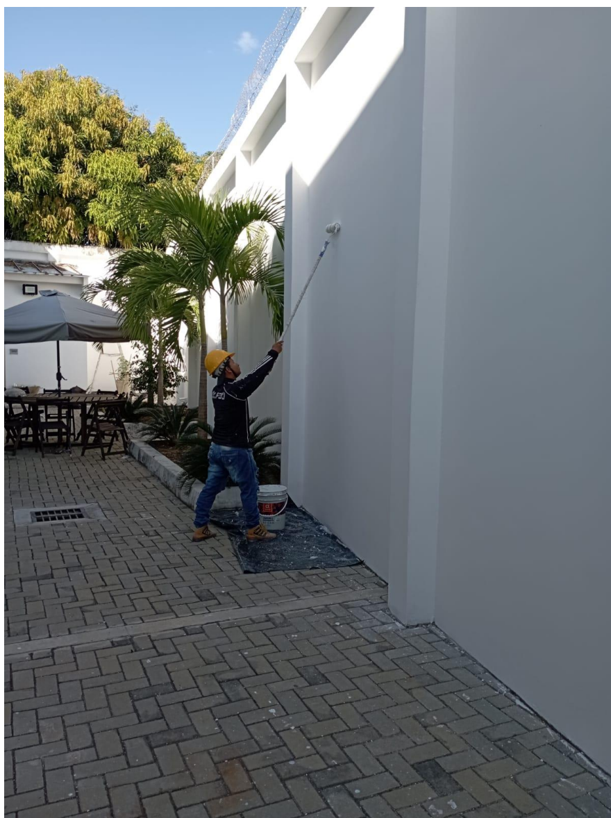
Pintura en muro y columnas (m2 y m)
