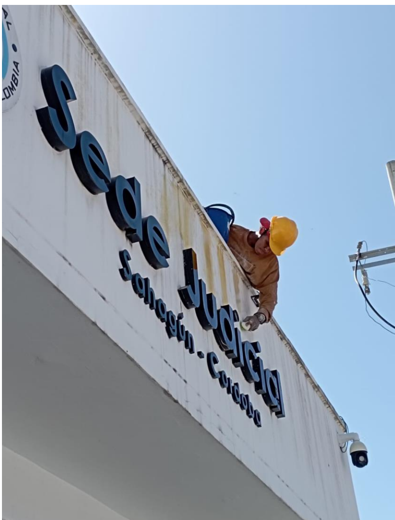
Lavado de muros
