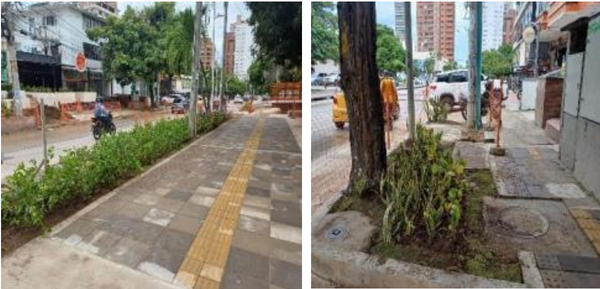
Trabajos de ampliación en la calle 79 desde la carrera 52 a la 51.
