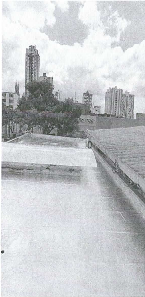
ESTADO ACTUAL DE PLACA CON TRABAJOS DE IMPERMEABILIZACION
