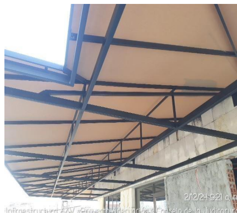
FOTOGRAFIA 14: INSTALACION DE TOLDO EN AREA DE TERRAZA
