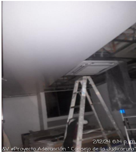
FOTOGRAFIA 7: INST. CIELO RASO PVC
