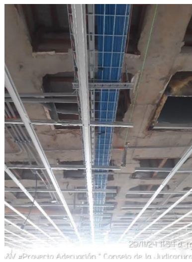
FOTOGRAFIA 24: ESCALERILLA DE 6 *12, PARA TENDIDO DE CALE UTP 6A
