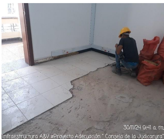
FOTOGRAFIA 11: DEMOLICION DE PISO EN CERAMICA, OFICINA PALACIO DE JUSTICIA
