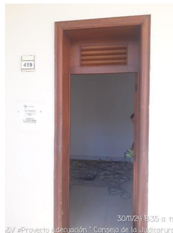
FOTOGRAFIA 12 DEMOLICION DE PISO EN CERAMICA, OFICINA PALACIO DE JUSTICIA
