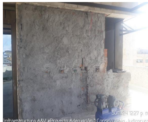
FOTOGRAFIA 16: LEVANTAMIENTO MURO MANPOSTERIA
