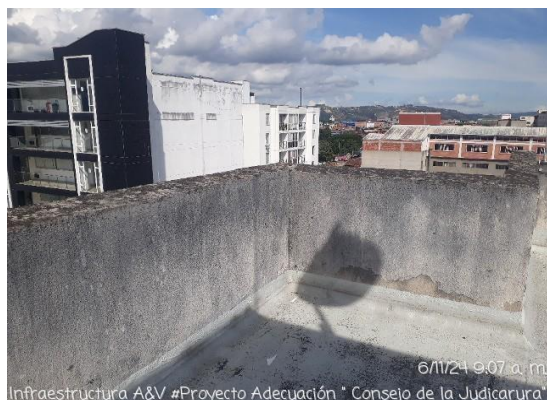
FOTOGRAFIA 10: ESCARIFICADO MURO ANTEPECHO, TERRAZA
