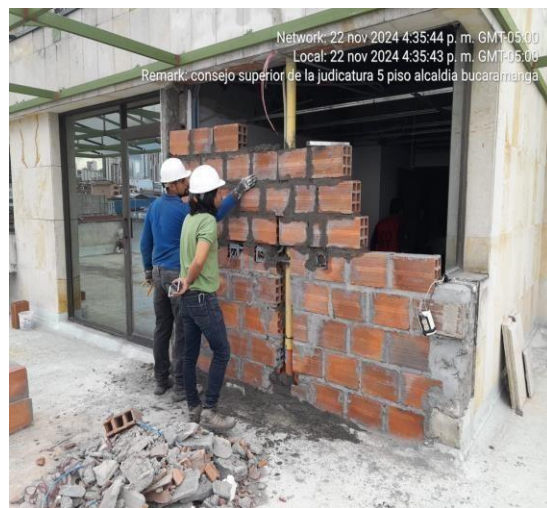
FOTOGRAFIA 6: INST. MURO MANPOSTERIA
