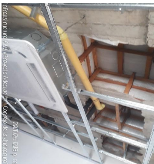
FOTOGRAFIA 21: INSTALACION SE LINEA DE AC. CABLE, TUBERIA COBRE Y RUBATEX
