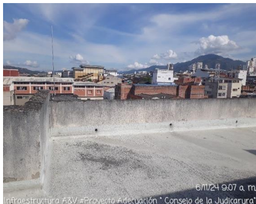
FOTOGRAFIA 9: ESCARIFICADO MURO ANTEPECHO, TERRAZA
