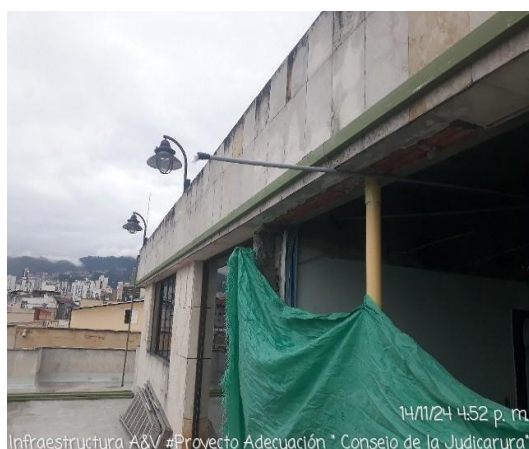
FOTOGRAFIA 15: DEMOLICION DE MURO
