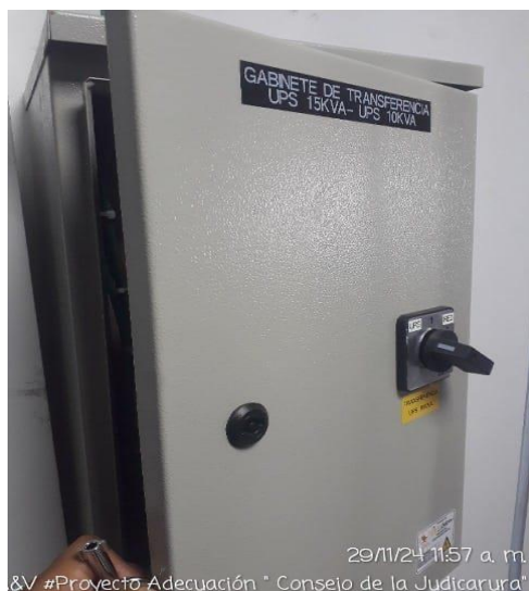
FOTOGRAFIA 19: INSTALACION 5E LINEA DE UPS
