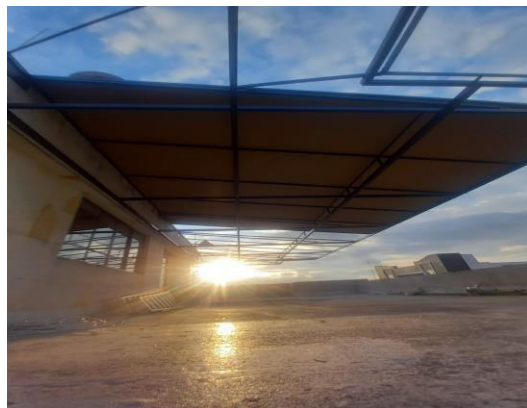
FOTOGRAFIA 13: INSTALACION DE TOLDO EN AREA DE TERRAZA
