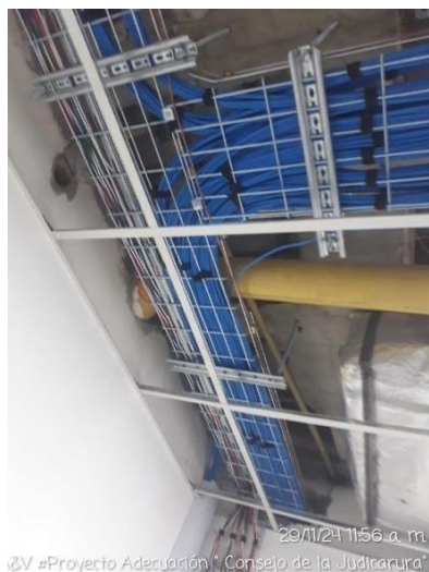
FOTOGRAFIA 23: ESCALERILLA DE 30*12 PARA TENDIDO DE CALE 6ª UTP
