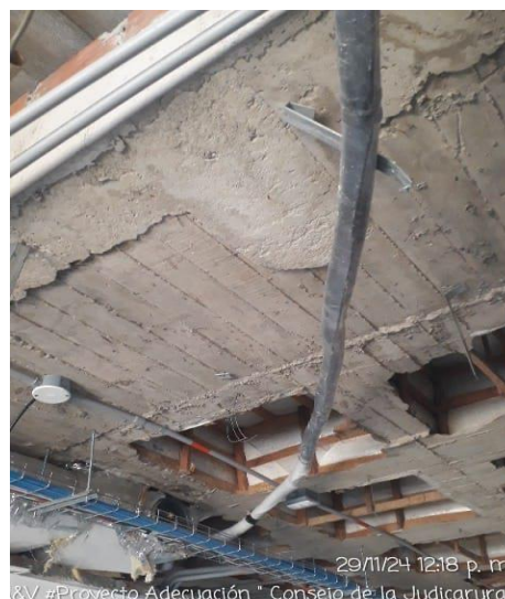
FOTOGRAFIA 22: : INSTALACION SE LINEA DE AC. CABLE, TUBERIA COBRE Y RUBATEX
