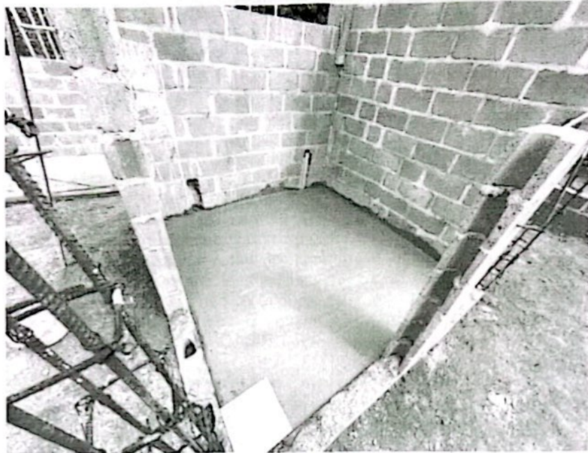
Fotografia 2 Vaciado de concreto para placas de contra piso
