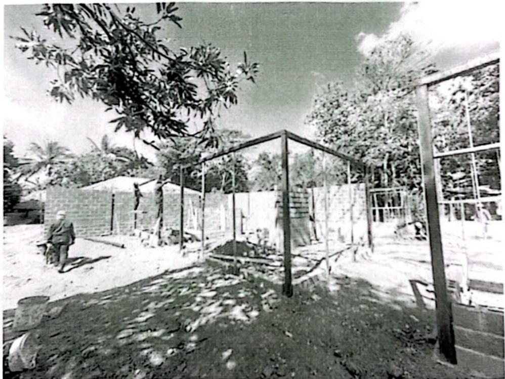
Fotografia 3 Acero estructural para jaulas
