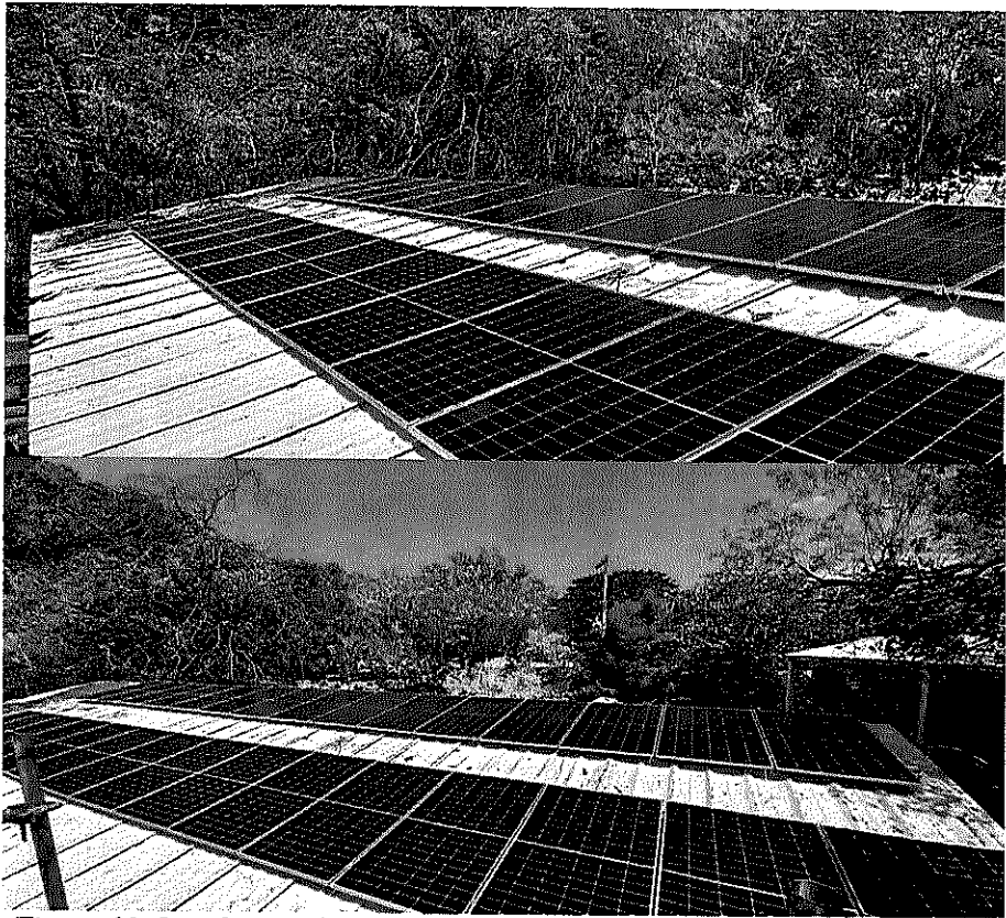
Figura 03. Instalación de paneles monocristalino de 460W/24V media-celda.
