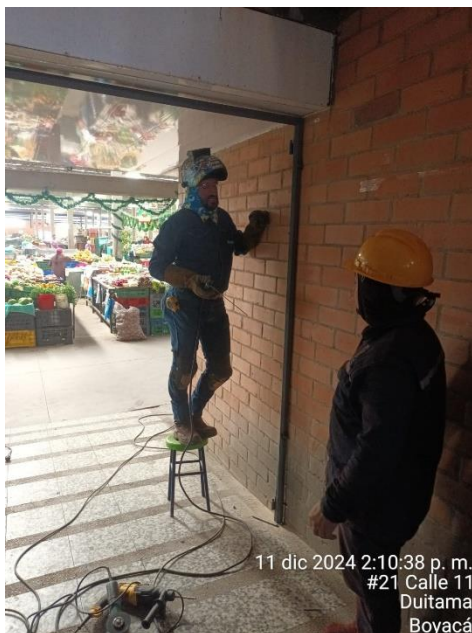
Mantenimiento, limpieza y pintura de puertas Mercaplaza
