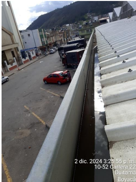
Limpieza de canales
