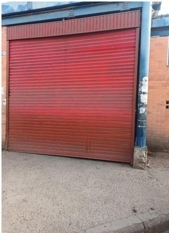
Mantenimiento, limpieza y pintura de puertas Mercaplaza
