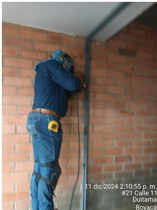
Mantenimiento, limpieza y pintura de puertas Mercaplaza
