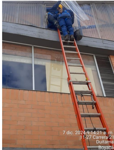
Cambio de tejas plásticas por el frente de Mercaplaza
