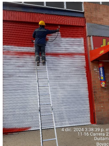
Mantenimiento, limpieza y pintura de puertas Mercaplaza
