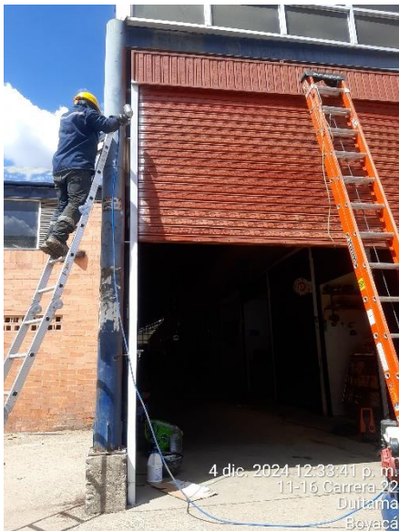
Mantenimiento, limpieza y pintura de puertas Mercaplaza
