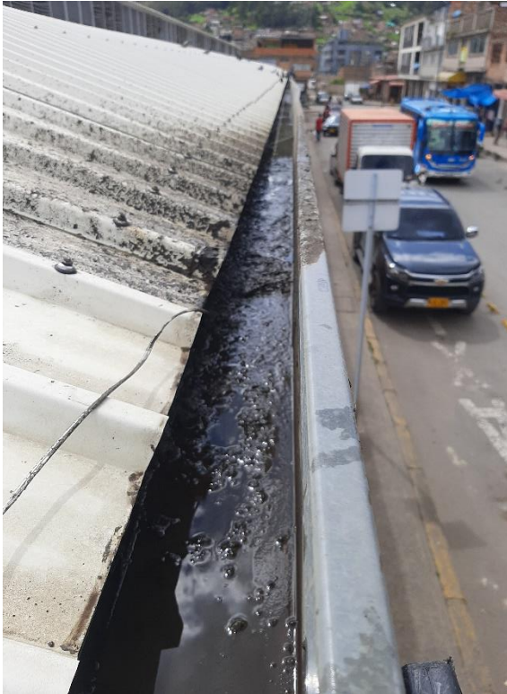
Limpieza de canales
