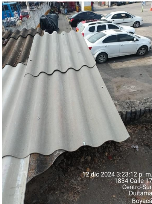
Cambio de tejas plásticas por el frente de Mercaplaza
