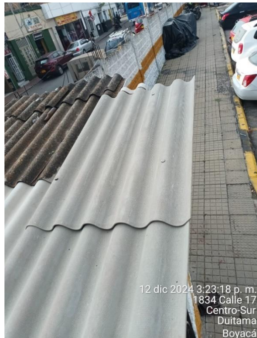
Cambio de tejas plásticas por el frente de Mercaplaza
