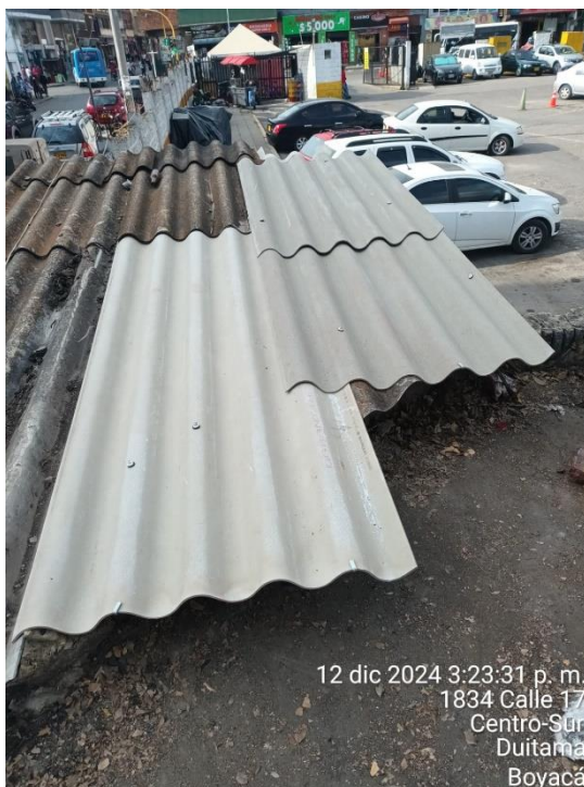
Cambio de tejas plásticas por el frente de Mercaplaza
