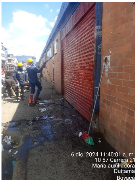
Mantenimiento, limpieza y pintura de puertas Mercaplaza
