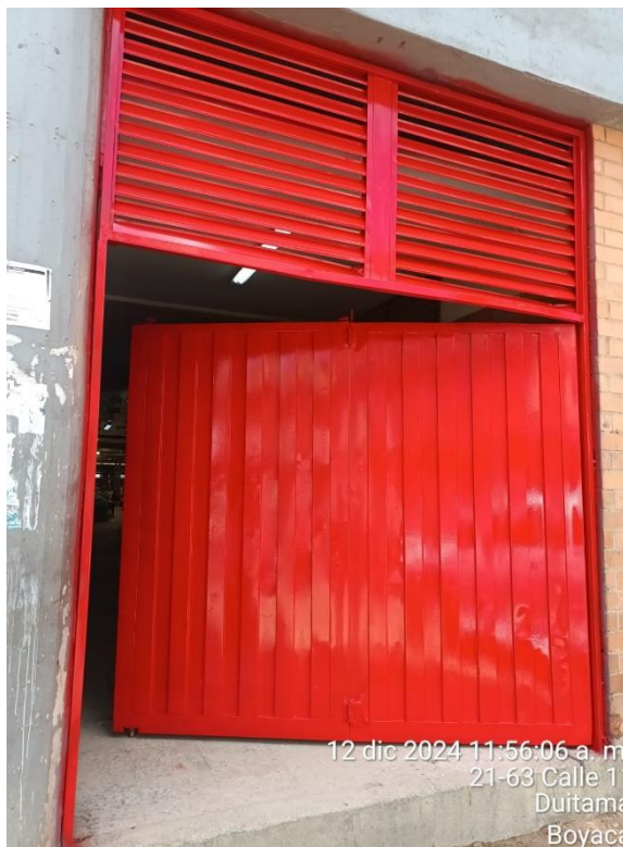
Mantenimiento, limpieza y pintura de puertas Mercaplaza
