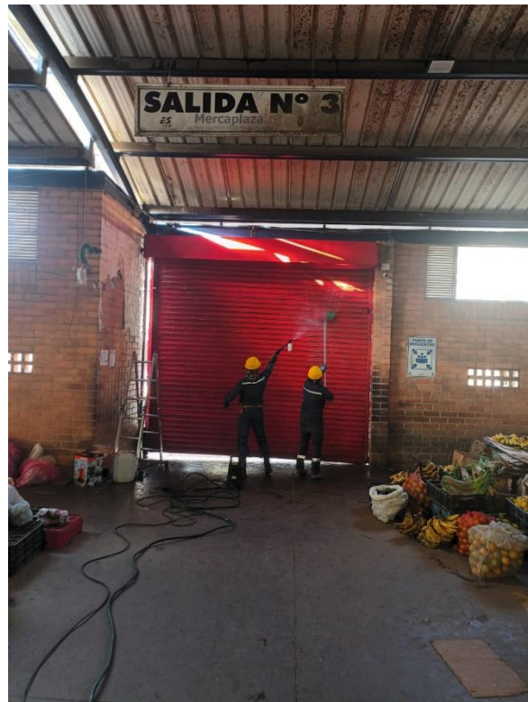
Mantenimiento, limpieza y pintura de puertas Mercaplaza
