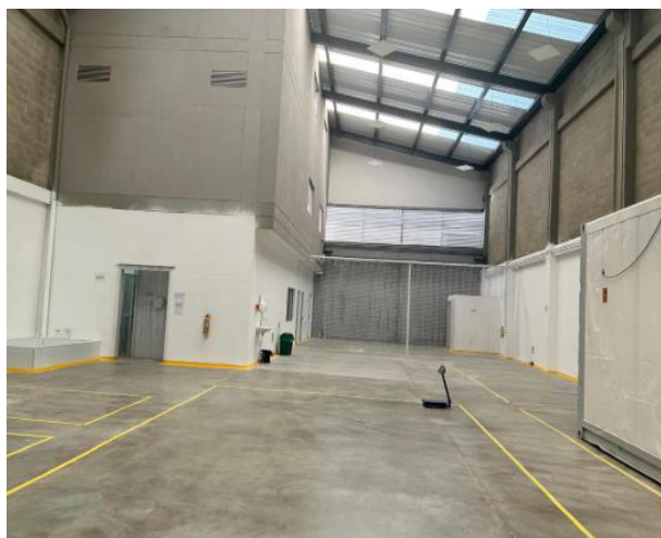
AREA BODEGA DE ALMACENAMIENTO
