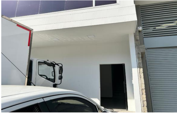
FACHADA ENTRADA BODEGA
