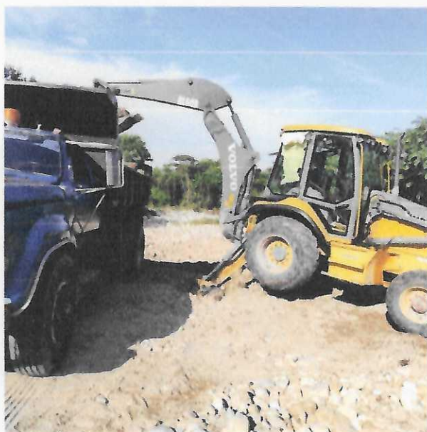
Figura 16: cargue de material para replanteo vial
