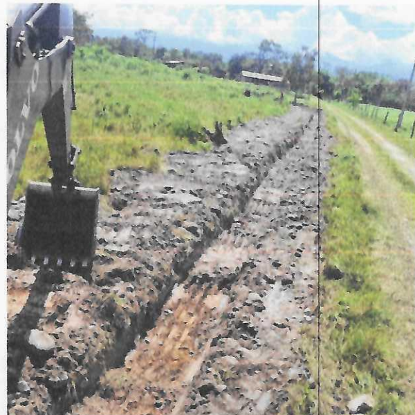
Figura 34: excavación para canal de agua de lluvias
