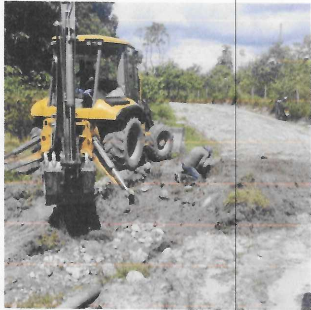
Figura 30: Excavación para acceso de tubería de drenaje de agua de lluvia
