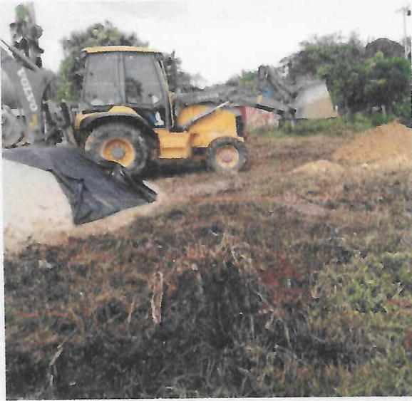
Figura 37: replanteo de terreno
