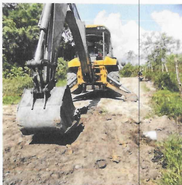
Figura 17: instalación de tubo para drenajes de aguas de lluvias
