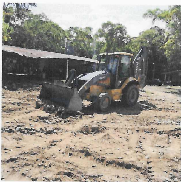
Figura 10: mantenimiento de vía royota
