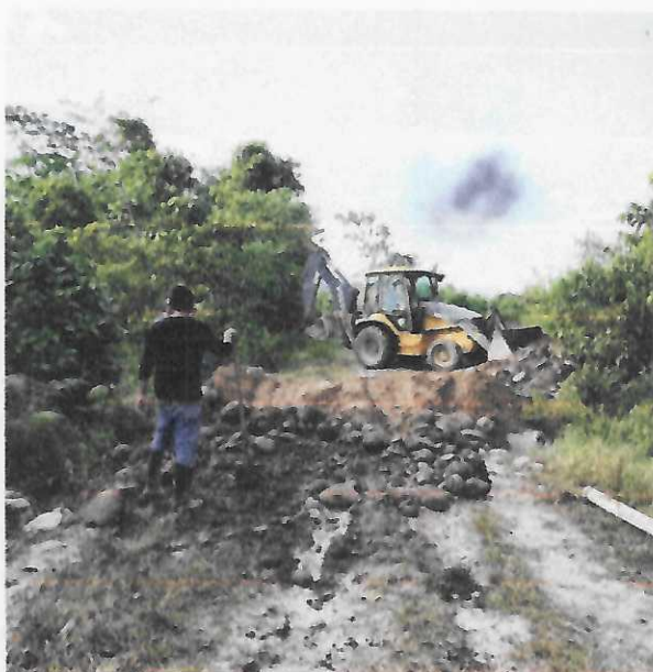
Figura 14: instalación de alcantarillado para drenajes de aguas de lluvias
