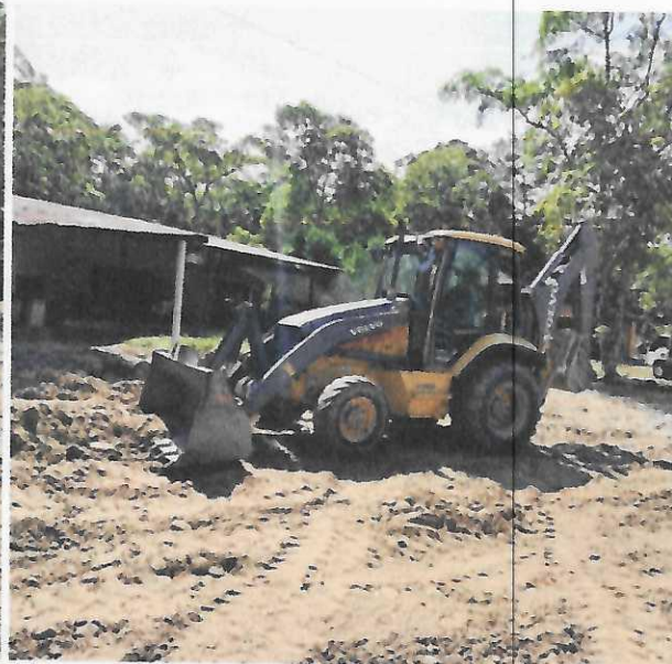
Figura 11: mantenimiento de vía royota
