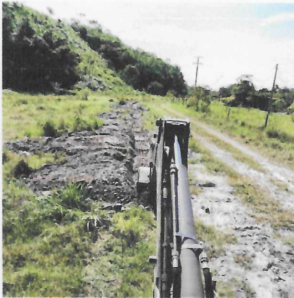
Figura 33: excavación para canal de agua de lluvias
