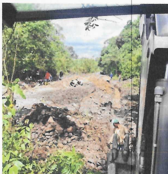
Figura 15: excavación para reubicación de tubería de agua lluvias
