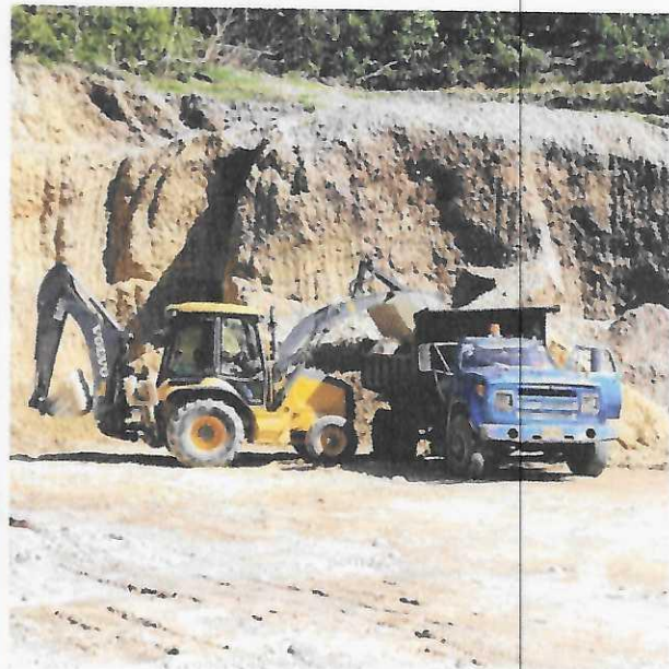
Figura 09: cargue de material para mantenimiento de vía principal el royota
