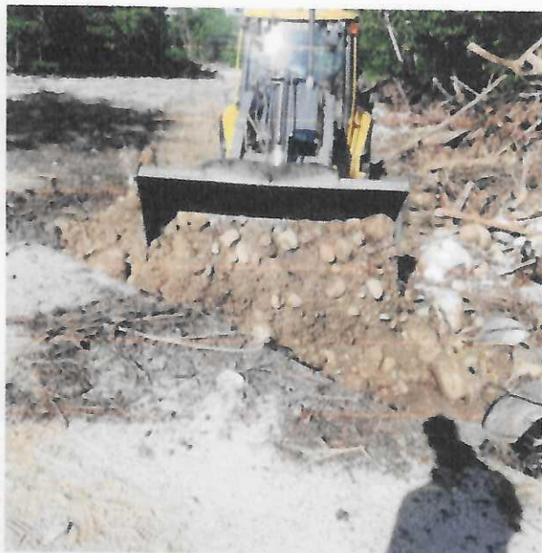
Figura 2: replanteo para parqueadero en el royota
