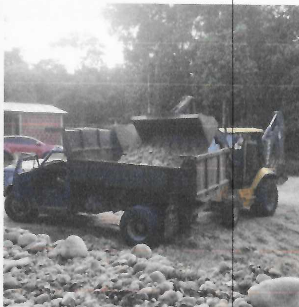
Figura 5: cargue de material pétreo para replanteo de vía royota
