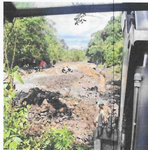
Figura 32: excavación para tubería de agua
