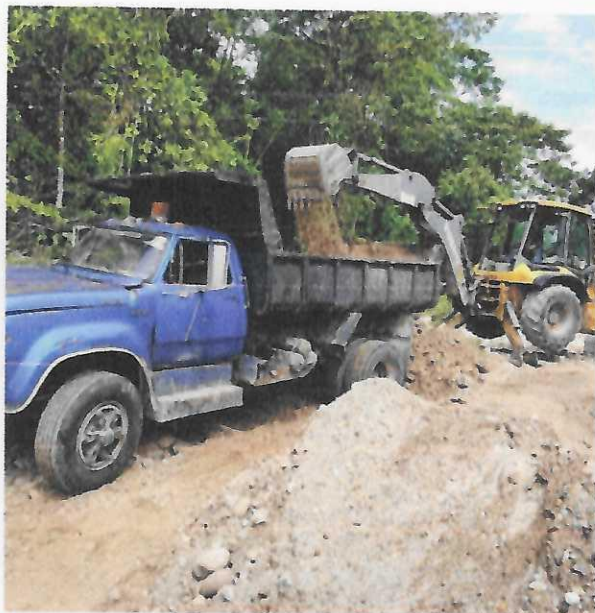
Figura 18: cargue de material para mantenimiento de la vía
