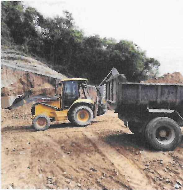
Figura 08: cargue de material para mantenimiento de vía principal el royota
