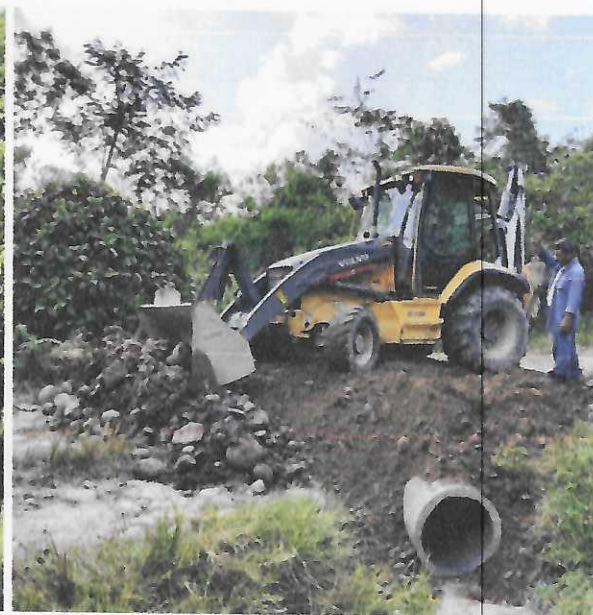
Figura 13: instalación de alcantarillado para drenajes de aguas de lluvias
