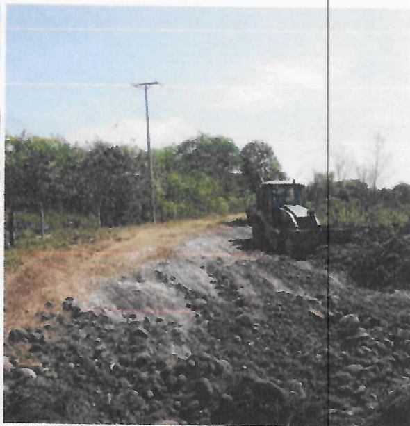
Figura 19: rehabilitación de vía terciaria
