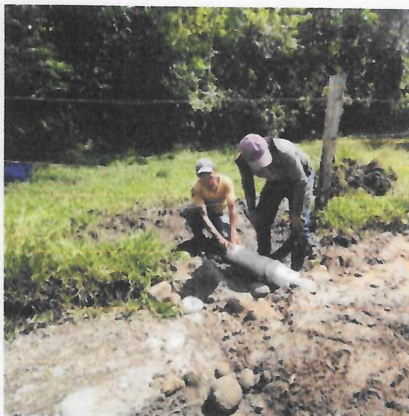
Figura 27: Excavación para acceso de tubería de drenaje de agua de lluvia
