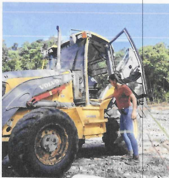
Figura 26: Se realizó de limpieza de la cabina.
