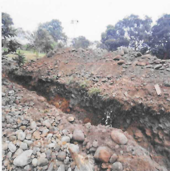
Figura 35: excavación para ejecución de muro de concreto para protección De fuertes crecientes
