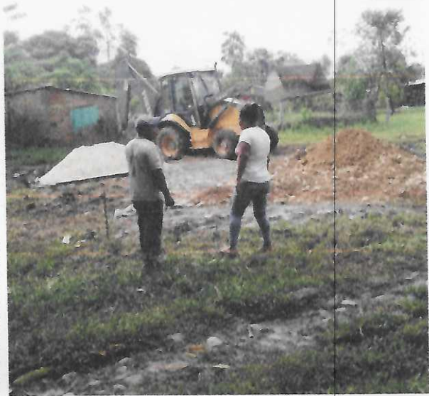
Figura 38: replanteo de terreno
