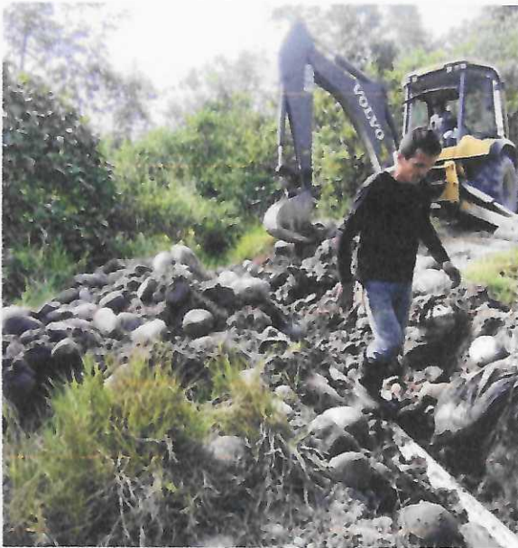
Figura 31: Excavación para acceso de tubería de drenaje de agua de lluvia
