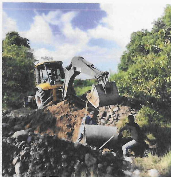
Figura 12: instalación de alcantarillado para drenajes de aguas de lluvias
