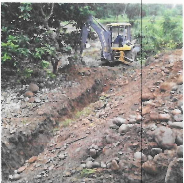
Figura 36: excavación para ejecución de muro de concreto para protección de fuertes crecientes.
