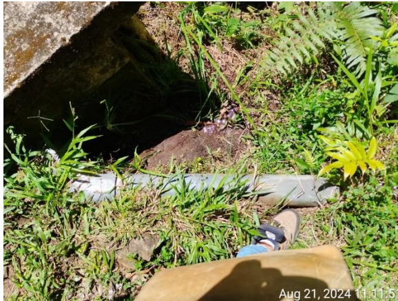
Ilustración 11 Tubería de aducción expuesta susceptible a daños
