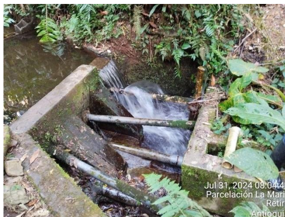
Ilustración 9 Bocatoma
