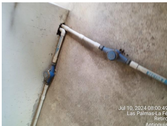
Ilustración 8 Macromedidor
