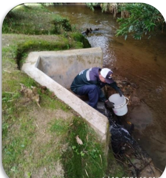
Fotografía 6 - Disposición en el sitio del descole de las aguas residuales al Río Pantanillo (salida)
