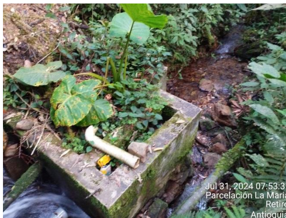
Ilustración 10 Desarenador
