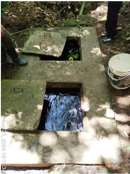
Ilustración 6 Desarenadores
