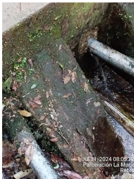
Ilustración 13 Fugas y reparaciones poco técnicas
