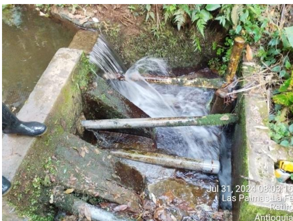
Ilustración 9 Bocatoma
