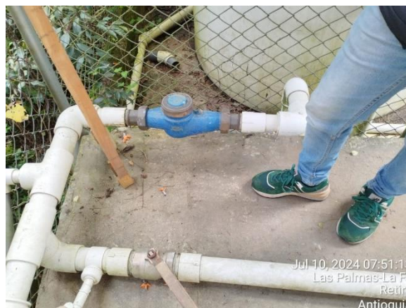
Ilustración 8 Macromedidor
