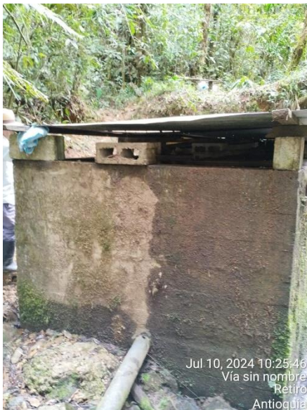
Ilustración 14 Desarenador
