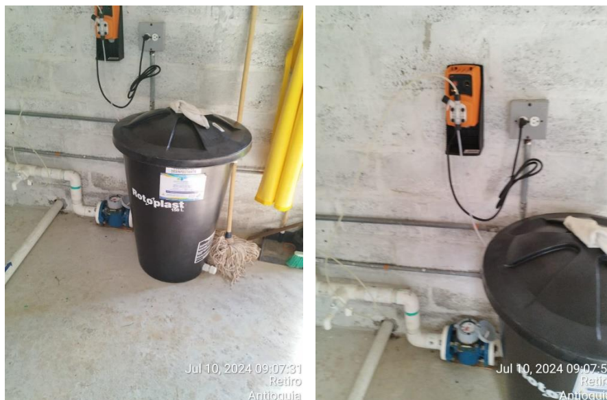
Ilustración 23 Macromedidor
