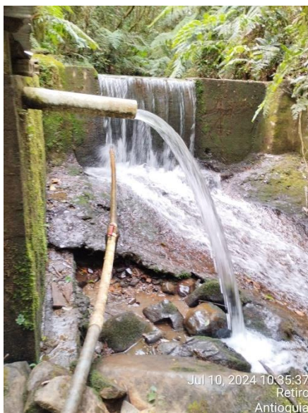
Ilustración 13 Bocatoma
