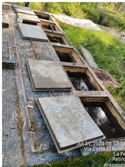
Ilustración 15 Estructuras en predios privados que son de uso compartido con otros usuarios
