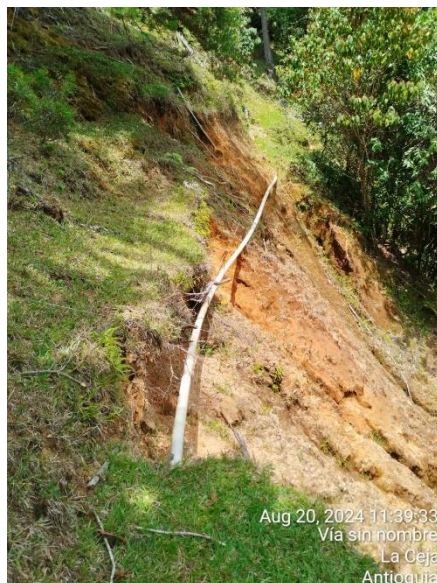
Ilustración 15 Tubería de aducción instalada en suelos inestables
