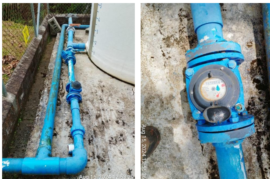
Ilustración 15 Macromedidor
