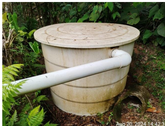
Ilustración 9 Desarenadores
