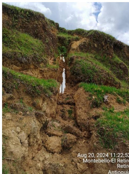
Ilustración 15 Tubería de aducción instalada en suelos inestables
