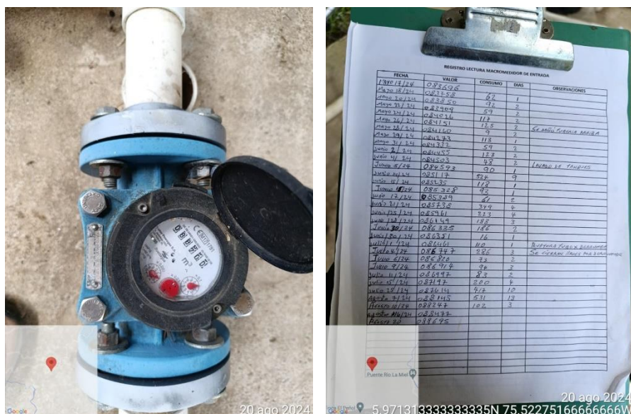
Ilustración 17 Macromedidor
