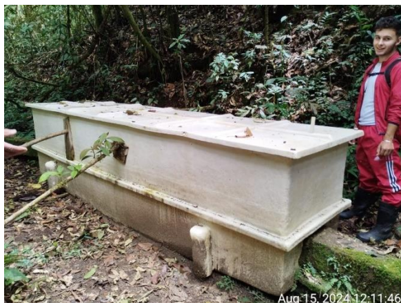
Ilustración 9 Desarenadores
