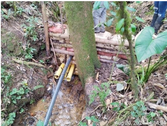
Ilustración 8 Bocatoma
