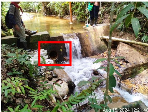
Ilustración 13 Reparaciones poco técnicas en zona de captación
