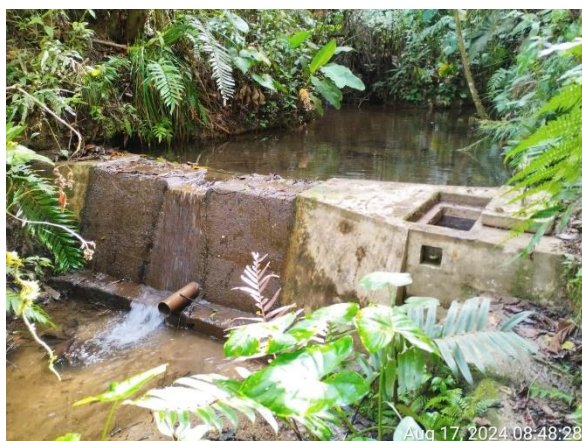
Ilustración 4 Bocatoma
