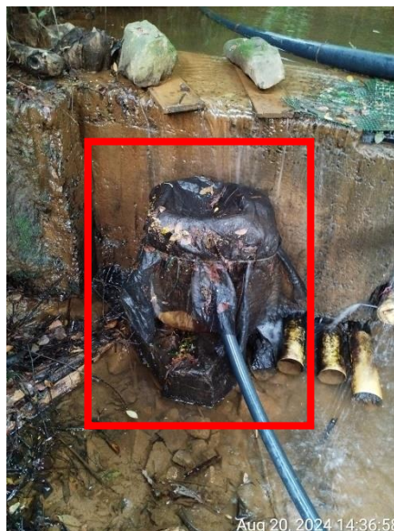
Ilustración 13 Reparaciones poco técnicas en zona de captación
