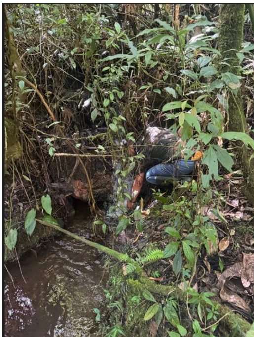
Fotografía 4 – Punto de recolección (bocatoma)
