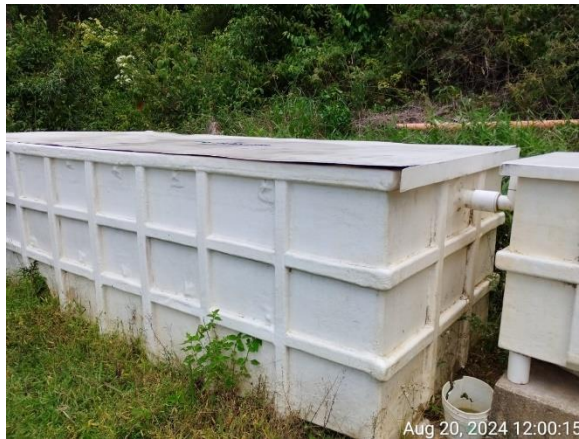
Ilustración 8 Desarenador
