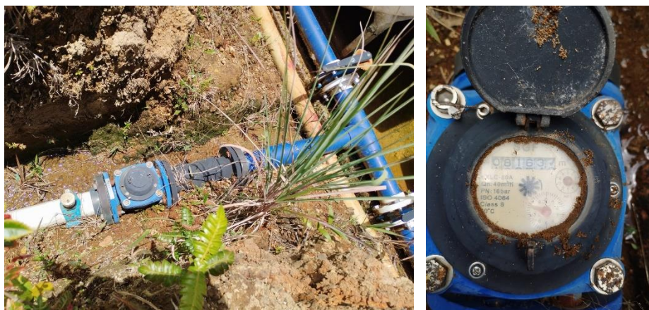
Ilustración 13 Macromedidor
