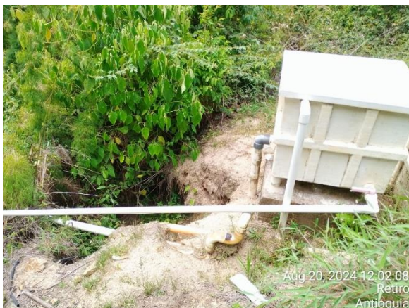
Ilustración 13 Erosión cerca a desarenador
