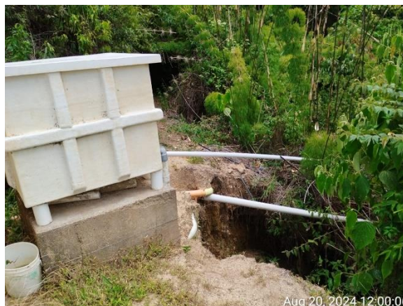
Ilustración 13 Erosión cerca a desarenador
