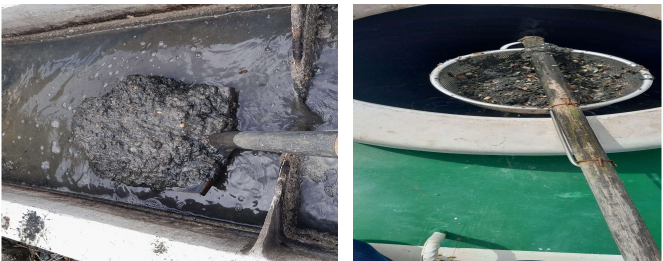
Figura 3 y 4. Retiro y disposición de las natas.
