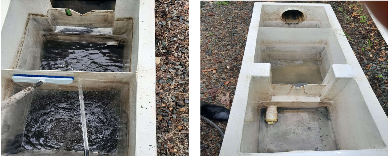
Figura 7 y 8. Mantenimiento del canal de salida.
