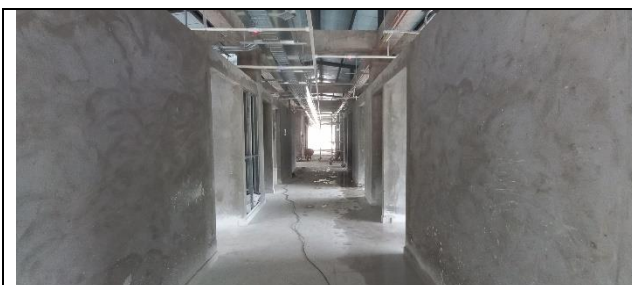
Aplicación estuco muro interior
