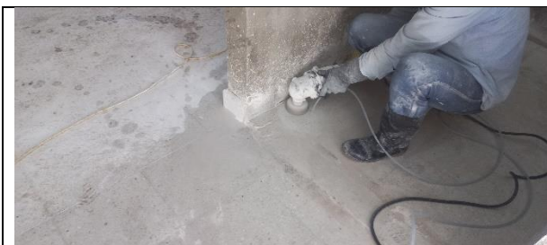
Pulida de baldosa-zócalo-mediacaña
