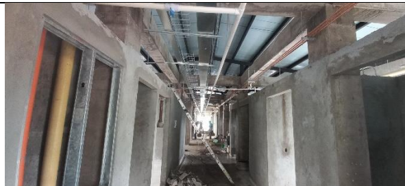
Instalación red eléctrica
