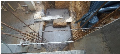
Concreto puente conexión
