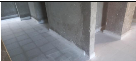
Instalación baldosa-zócalo-mediacaña
