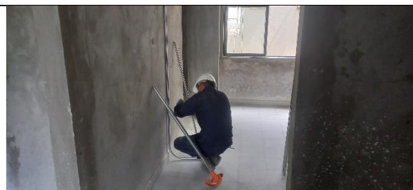
Instalación red eléctrica
