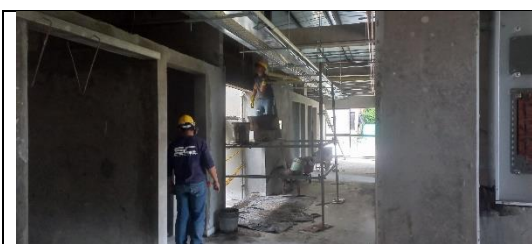
Instalación de revoque
