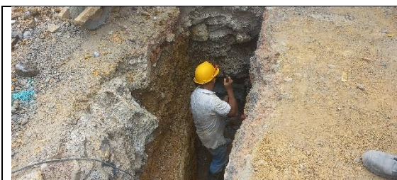
Excavación manual red sanitaria
