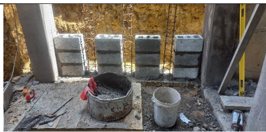
Instalación mampostería puente conexión
