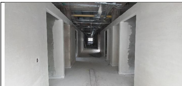
Aplicación estuco muro interior
