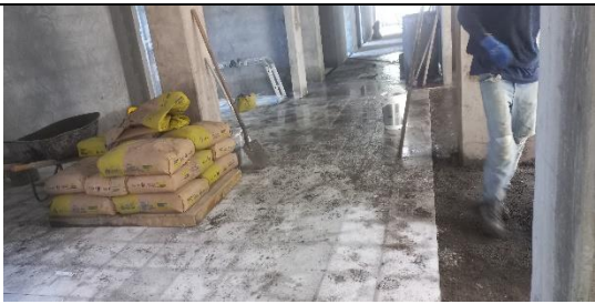
Instalación de piso
