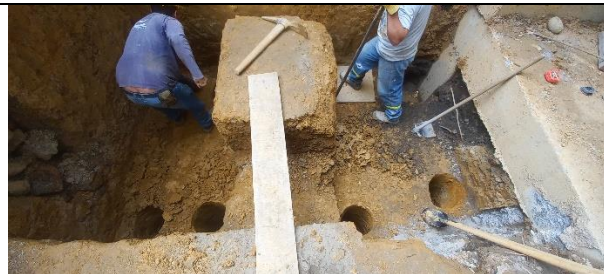
Excavación manual cimentación puente conexión
