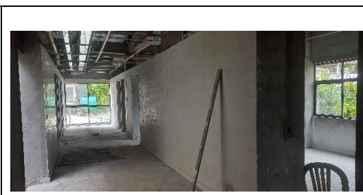
Aplicación estuco muro interior
