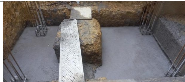
Concreto puente conexión
