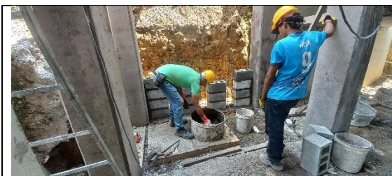
Instalación mampostería puente conexión
