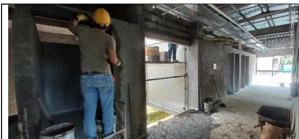
Instalación de revoque
