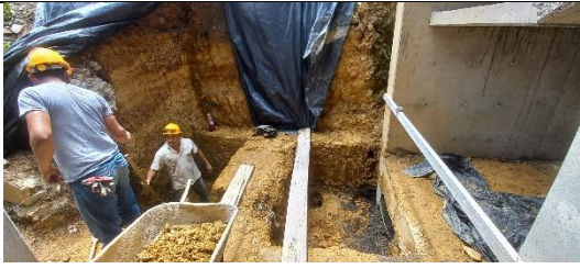
Excavación manual cimentación puente conexión
