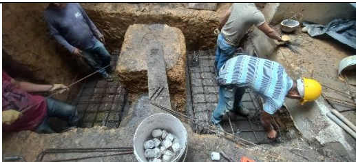
Acero refuerzo puente conexión
