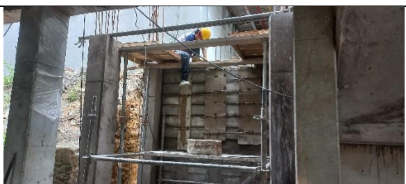
Instalación mampostería puente conexión
