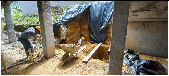
Excavación manual cimentación puente conexión
