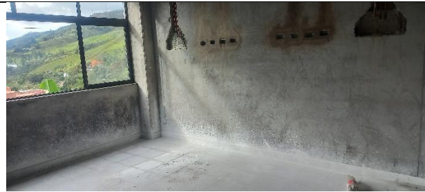
Instalación red gases medicinales
