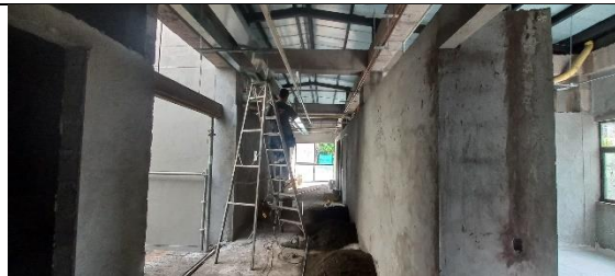
Pañete muro interior
