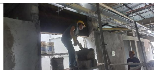
Instalación de revoque
