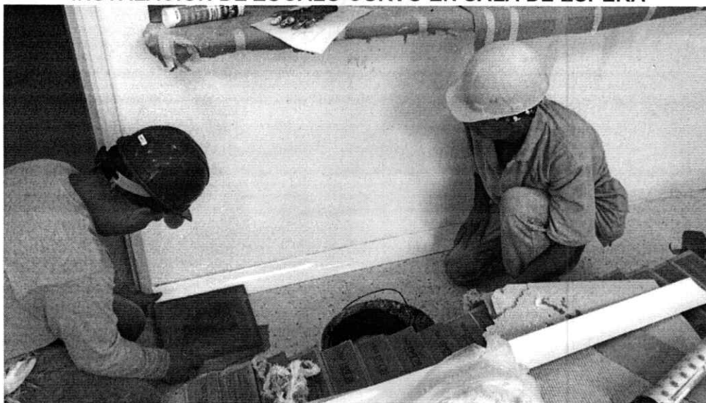
INSTALACION DE ZOCALO CURVO EN SALA DE ESPERA
