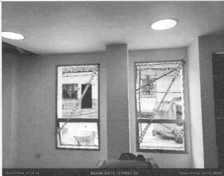
FOTO 11: INSTALACION DE VENTANAS ZONA DE URGENCIAS
