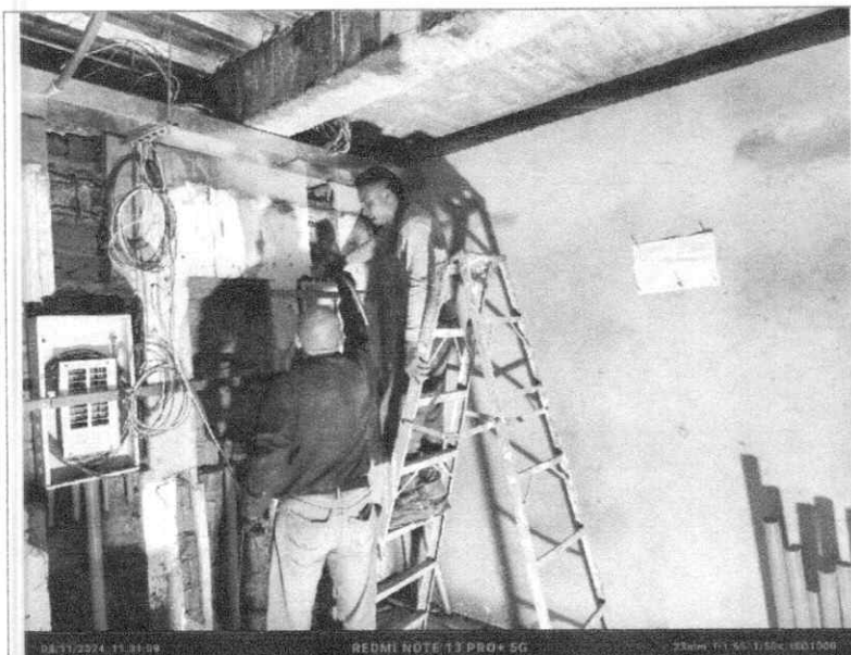
FOTO 13: INSTALACION DE TABLERO ELECTRICO
