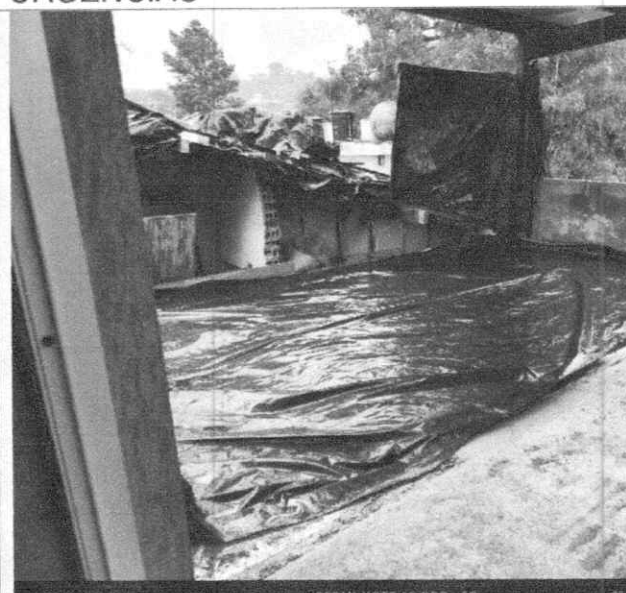
FOTO 8: TERMINACION DE VACIADO DE MORTERO
