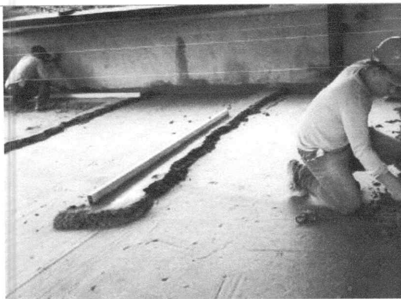
FOTO 7: VACIADO DE MORTERO
