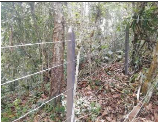
Foto 152. Aislamiento con 4 líneas de alambre de púa
