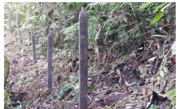
Foto 129. Labores de hincado
