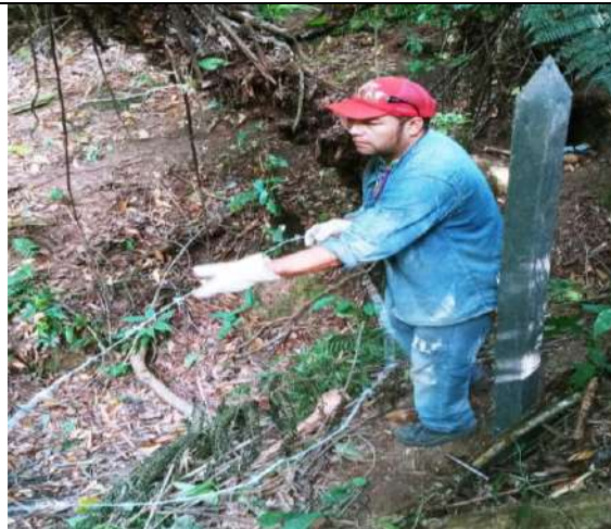
Foto 69. Templado del alambre
