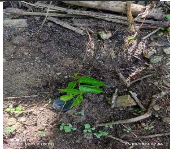
Foto 304. Cerca viva ejecutada
