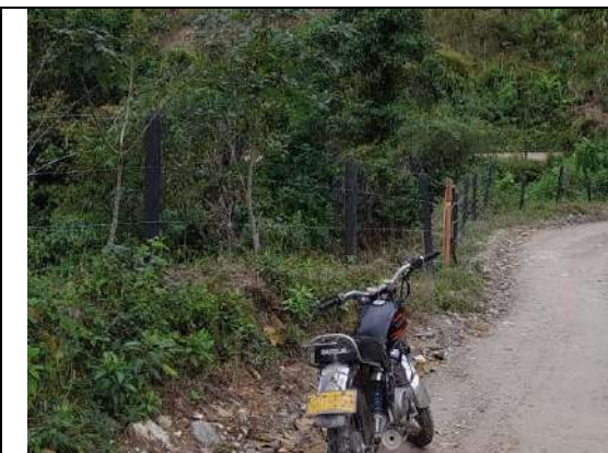
Foto 208. Tramo de aislamiento ejecutado
