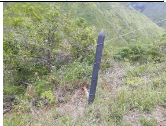
Foto 36. Ejecución de cerco protector
