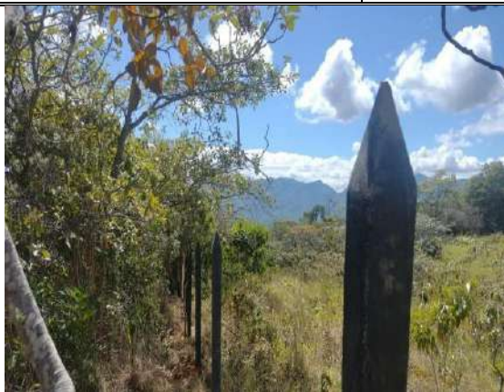
Foto 79. Línea con postes hincados
