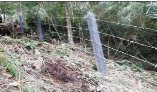
Foto 146. Ejecución de cerco con 4 líneas de alambre de púa
