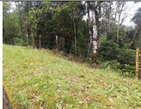
Foto 165. Tramo de aislamiento finalizado
