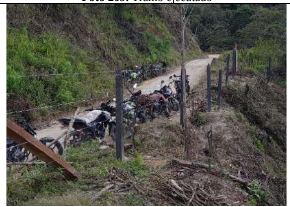
Foto 211. Tramo de cerco ejecutado
