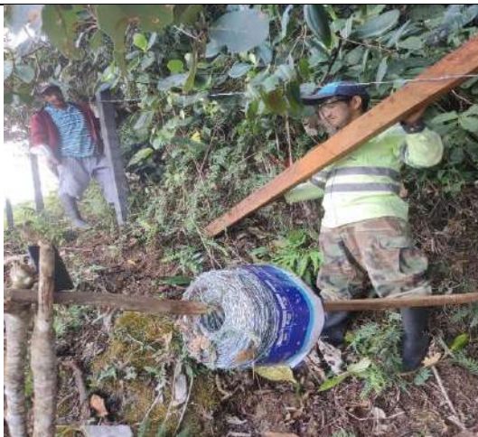
Foto 108. Riego de alambre, templado y grapado
