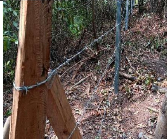
Foto 127. Ejecución del aislamiento
