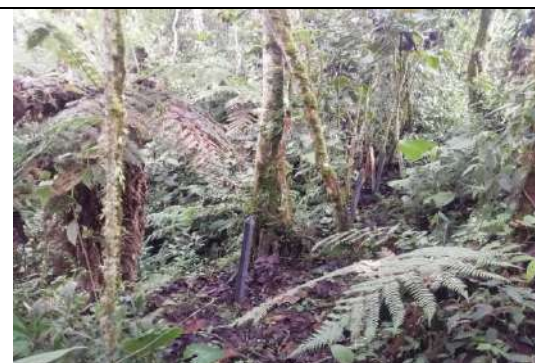
Foto 40. Labores de hincado y apretado de postes
