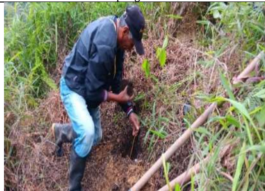
Foto 232. Labores de adecuación del hoyo
