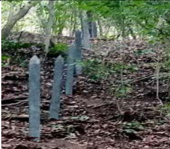
Foto 124. Hincado de postes
