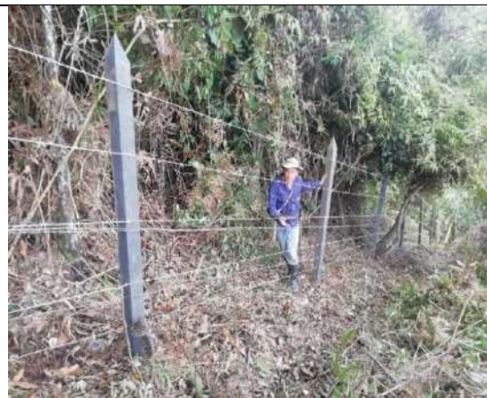
Foto 153. Cerco protector ejecutado
