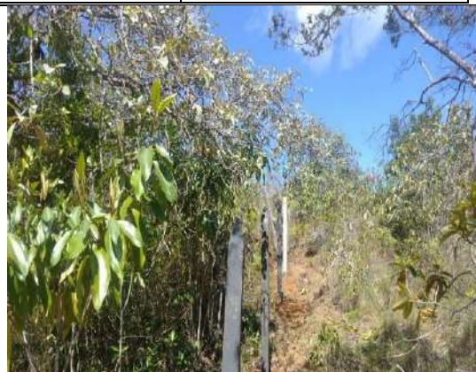
Foto 80. Hincado de postes
