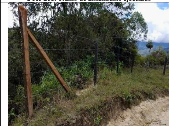
Foto 210. Aislamiento con sus cuatro líneas de alambre
