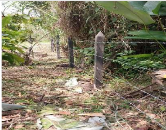
Foto 142. Labores de templado y grapado de alambre
