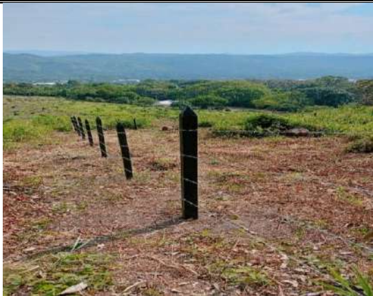
Foto 106. Cerco protector terminado
