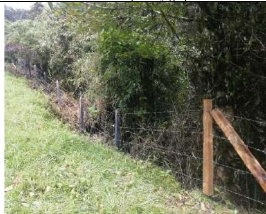
Foto 164. Tramo de cerco finalizado
