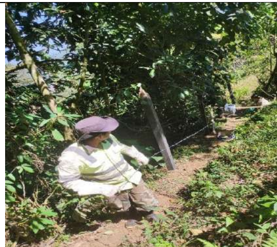
Foto 109. Templado del alambre
