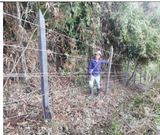
Foto 151. Cerco con alambre de púa y poste plástico
