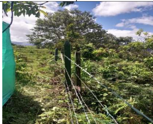
Foto 52. Ejecución de cerco protector
