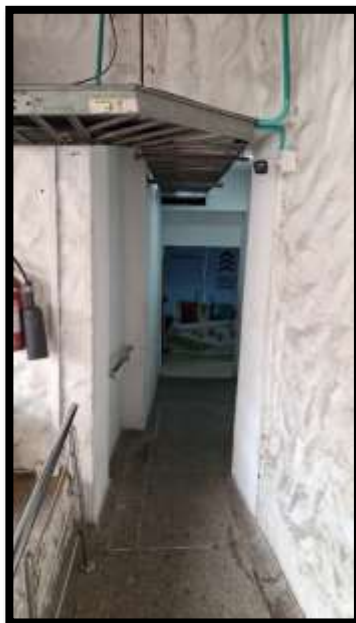
PASILLO ENTRADA PERSONAL LADO PARQUEADERO
