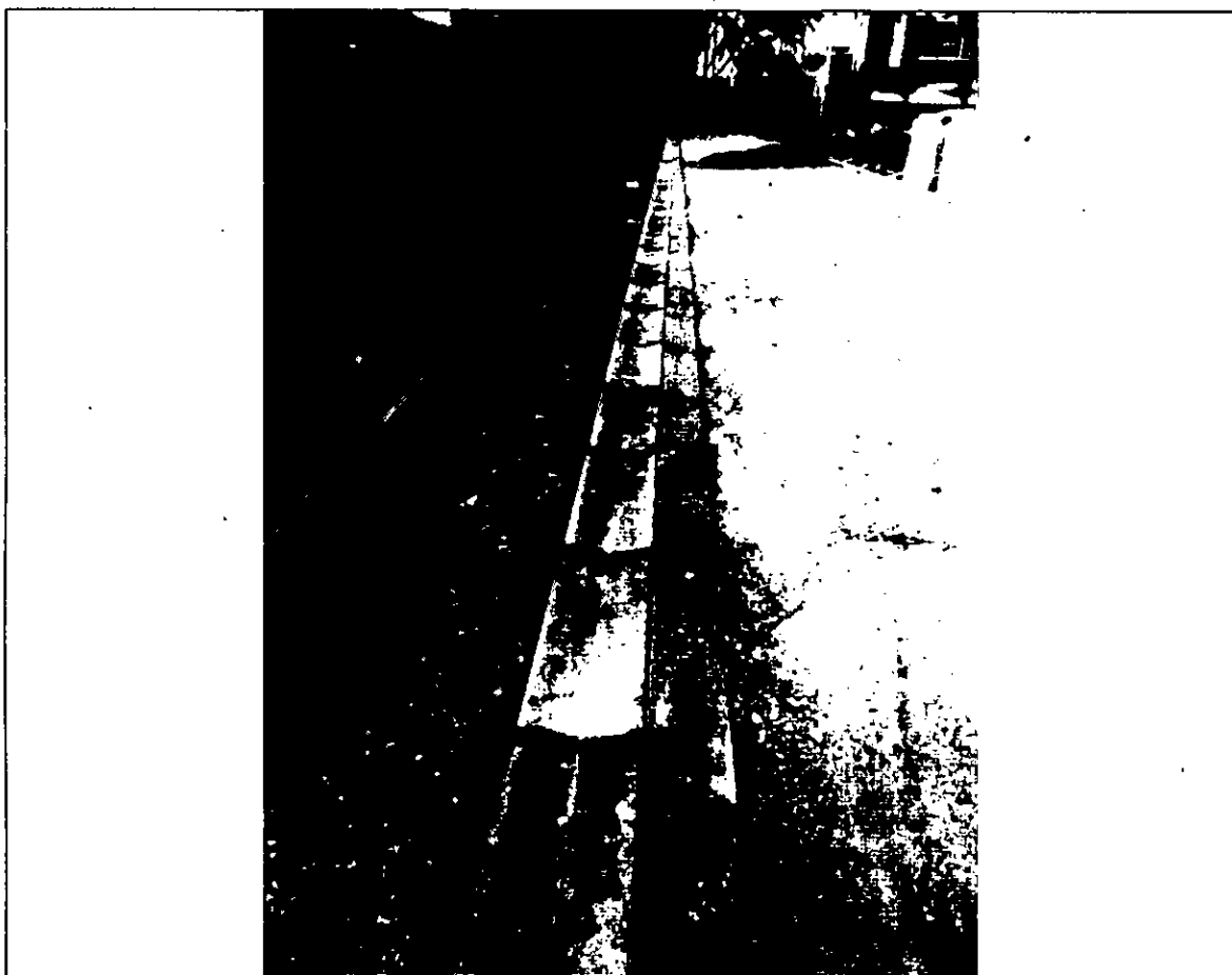
Cañuela A-120 prefabricada sendero sur
