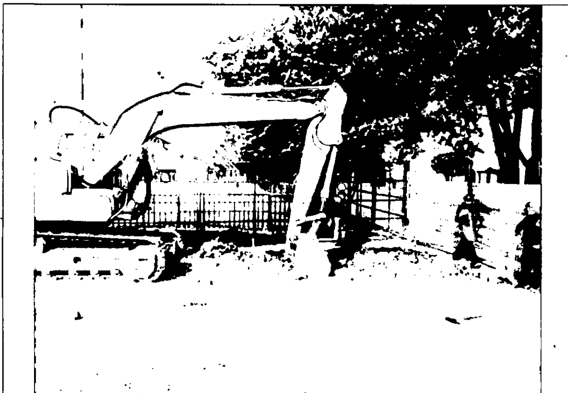
Excavación sendero sur
