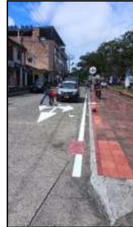
PINTURA DE LINEA DE BORDE.
