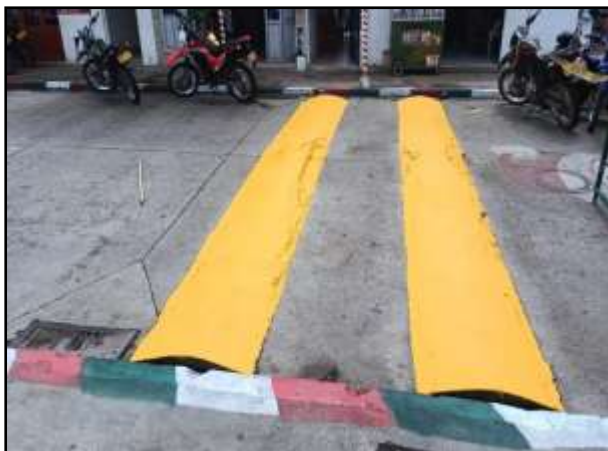
PINTURA DE REDUCTORES DE VELOCIDAD.
