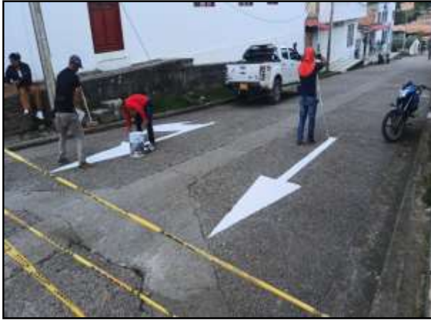
PINTURA DE SEÑALES HORIZONTALES.
