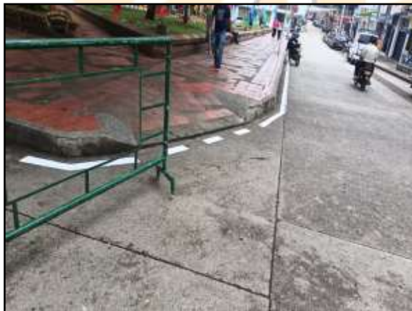
PINTURA DE LINEA DE BORDE.
