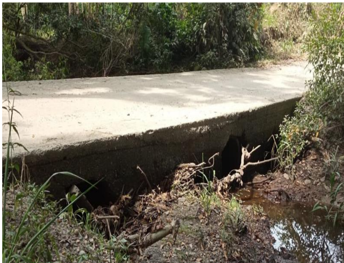
Ilustración 2 – Estado actual de la vía a intervenir en La Vereda El Japón
