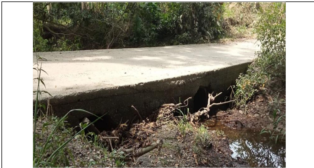
Registro fotográfico – Estado actual de la vía a intervenir en La Vereda El Japón.
