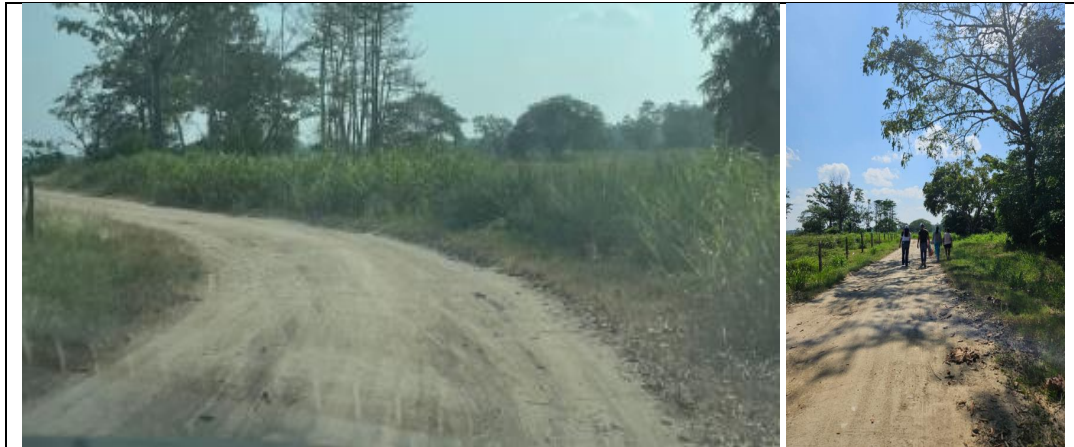
Ilustración 2 – Estado actual de la vía a intervenir en el corregimiento Buenavista.
