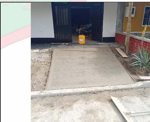
FUNDICIÓN ACCESOS VIVIENDAS
