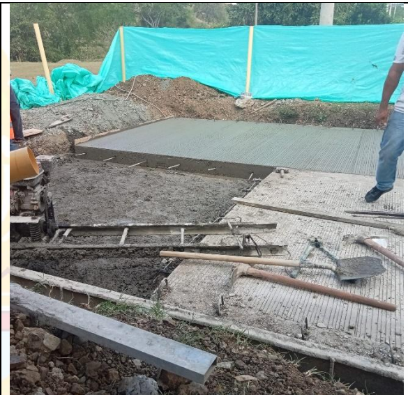
FUNDICIÓN PAVIMENTO RÍGIDO
