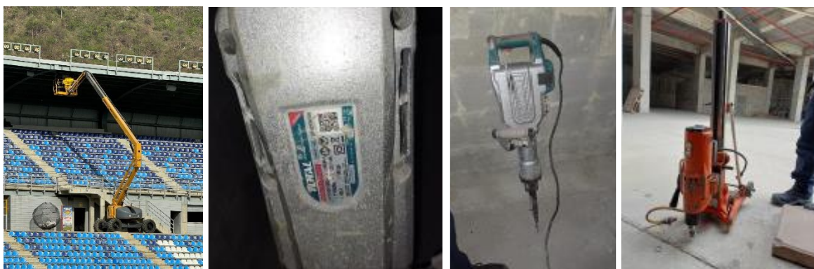
Ilustración 2. Máquinas y herramientas en obra.
