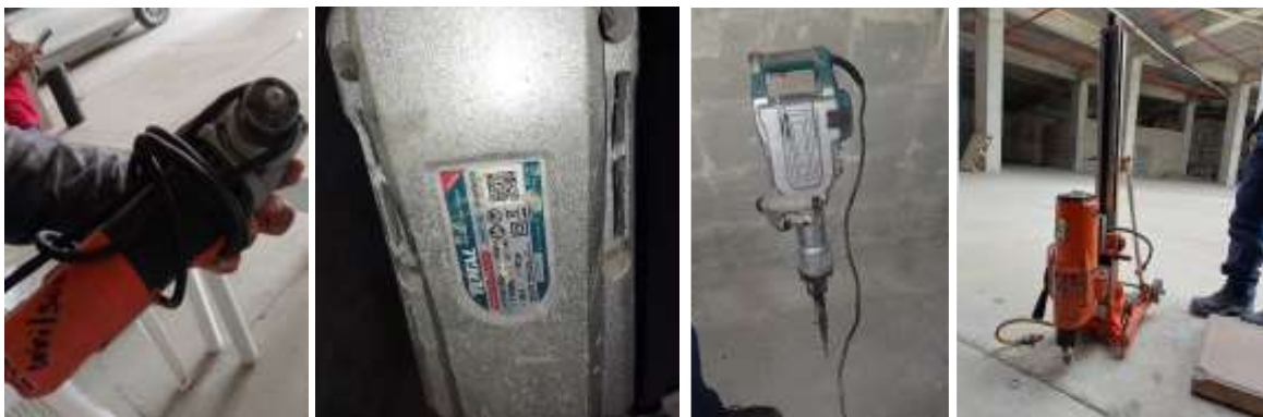
Ilustración 2. Máquinas y herramientas en obra.
