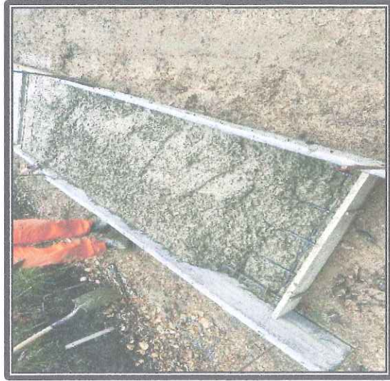
CONCRETO CICLÓPEO CLASE G, 2000 40% RAJÓN PARA BASES
