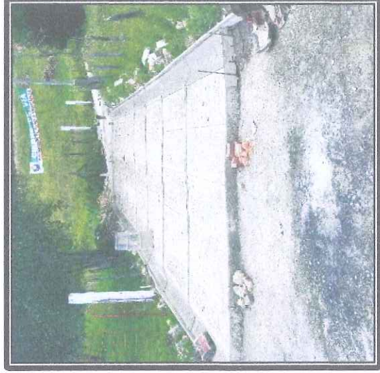
CONCRETO CICLÓPEO CLASE G, 2000 40% RAJÓN PARA BASES
