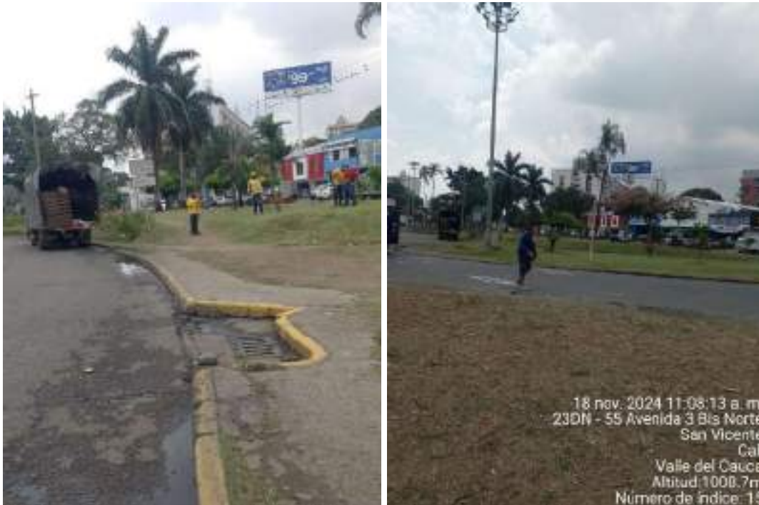
Limpieza mecánica- Plateo de la Rotonda Terminal de Transporte.
