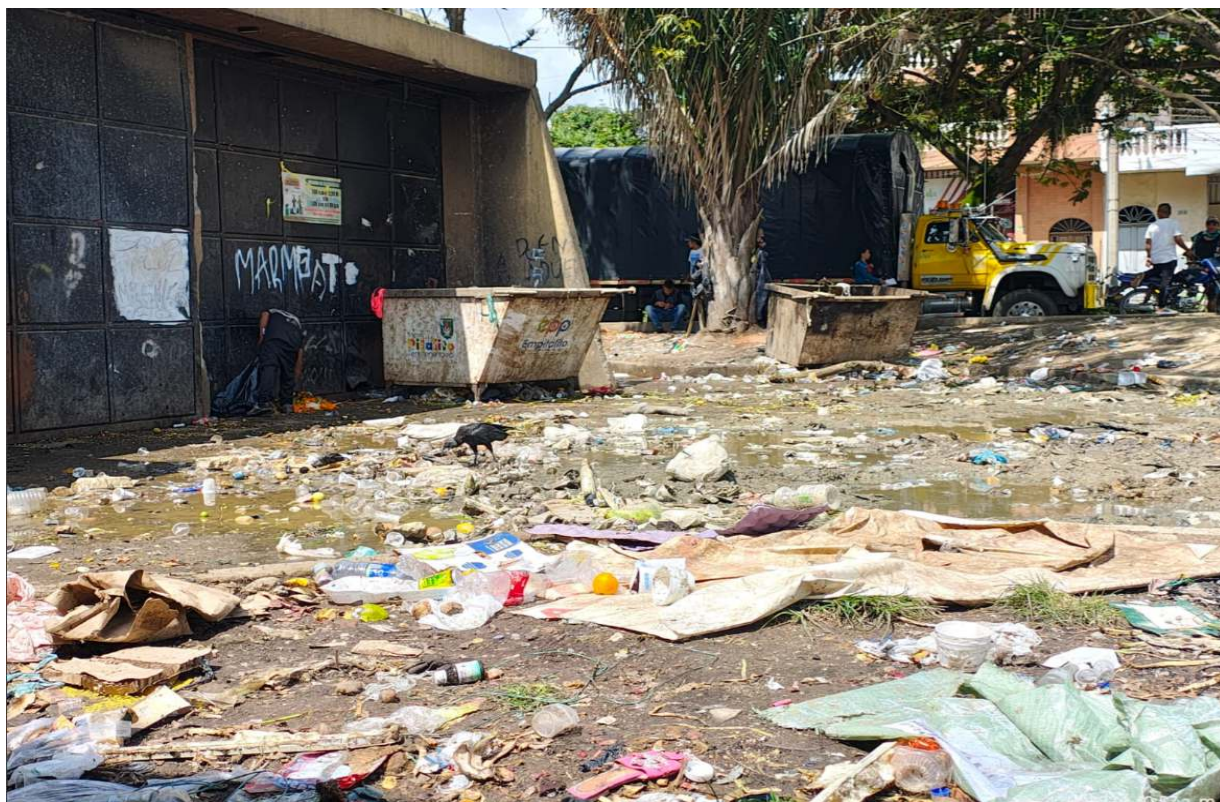
Fotografía 1: Estado Inicial del lugar de la obra. .
