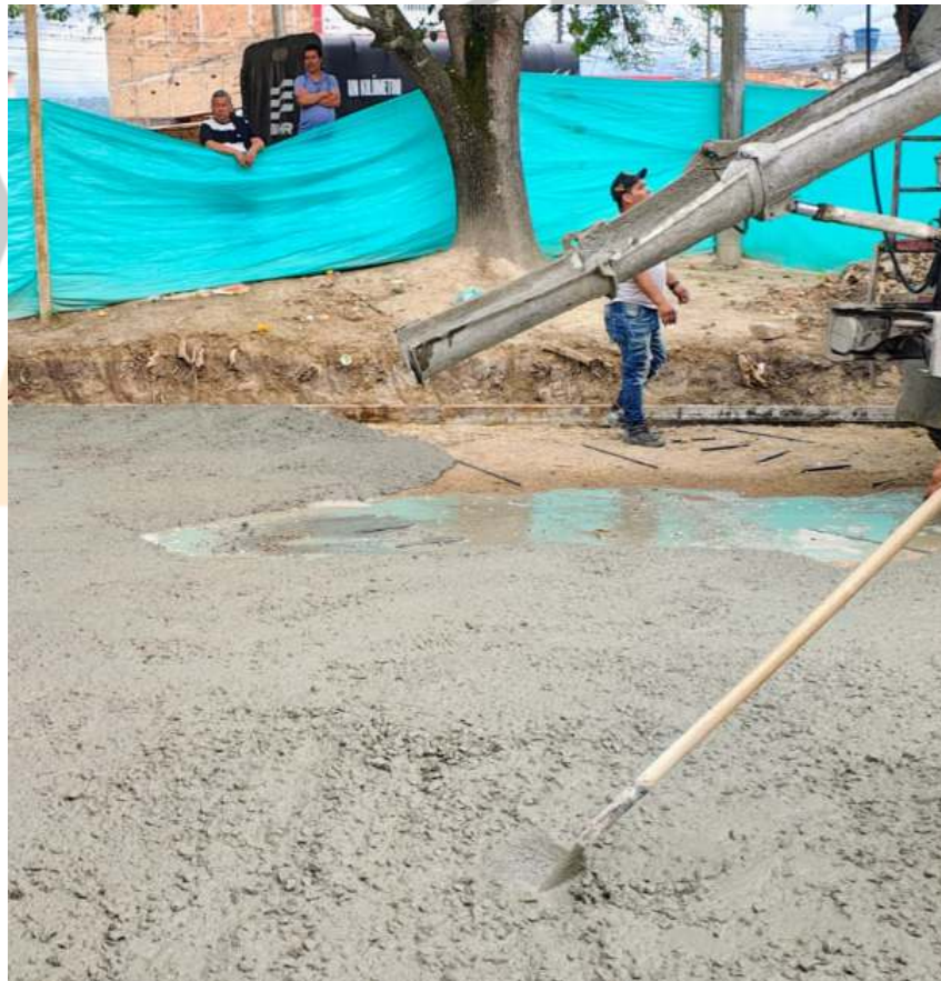
Fotografía 13. Instalación de concreto MR 39
