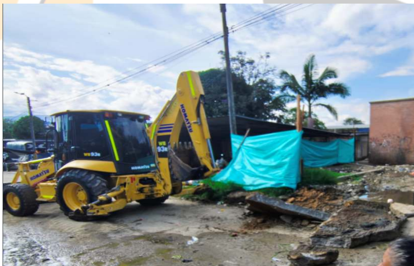
Fotografía 5: Demolición de placa de concreto
