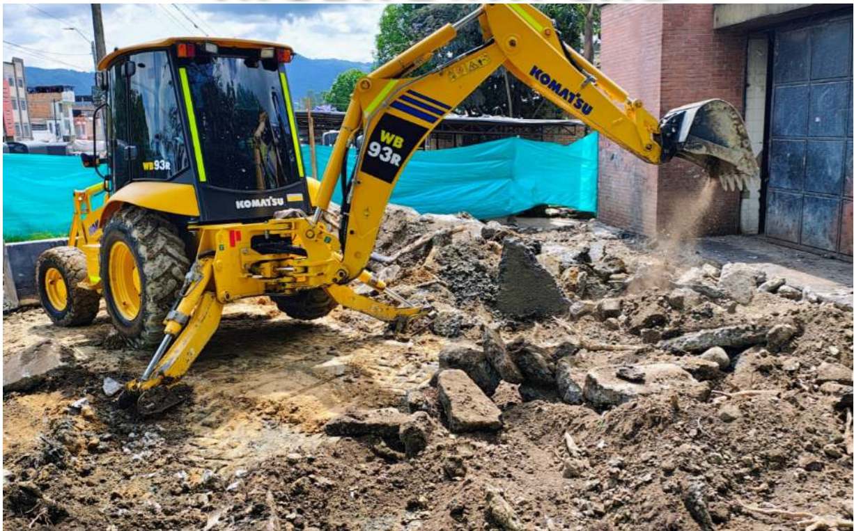
Fotografía 6: Demolición de placa y retiro de escombros.
