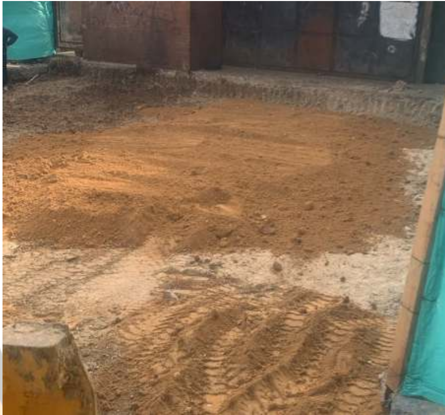
Fotografía 10. Instalación de Material de afirmado
