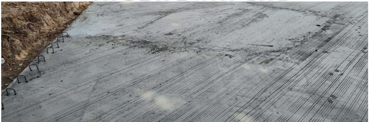
Fotografía 14. Placa de concreto de 18cm de espesor- Acero de refuerzo para Bordillo sobre placa
