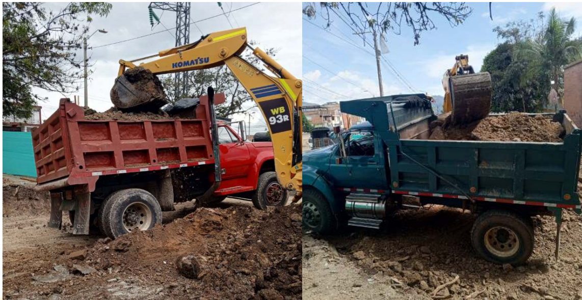
Fotografía 8: Retiro de material proveniente de excavación.
