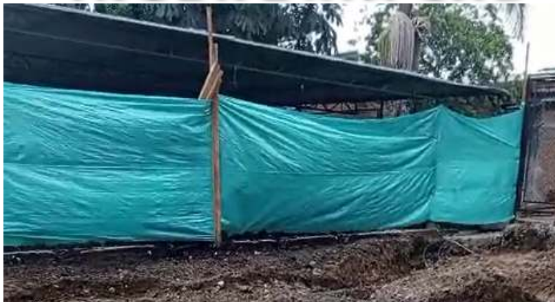
Fotografía 3. Cerramiento en Tela Verde- Costado Zorras.
