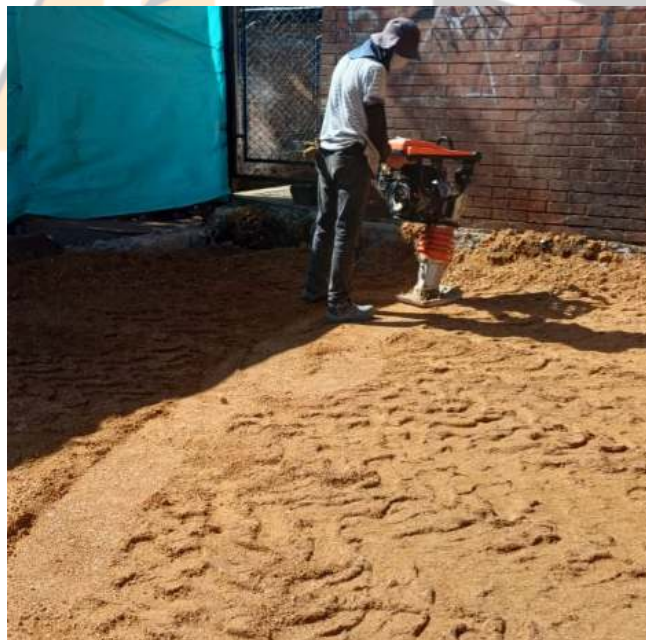
Fotografía 11. Compactación de material de afirmado
