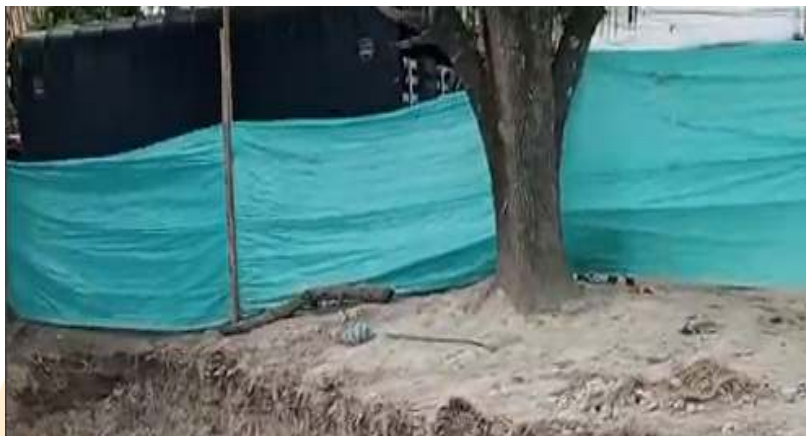
Fotografía 4. Cerramiento en tela verde - costado Avenida circunvalar
