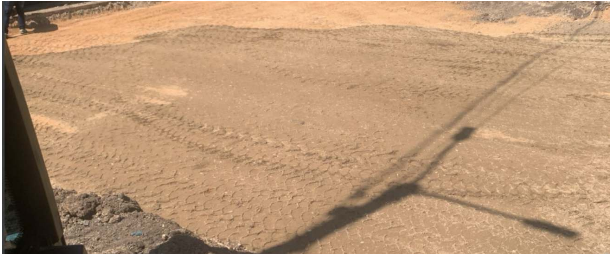
Fotografía 12. Instalación de subbase
