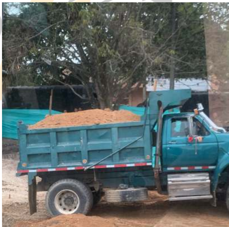
Fotografía 9: Suministro de Material de Afirmado
