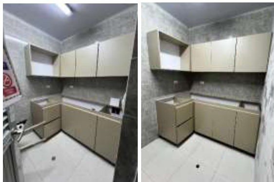
Instalación de cocina integral
