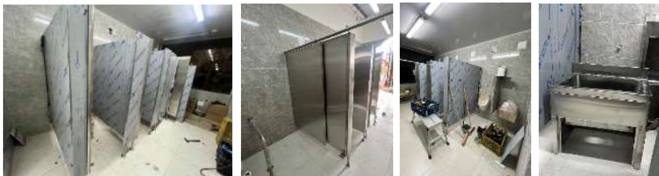
Instalación de divisiones y puertas en acero
