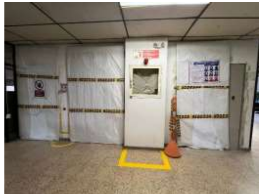
Cerramiento en polisombra 4 piso
