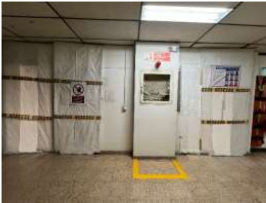
Cerramiento en polisombra 3 piso
