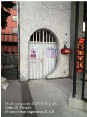
Cerramiento en polisombra baterías sanitarias Mujeres Coliseo
