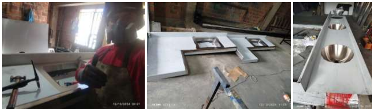
Carpintería metálica (trabajos en taller)
