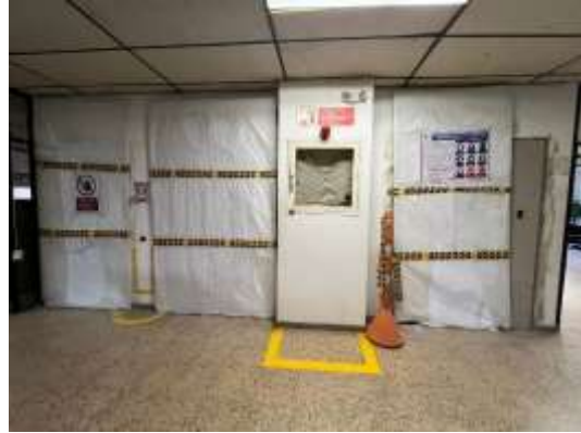
Cerramiento en polisombra 4 piso
