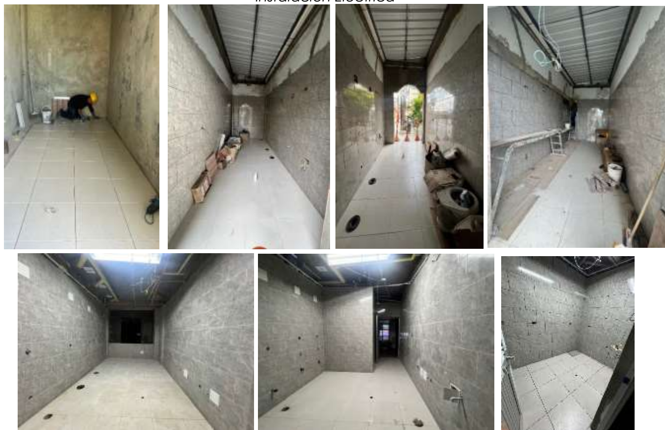
Instalación de cerámica en baterías sanitarias coliseo cubierto
