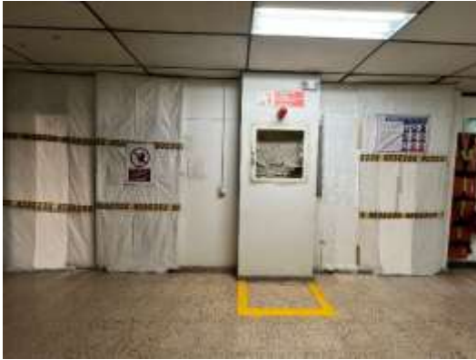
Cerramiento en polisombra 3 piso
