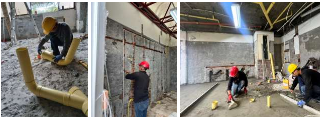
Instalación de puntos hidráulicos y sanitarios
