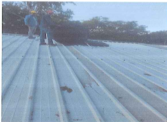
MANTENIMIENTO TANQUES DE ALMACENAMIENTO
