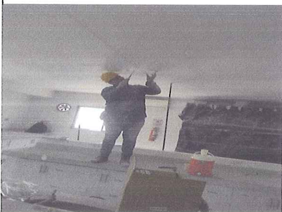
SUMINISTRO E INSTALACIÓN LAMPARAS CIRCULARES LED(LABORATORIO)
