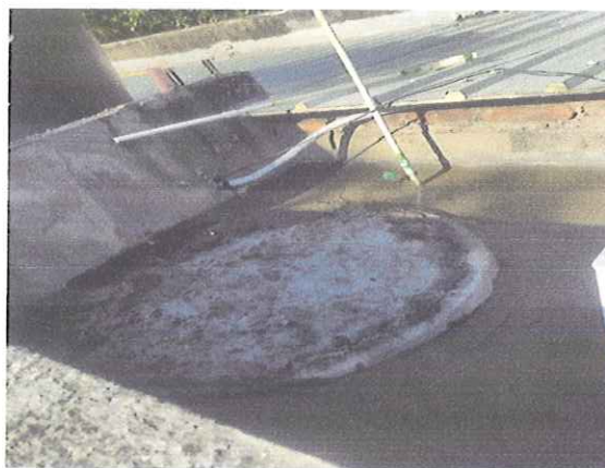
MORTERO DE NIVELACION PLACA BAÑO
