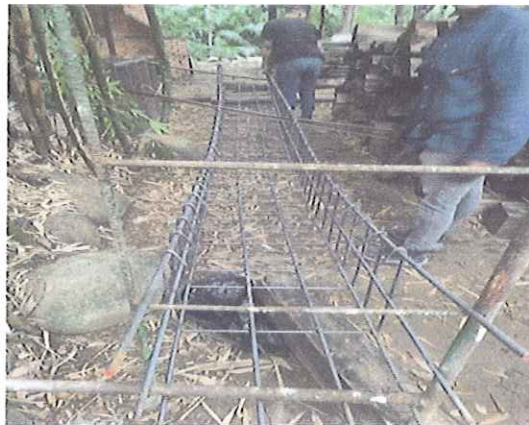
ACERO DE REFUERZO COLUMNAS CARCAMO Y PLACAS PARA PASOS
