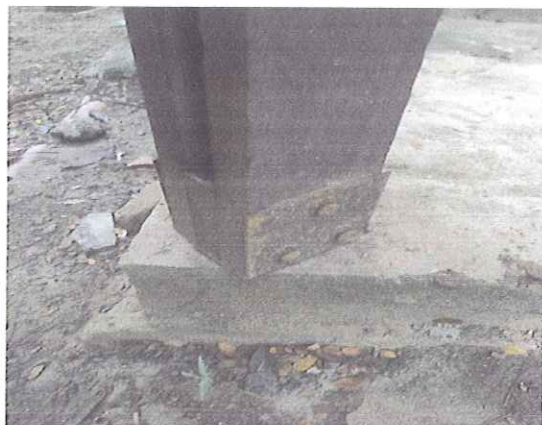
MANTENIMIENTO DE BASE METALICA DE COLUMNAS PASILLO
