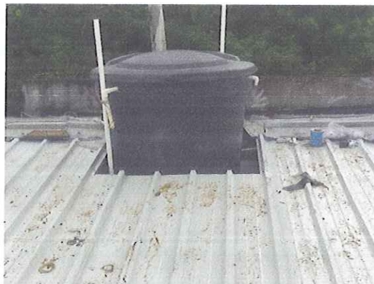
MANTENIMIENTO TANQUES DE ALMACENAMIENTO
