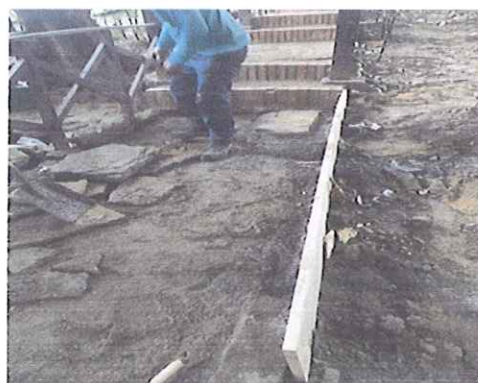
SUMINISTRO E INSTALACION DE PIEDRA LAJA PARA PASILLO
