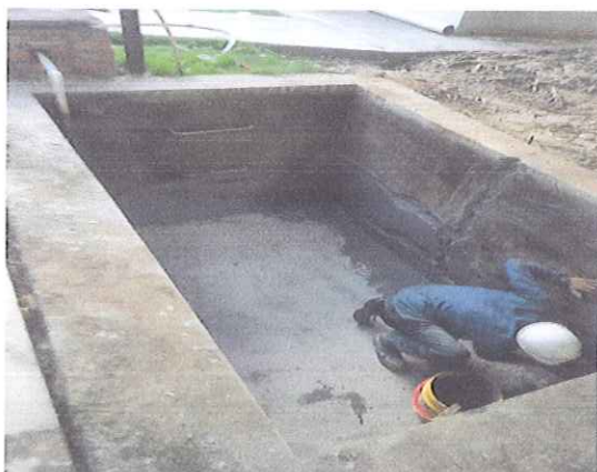
MORTERO DE REPARACIÓN Y PINTURA TANQUE (PAÑETE Y PINTURA)
