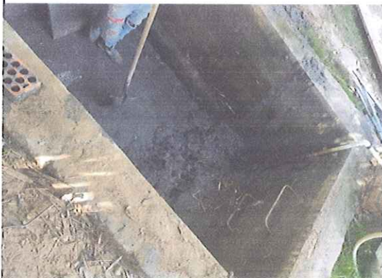
LIMPIEZA DE TANQUE - RETIRO DE SEDIMENTOS Y BASURA
