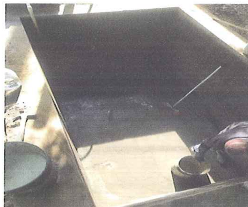
LIMPIEZA DE TANQUE - RETIRO DE SEDIMENTOS Y BASURA
