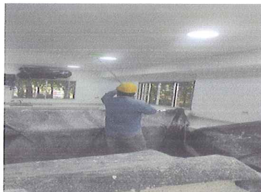
PINTURA EPOXICA LABORATORIO
