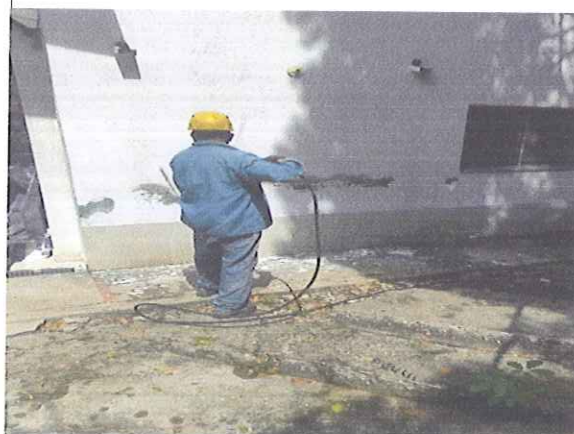
RESANE DE GRANIPLAST MUROS EXTERIORES
