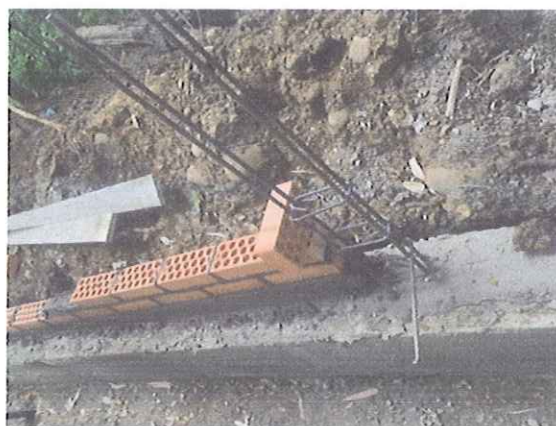
ACERO DE REFUERZO COLUMNAS CARCAMO Y PLACAS PARA PASOS
