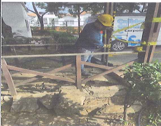
DEMOLICION CON TALADRO PERCUTOR PASILLO EN PIEDRA
