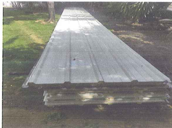
SUMINISTRO TEJA TIPO SANDWICH SOBRE ESTRUCTURA EXISTENTE
