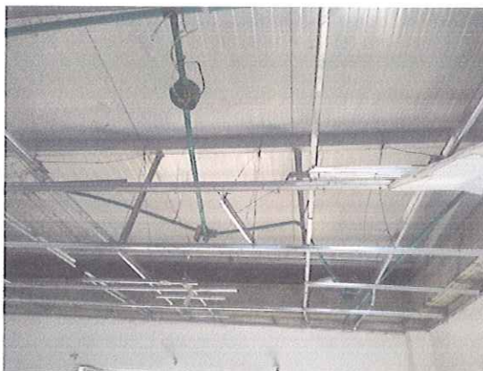
REFUERZO ESTRUCTURA CUBIERTA EXIDSTENTE
