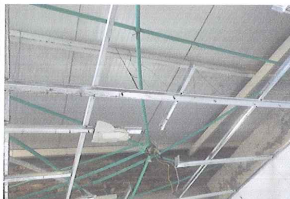
REFUERZO ESTRUCTURA CUBIERTA EXIDSTENTE
