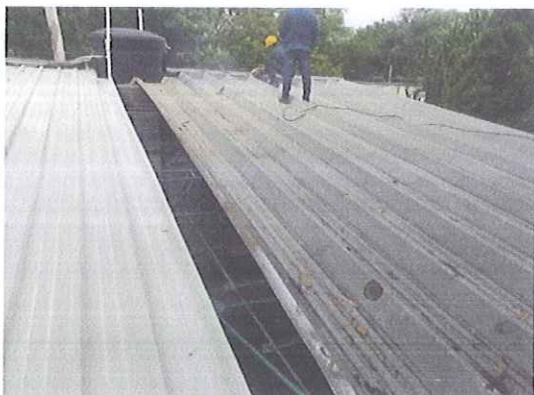
LOCALIZACIÓN Y REPLANTEO
