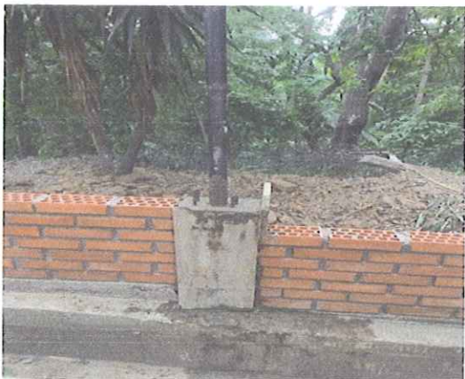
COLUMNAS DE CONFINAMIENTO PARA CERRAMIENTO (0,25*0,12)
