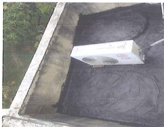
MORTERO DE NIVELACION PLACA BAÑO
