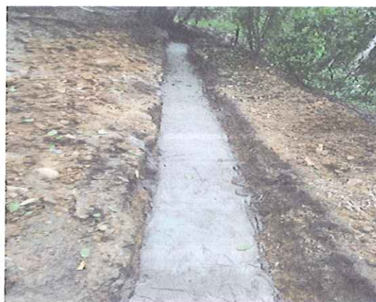
CONCRETO SANEAMIENTO SOLADO
