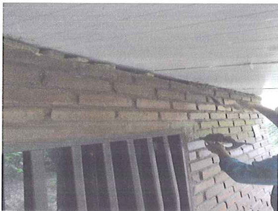
CONFINAMIENTO EN MORTERO Y PINTURA PARA TEJA TIPO SANDWICH
