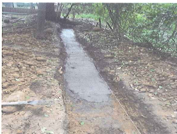
CONCRETO SANEAMIENTO SOLADO
