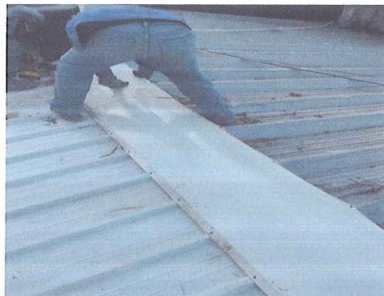
SUMINISTRO E INSTALACION DE CABALLETE
