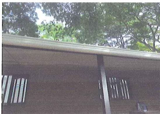
SUMINISTRO E INSTALACIÓN VIGA CANAL PVC CLASICA DE 0.15 MT
