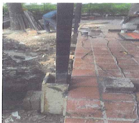
BASES EN CONCRETOCOLUMNAS METALICAS (,25*,25)
