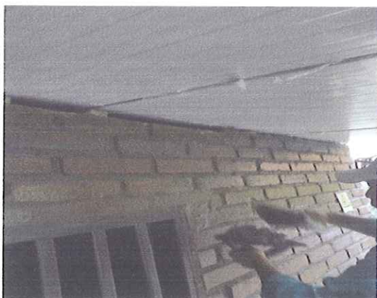
CONFINAMIENTO EN MORTERO Y PINTURA PARA TEJA TIPO SANDWICH
