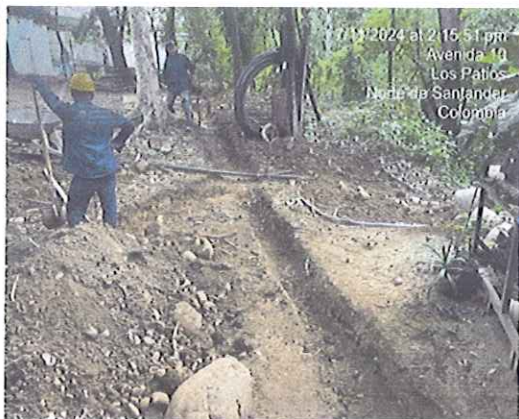
EXCAVACIÓN MANUAL SIN CLASIFICAR(CERRAMIENTO)
