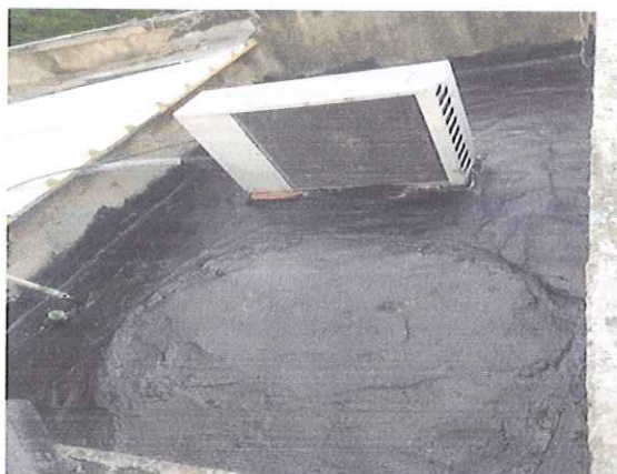
MORTERO DE NIVELACION PLACA BAÑO
