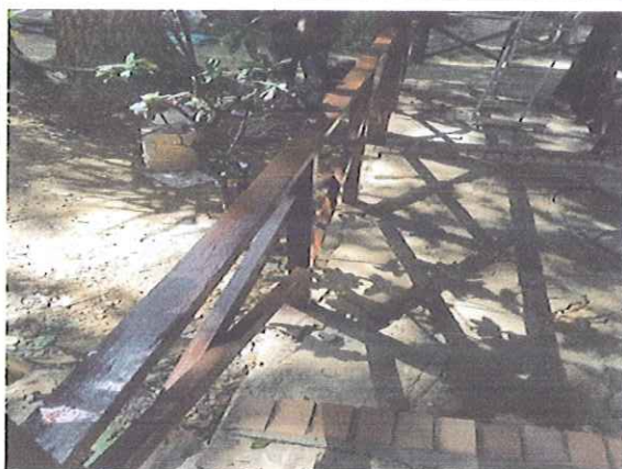
MANTENIMIENTO DE BARANDA EN MADERA
