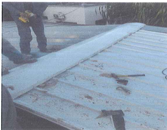
SUMINISTRO E INSTALACION DE CABALLETE
