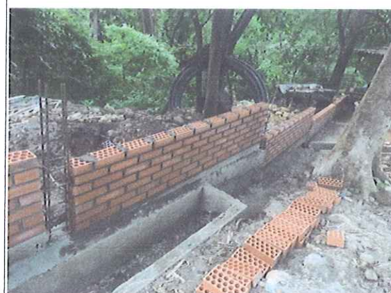
MURO EN LADRILLO LIMPIO
