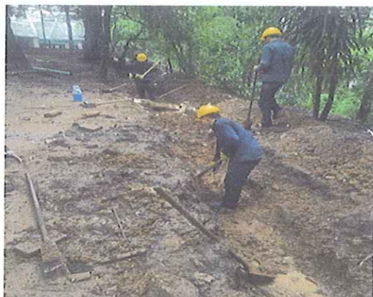
EXCAVACIÓN MANUAL SIN CLASIFICAR(CERRAMIENTO)
