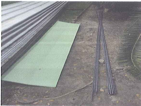
SUMINISTRO E INSTALACION DE CABALLETE
