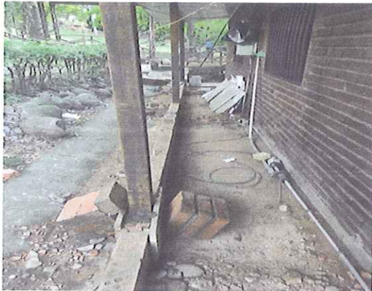
COLUMNAS METALICAS 14X14
