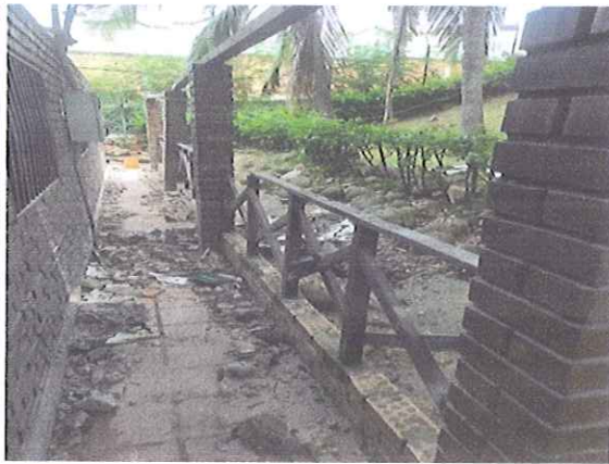
DEMOLICIÓN DE COLUMNAS EN LADRILLO(CAMBIO CLIMATICO)
