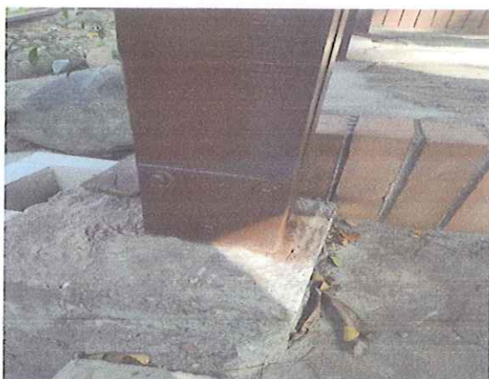
MANTENIMIENTO DE BASE METALICA DE COLUMNAS PASILLO
