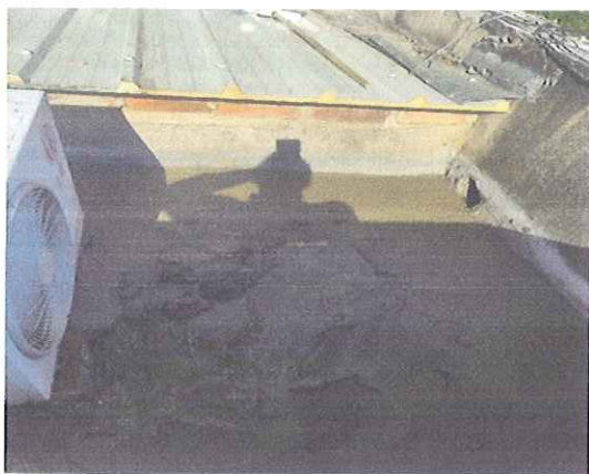
MORTERO DE NIVELACION PLACA BAÑO
