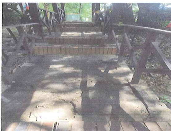
SUMINISTRO E INSTALACION DE PIEDRA LAJA PARA PASILLO
