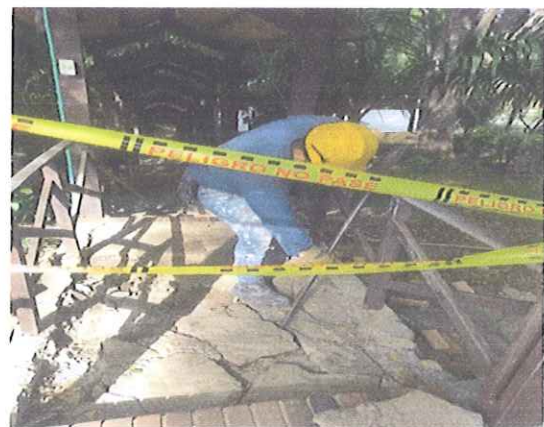
DEMOLICION CON TALADRO PERCUTOR PASILLO EN PIEDRA
