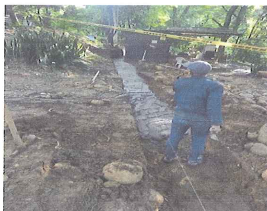
CONCRETO SANEAMIENTO SOLADO
