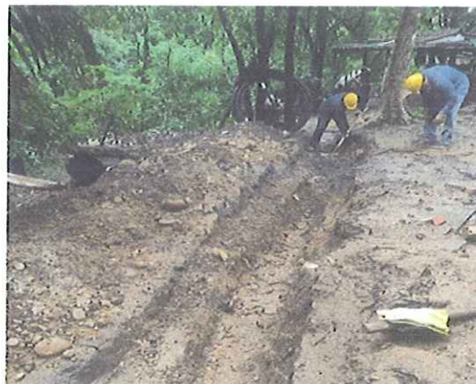
EXCAVACIÓN MANUAL SIN CLASIFICAR(CERRAMIENTO)
