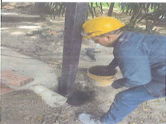
BASES EN CONCRETOCOLUMNAS METALICAS (,25*,25)
