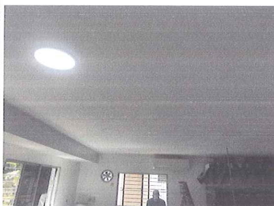
SUMINISTRO E INSTALACIÓN LAMPARAS CIRCULARES LED(LABORATORIO)
