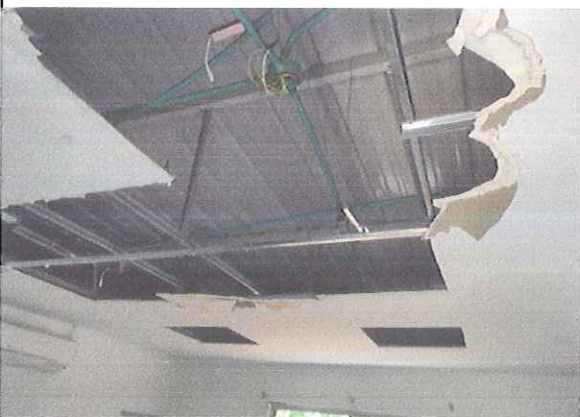
DESMONTE DE CIELORASO EN DRYWALL
