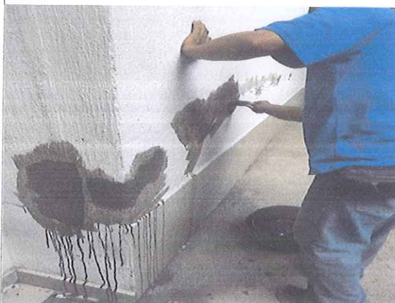
RESANE DE GRANIPLAST MUROS EXTERIORES
