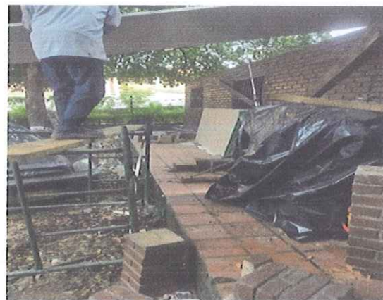
DEMOLICIÓN DE COLUMNAS EN LADRILLO(CAMBIO CLIMATICO)
