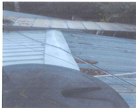
SUMINISTRO E INSTALACION DE CABALLETE
