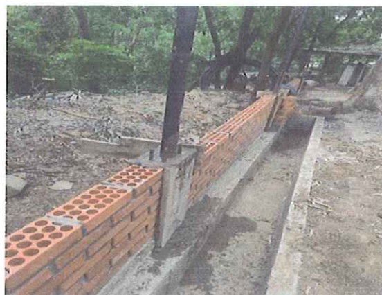
COLUMNAS DE CONFINAMIENTO PARA CERRAMIENTO (0,25*0,12)
