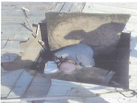
MANTENIMIENTO TANQUES DE ALMACENAMIENTO
