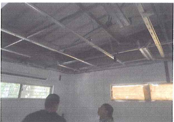
DESMONTE DE CIELORASO EN DRYWALL
