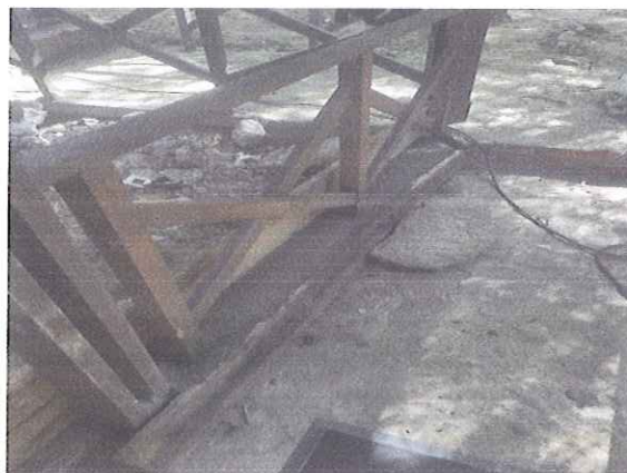
MANTENIMIENTO DE BARANDA EN MADERA
