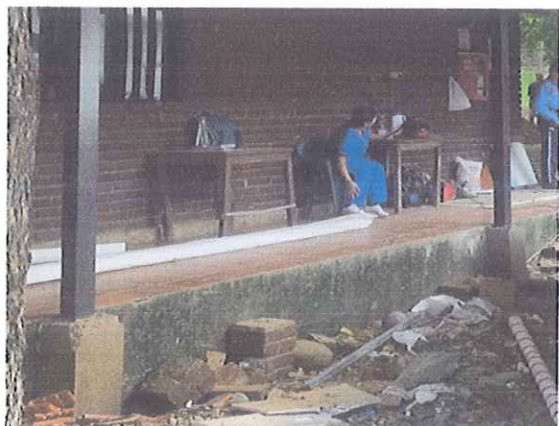
BASES EN CONCRETOCOLUMNAS METALICAS (,25*,25)
