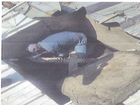
MANTENIMIENTO TANQUES DE ALMACENAMIENTO
