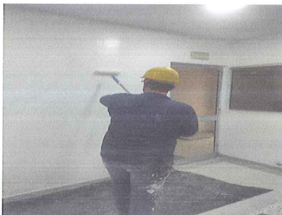
PINTURA EPOXICA LABORATORIO
