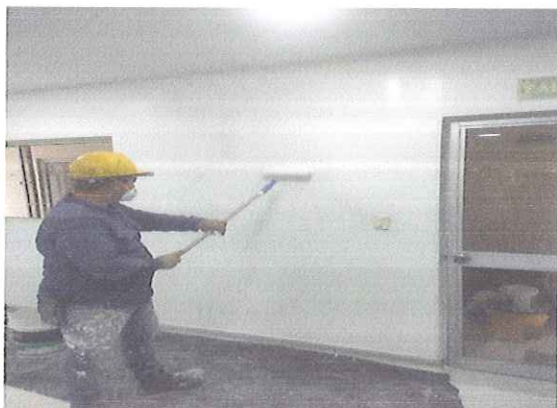
PINTURA EPOXICA LABORATORIO
