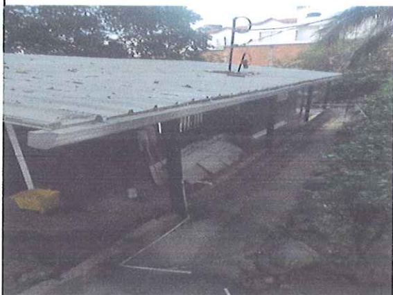
SUMINISTRO E INSTALACIÓN VIGA CANAL PVC CLASICA DE 0.15 MT
