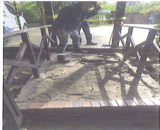
DEMOLICION CON TALADRO PERCUTOR PASILLO EN PIEDRA
