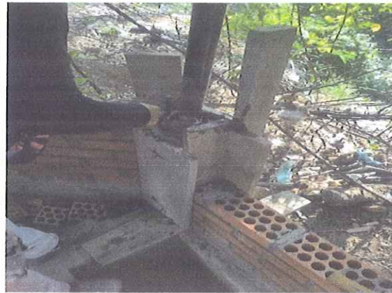
COLUMNAS DE CONFINAMIENTO PARA CERRAMIENTO (0,25*0,12)
