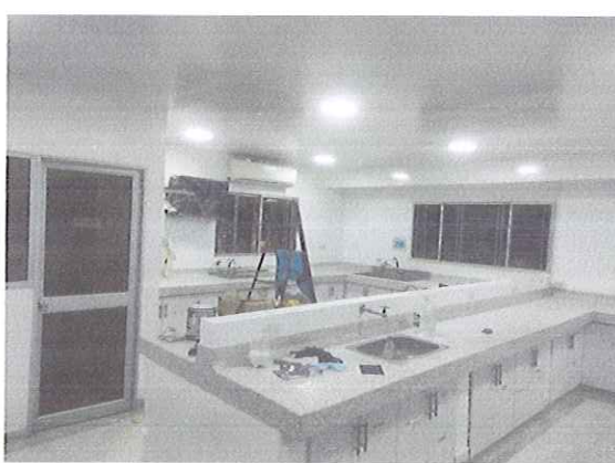
SUMINISTRO E INSTALACIÓN LAMPARAS CIRCULARES LED(LABORATORIO)
