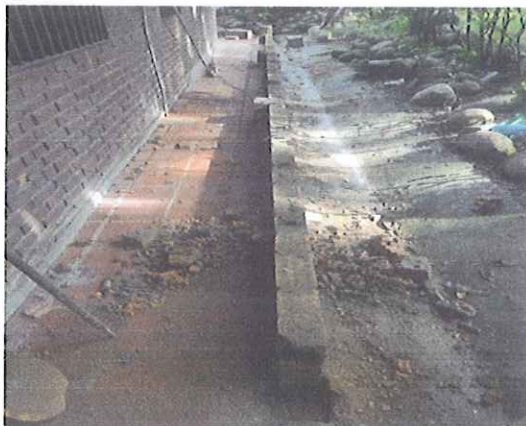
DEMOLICIÓN DE COLUMNAS EN LADRILLO(CAMBIO CLIMATICO)
