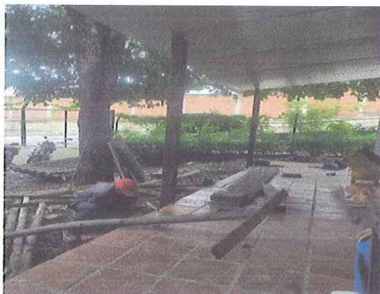
COLUMNAS METALICAS 14X14
