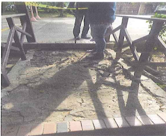
DEMOLICION CON TALADRO PERCUTOR PASILLO EN PIEDRA
