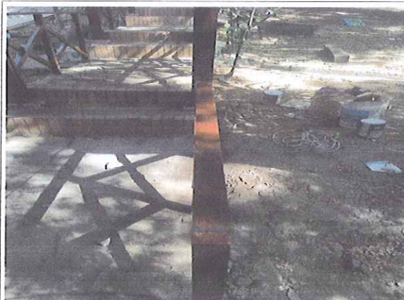
MANTENIMIENTO DE BARANDA EN MADERA
