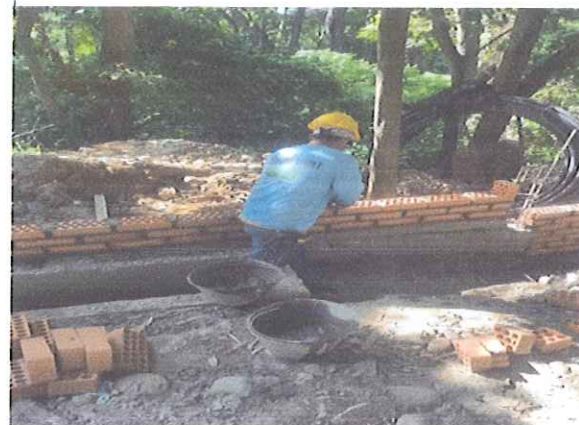
MURO EN LADRILLO LIMPIO
