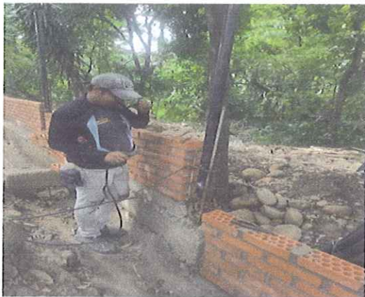
COLUMNAS DE CONFINAMIENTO PARA CERRAMIENTO (0,25*0,12)
