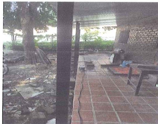
COLUMNAS METALICAS 14X14
