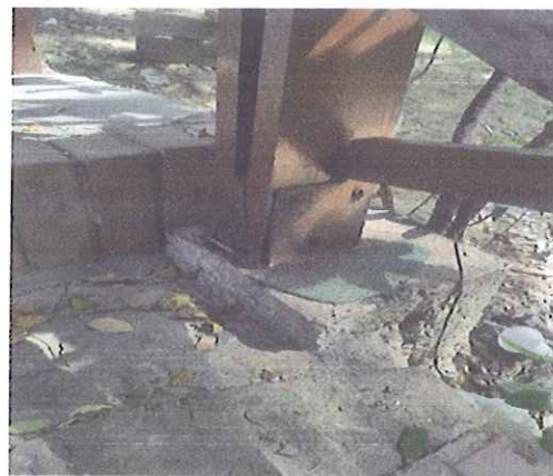
MANTENIMIENTO DE BASE METALICA DE COLUMNAS PASILLO
