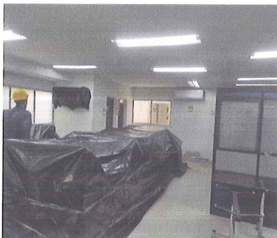
LOCALIZACIÓN Y REPLANTEO
