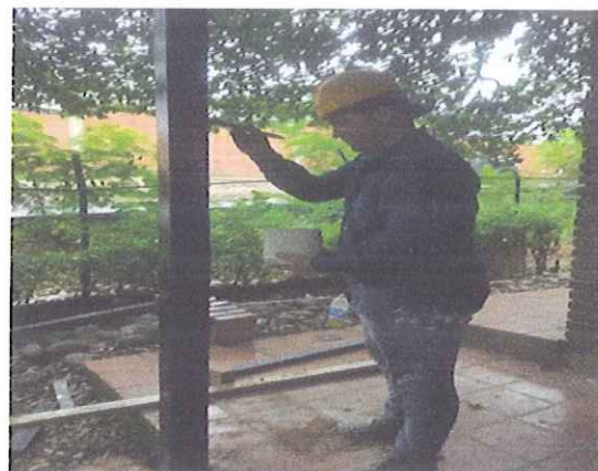
COLUMNAS METALICAS 14X14
