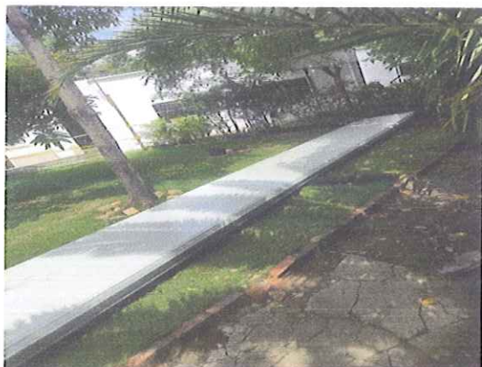
SUMINISTRO TEJA TIPO SANDWICH SOBRE ESTRUCTURA EXISTENTE
