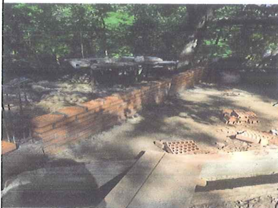
MURO EN LADRILLO LIMPIO
