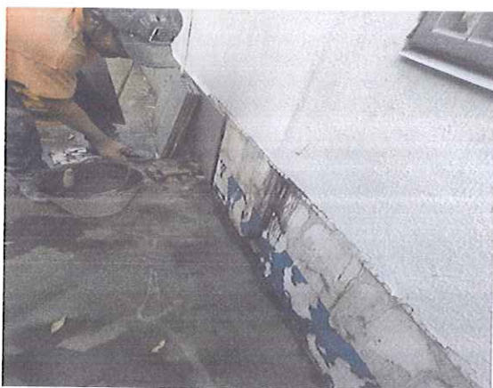
RESANE DE GRANIPLAST MUROS EXTERIORES
