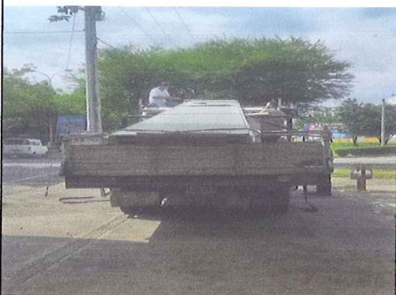
SUMINISTRO TEJA TIPO SANDWICH SOBRE ESTRUCTURA EXISTENTE
