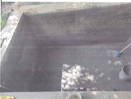
MORTERO DE REPARACIÓN Y PINTURA TANQUE (PAÑETE Y PINTURA)
