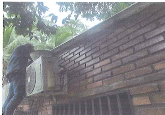
CONFINAMIENTO EN MORTERO Y PINTURA PARA TEJA TIPO SANDWICH
