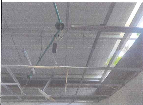
REFUERZO ESTRUCTURA CUBIERTA EXIDSTENTE
