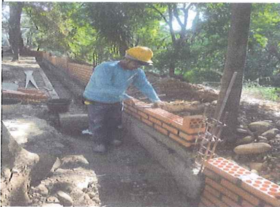
MURO EN LADRILLO LIMPIO
