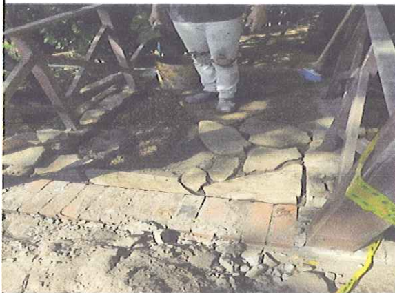
SUMINISTRO E INSTALACION DE PIEDRA LAJA PARA PASILLO
