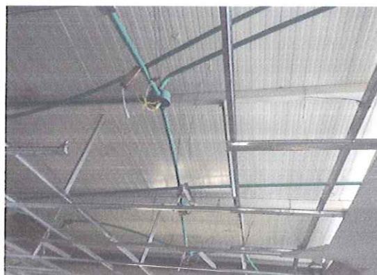
REFUERZO ESTRUCTURA CUBIERTA EXIDSTENTE
