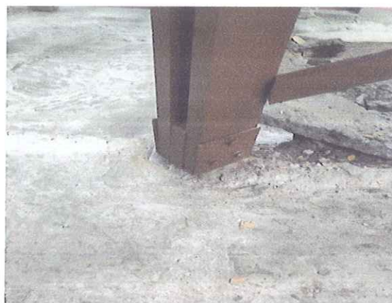
MANTENIMIENTO DE BASE METALICA DE COLUMNAS PASILLO
