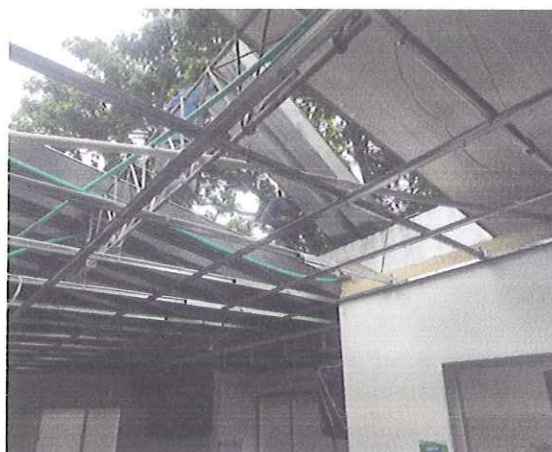
LOCALIZACIÓN Y REPLANTEO
