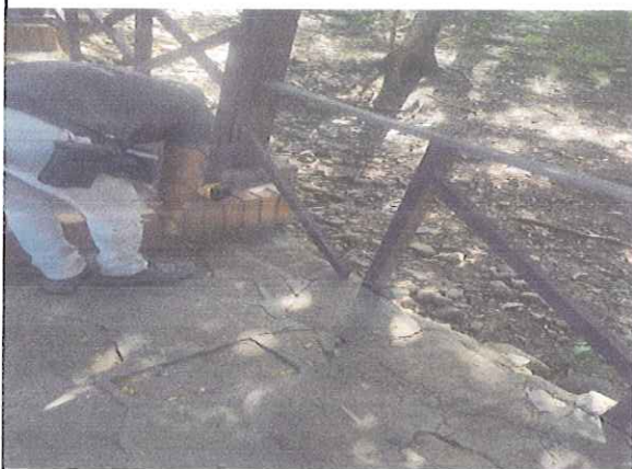
MANTENIMIENTO DE BARANDA EN MADERA
