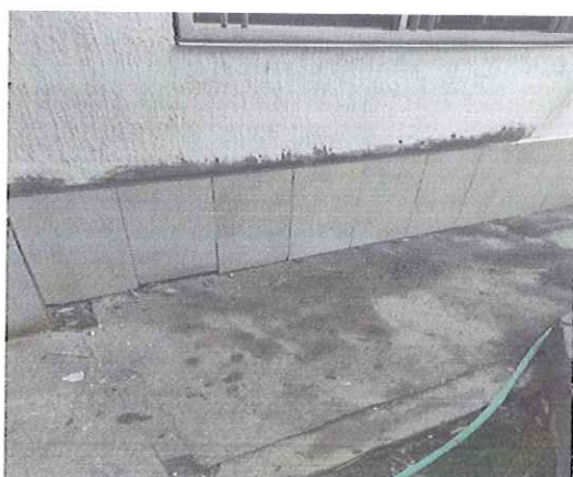
RESANE DE GRANIPLAST MUROS EXTERIORES
