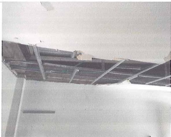
DESMONTE DE CIELORASO EN DRYWALL
