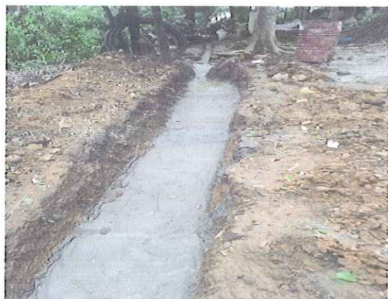
CONCRETO SANEAMIENTO SOLADO
