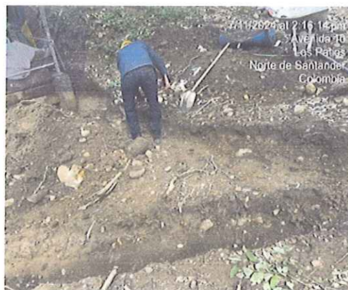
EXCAVACIÓN MANUAL SIN CLASIFICAR(CERRAMIENTO)
