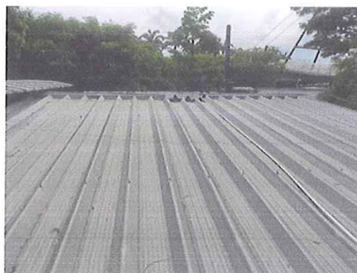
LOCALIZACIÓN Y REPLANTEO
