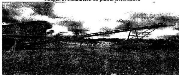
Imagen 3. Instalación de planta trituradora
