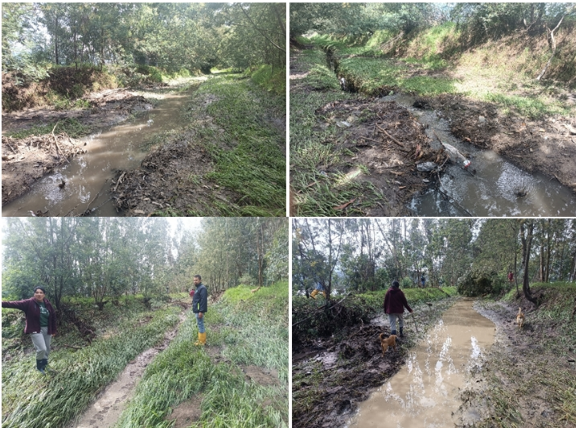
Fotografías 3, 4, 5 y 6. Estado actual de la quebrada Pueblo Viejo aguas arriba del puente vehicular.
