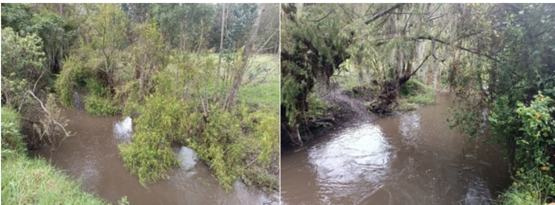
Fotografías 5 y 6. Estado del cauce aguas abajo del puente vehicular. Fuente: Propia
