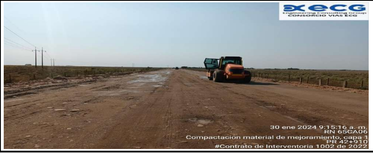
Compactación material de mejoramiento capa 1
