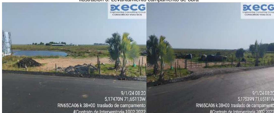
Ilustración 6. Levantamiento campamento de obra
