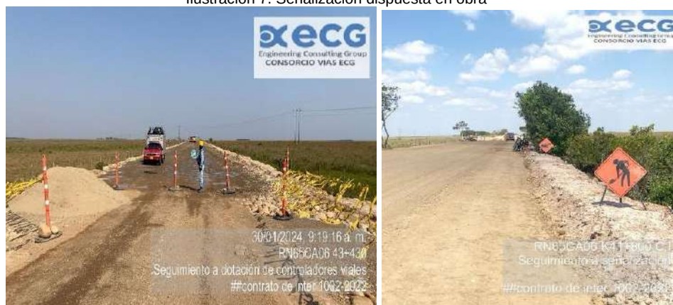
Ilustración 7. Señalización dispuesta en obra
