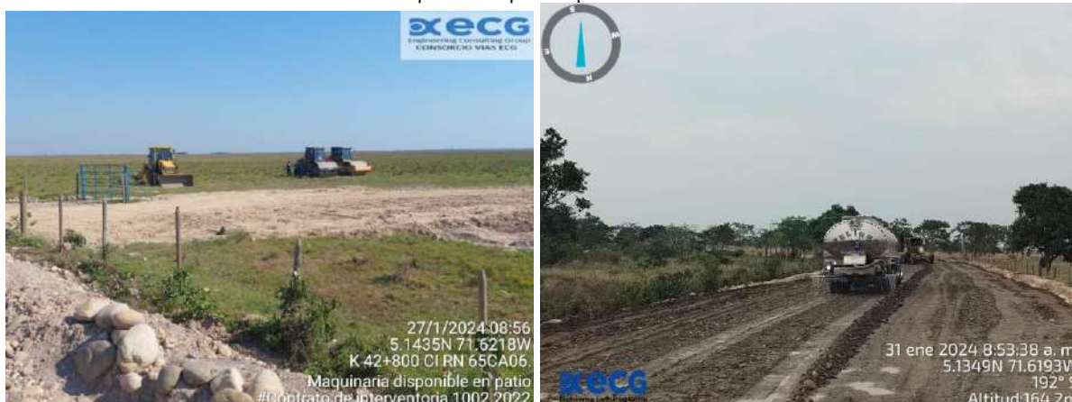
Ilustración 8. Maquinaria disponible para las actividades de obra
