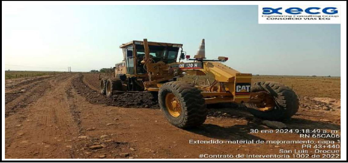
Extendido de material de mejoramiento
