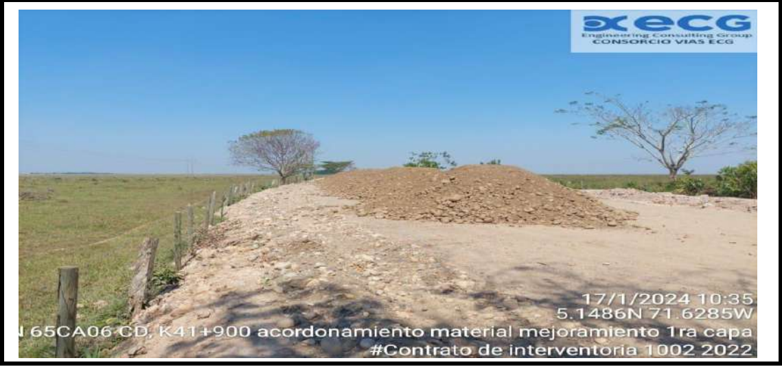
Instalación carpeta asfáltica k39+070
