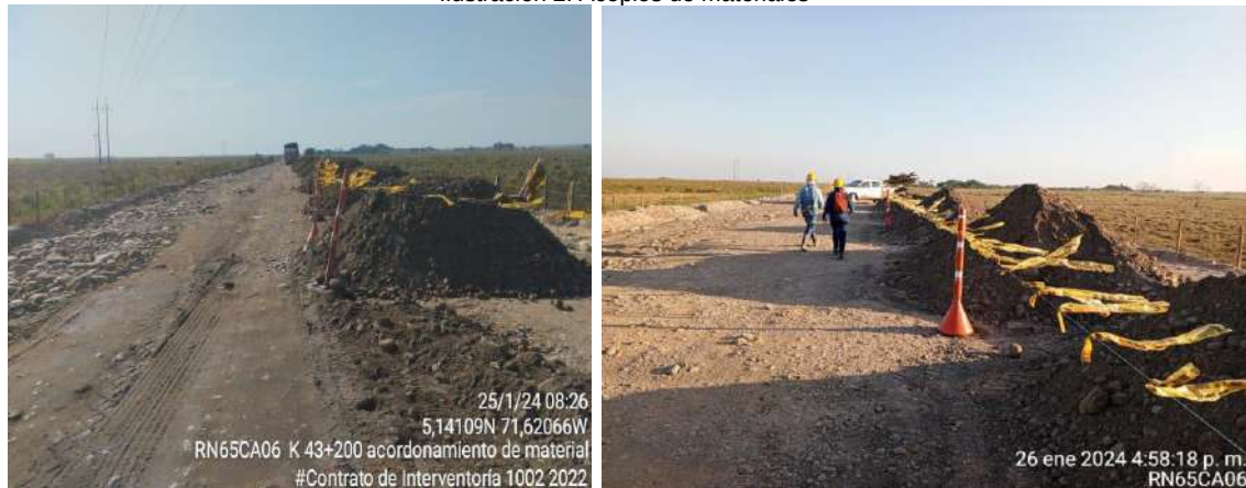
Ilustración 2. Acopios de materiales
