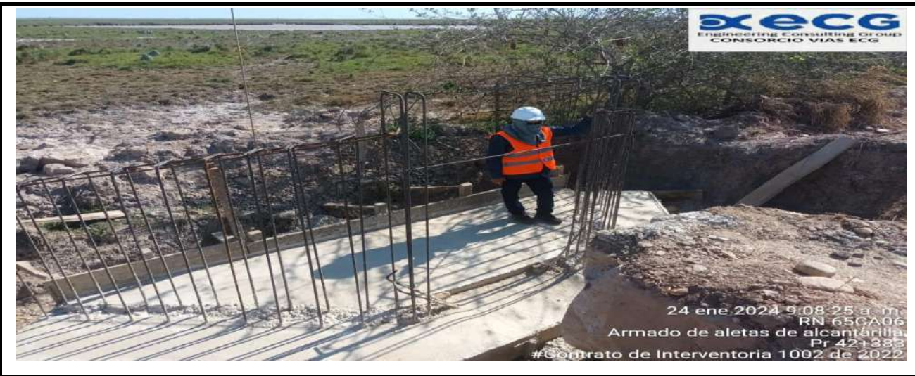
acero de refuerzo aletas
