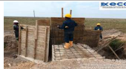
PR 38+500 SEGUIMIENTO MENSUAL DE AVANCE DE OBRA
