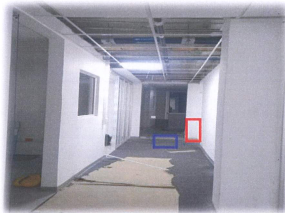
Ilustración 1- Entrada a la obra
