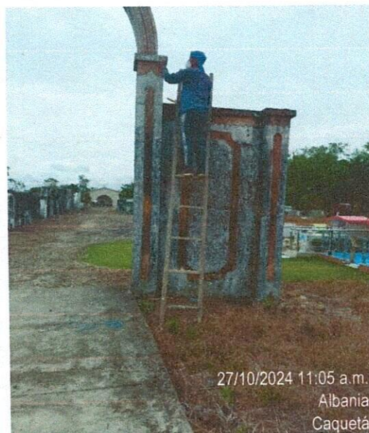
Limpieza de muros existentes y resane de dilataciones
