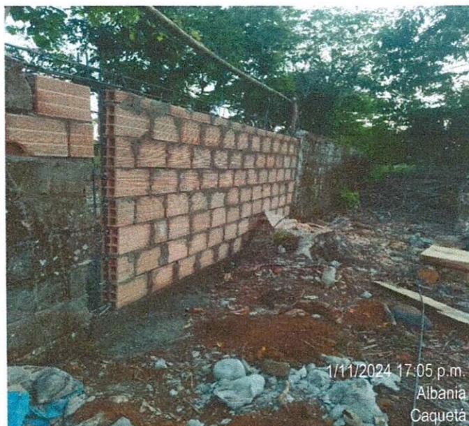
Mampostería en ladrillo de arcilla H5, incluye zapatas, columnas, viga cimentación y viga aérea
