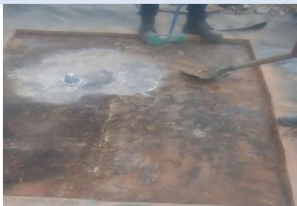
NP95 INSTALACION E IMPERMEABILIZACION DE MANTO ASFALTICO ROLLO 10X1
