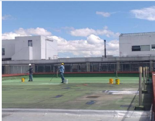
NP95 INSTALACION E IMPERMEABILIZACION DE MANTO ASFALTICO ROLLO 10X1
