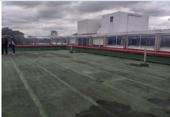
NP95 INSTALACION E IMPERMEABILIZACION DE MANTO ASFALTICO ROLLO 10X1
