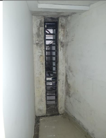
Resanes muros, carceletas
