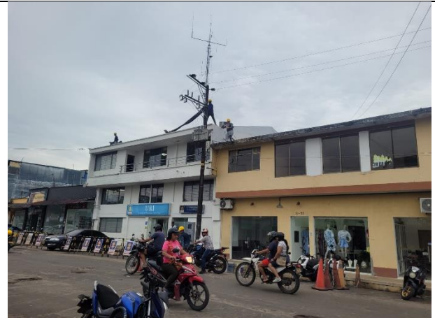
Imperbeablización de culatas
