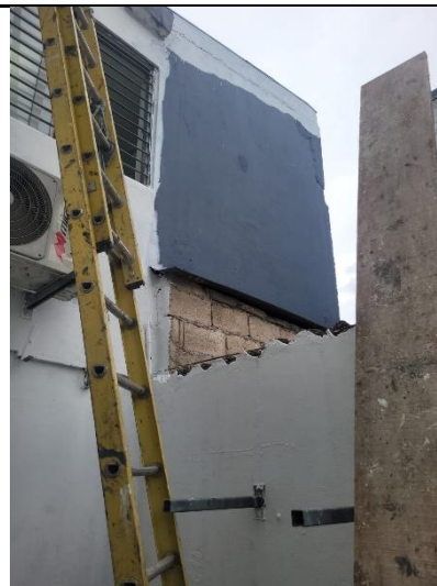
Impermeabilizacion muros internos culatas
