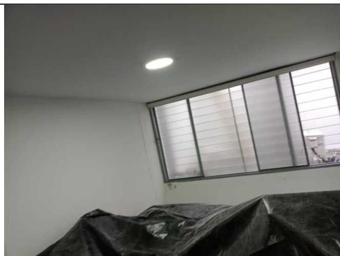
Pintura muros y cielo raso
