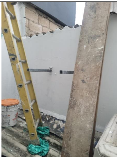
Impermeabilizacion muros internos culatas
