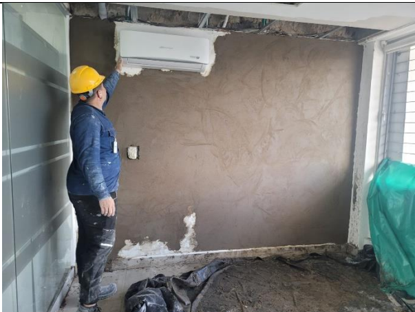
Pañete impermeabilizado Urpa Piso 3
