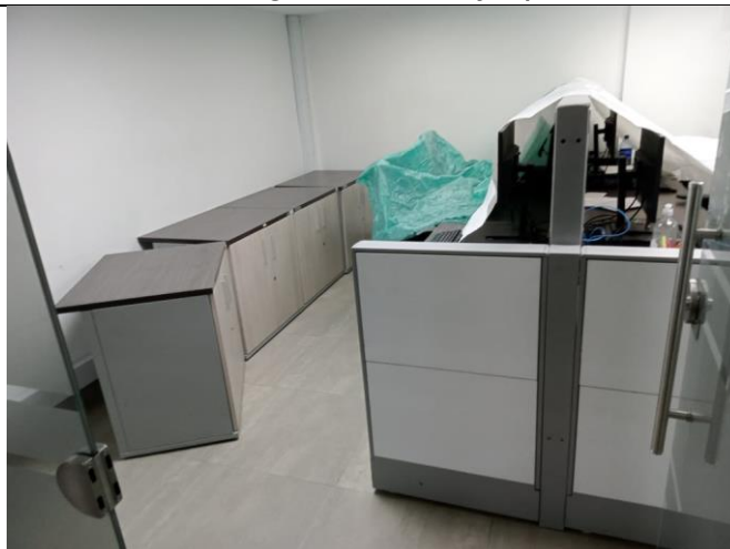
Fiscalia segundo Piso CTI pinturas
