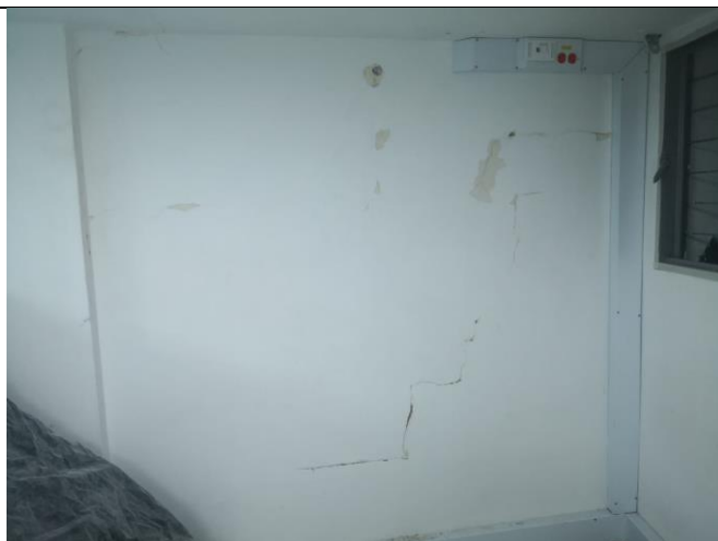
Resane muros humedades
