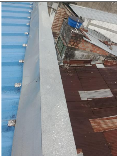
Mantenimiento de cubierta
