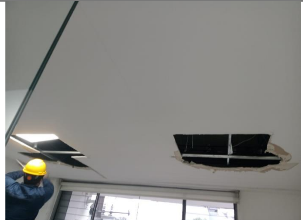
Desmonte de cielo raso
