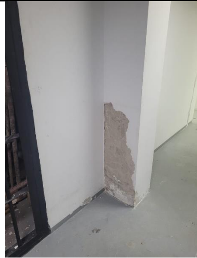
Resanes muros, carceletas
