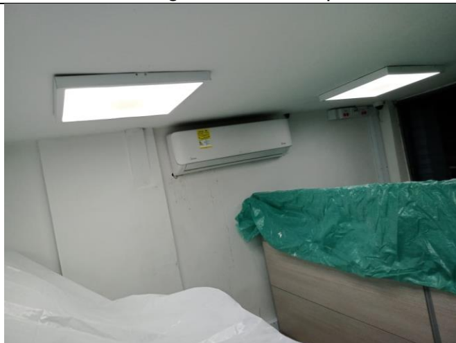
Fiscalia segundo Piso CTI pinturas
