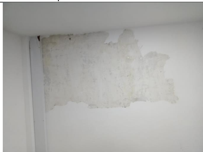
Resane muros humedades
