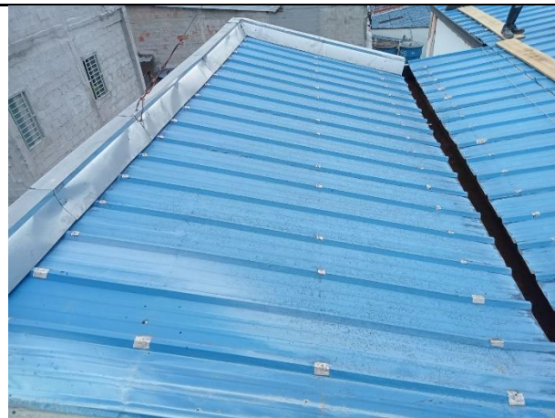
Mantenimiento de cubierta
