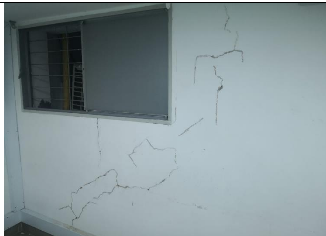
Resane grietas muros
