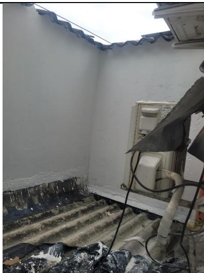
Impermeabilizacion muros internos culatas
