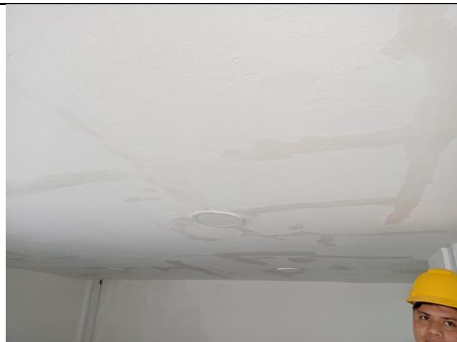
Pintura y resanes bajo placa
