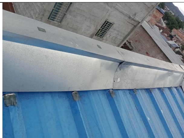
Mantenimiento de cubierta
