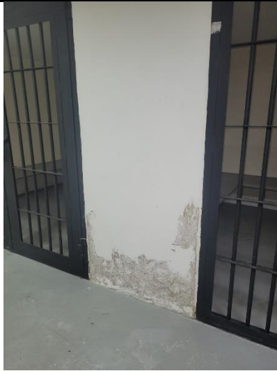
Resanes muros, carceletas
