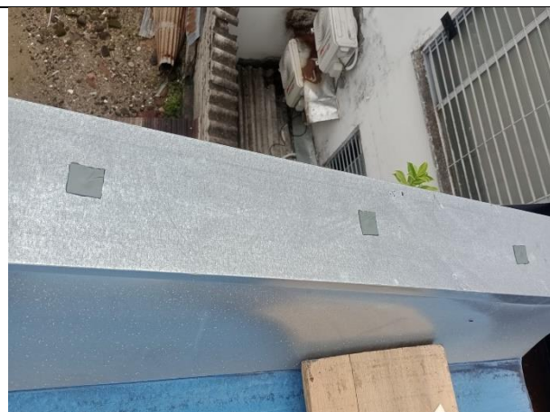
Mantenimiento de cubierta
