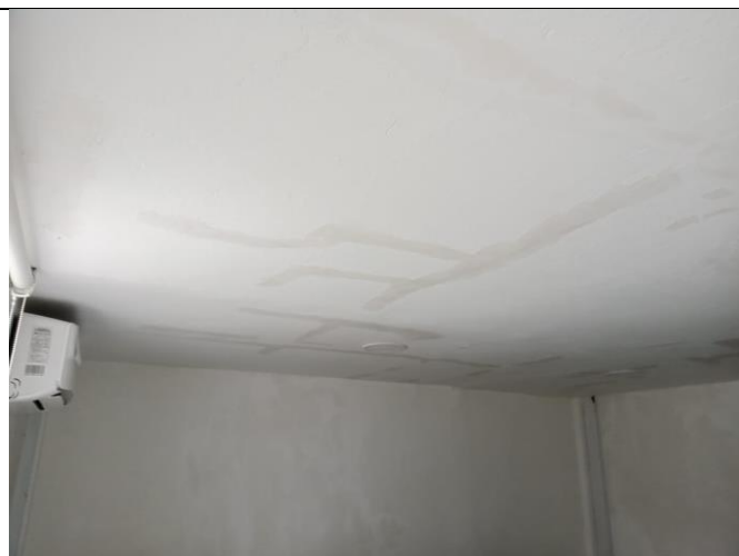
Reparaciones de cielo raso
