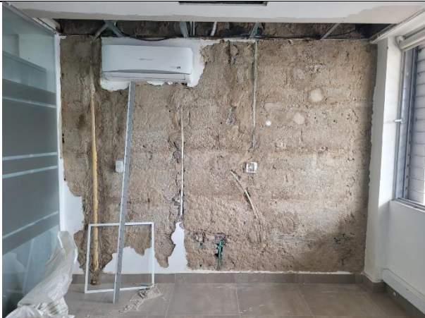
Demolición de pañetes
