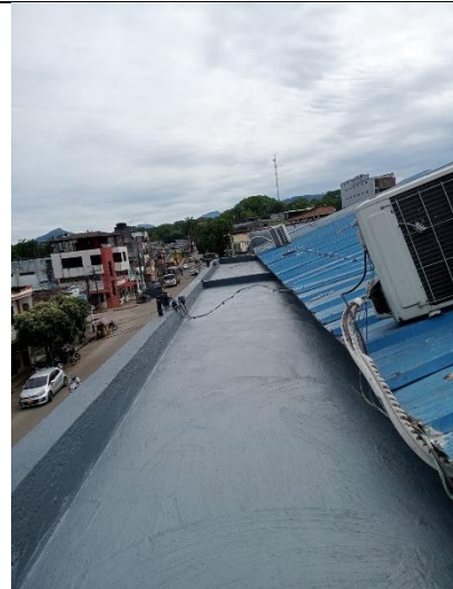
Impermeabilizacion de canales
