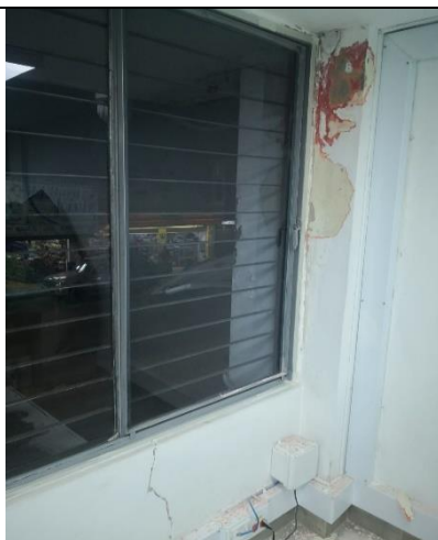
Resane muros humedades
