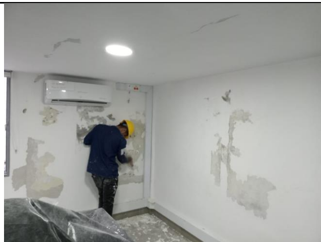
Resane sala descanso Piso 2
