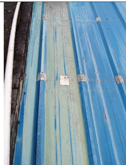
Mantenimiento de cubierta
