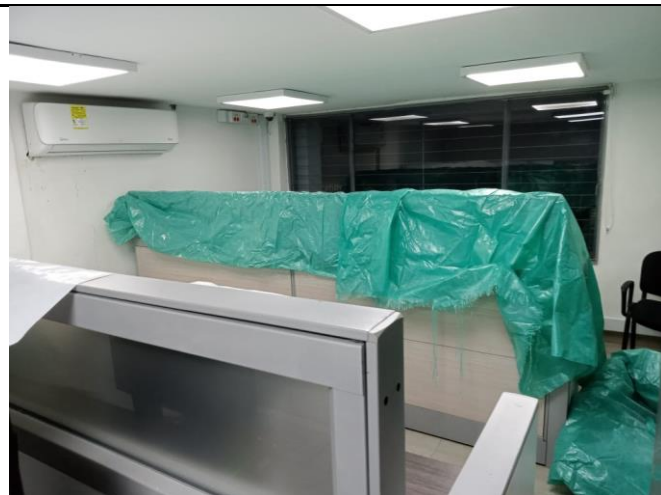
Fiscalia segundo Piso CTI pinturas
