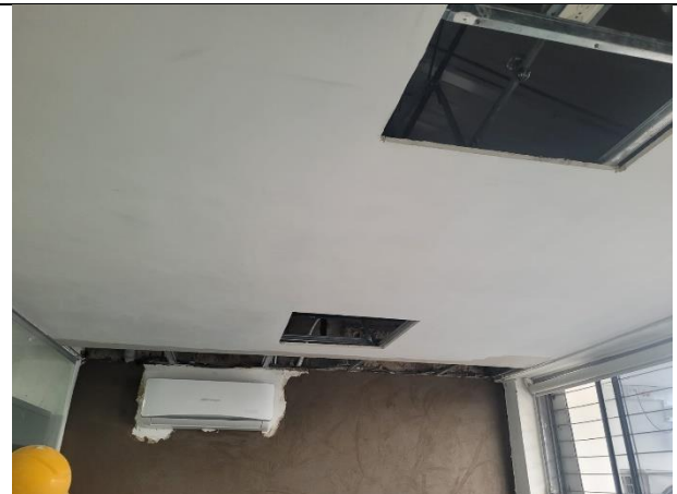
Instalacion de cielo raso fiscal Urpa
