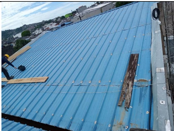
Mantenimiento de cubierta
