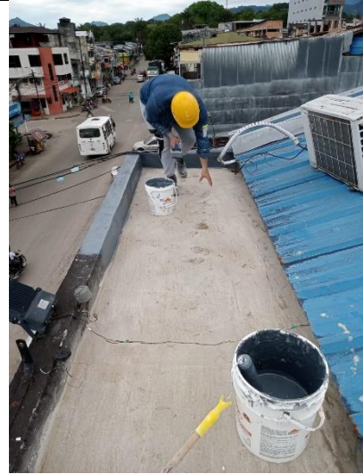
Alistado piso viga canal
