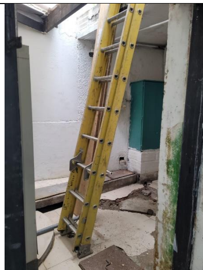
Mantenimiento de fachadas internas
