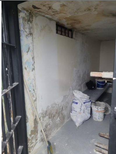
Resanes muros, carceletas
