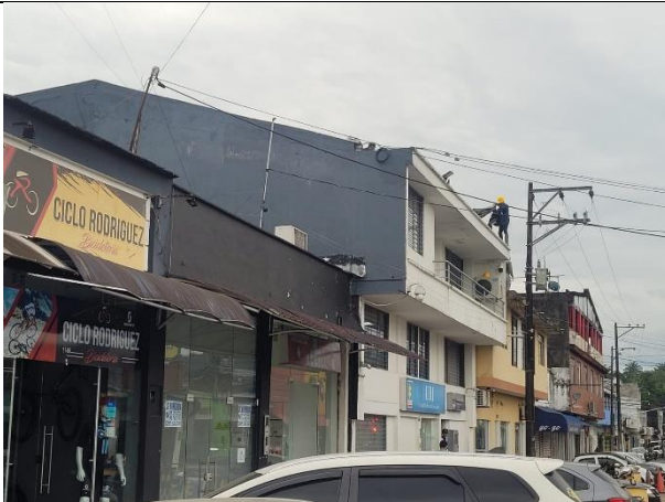
Imperbeablización de culatas
