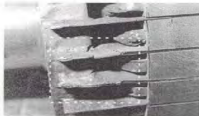
Barras rotas en la proximidad del anillo
