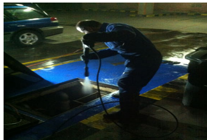
Limpieza de pozo eyector de aguas lluvias.
