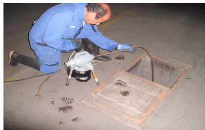
Sondeo de tuberías de aguas lluvias.
