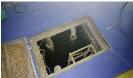
Vaciado de pozo eyector de aguas lluvias.
