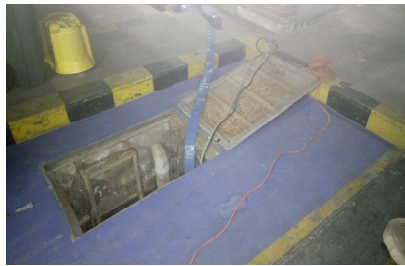
Vaciado de pozo eyector de aguas lluvias.
