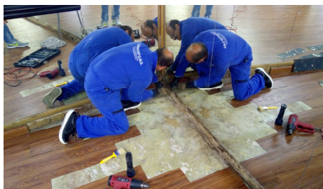
Reparación de fugas en sótanos.
