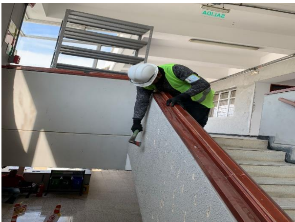
PICA Y RASPE TEXTURIZADO ESCALERAS CENTRALES
