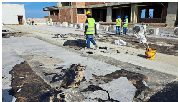
DESMONTE DE MANTO EDIL
