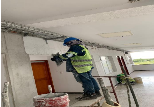
APLICACIÓN DE GRANIPLAST
