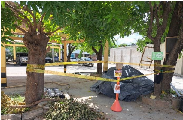
ACOPIO DE MATERIALES
