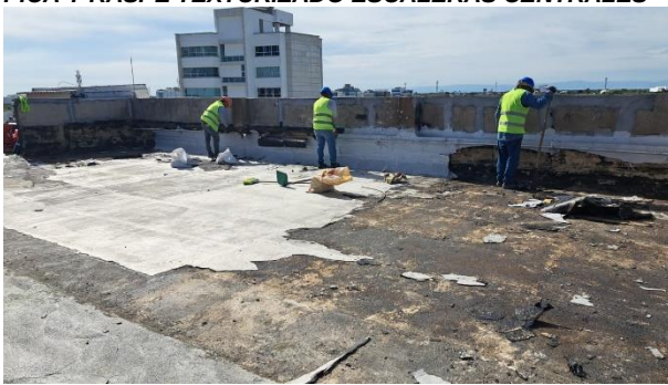
DESMONTE DE MANTO EDIL
