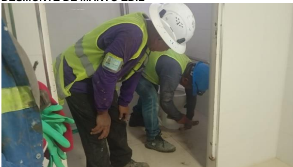
DESMONTE DE APARATOS SANITARIOS
