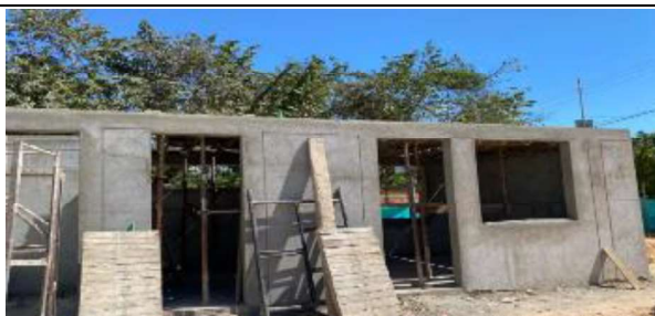
5.09. Filos y goteros en mortero 1:4
