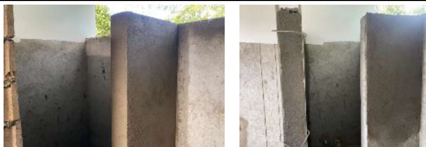
7.07. Divisiones para baños en muro en bloque de cemento de 10cm de espesor
