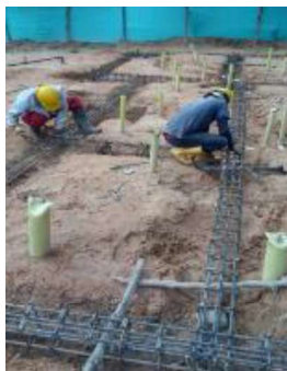
6.04. Red de ventilación PVC-s 2"
