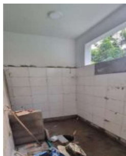
7.08. Enchape para muros en cerámica comercial en baterías sanitarias y cafetería, (cerámica color blanco 30x45cm, tipo macedonia de corona).
