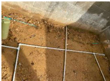
6.14. Suministro e instalación de tubería presión de 1 1/2" rde 21
