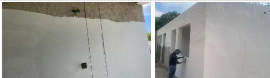
5.07. Puliplast acabo en muro
