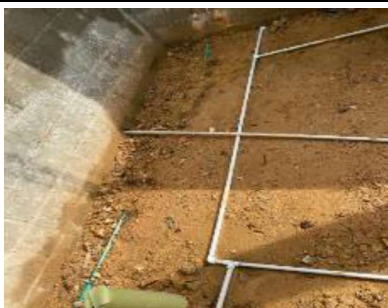
6.14. Suministro e instalación de tubería presión de 1 1/2" rde 21
